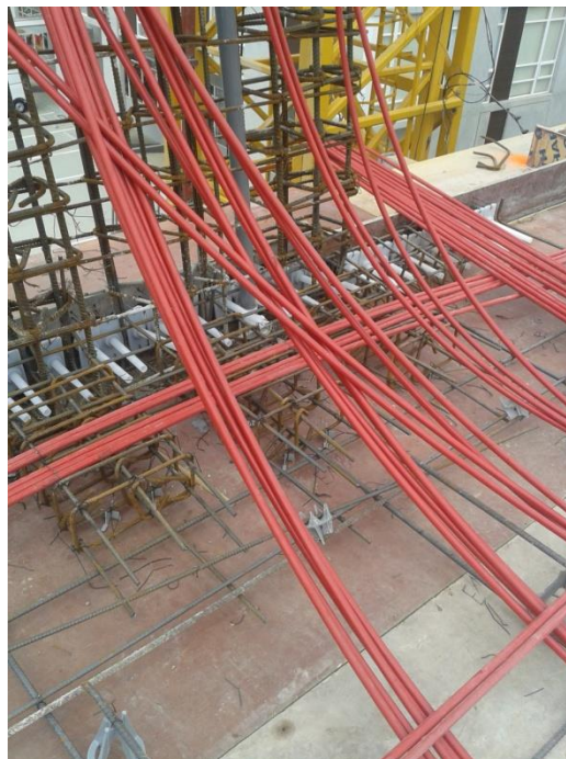
Apéndice D 16. Colocación de cables en anclaje de zona de tensado. Fuente: Imagen propia.
