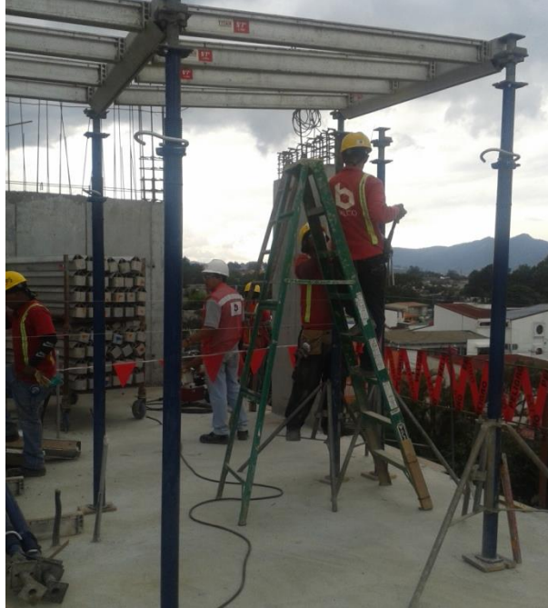
Apéndice D 2. Inicio de colocación de puntales, con base de madera y patas soportantes. Fuente: Imagen propia.
