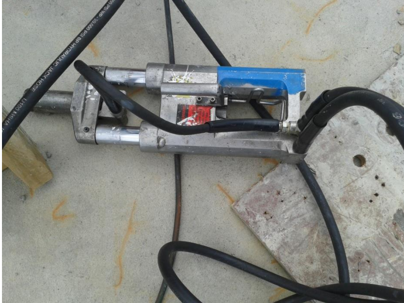
Apéndice D 21. Gato hidráulico para tensar el cable. Fuente: Imagen propia.
