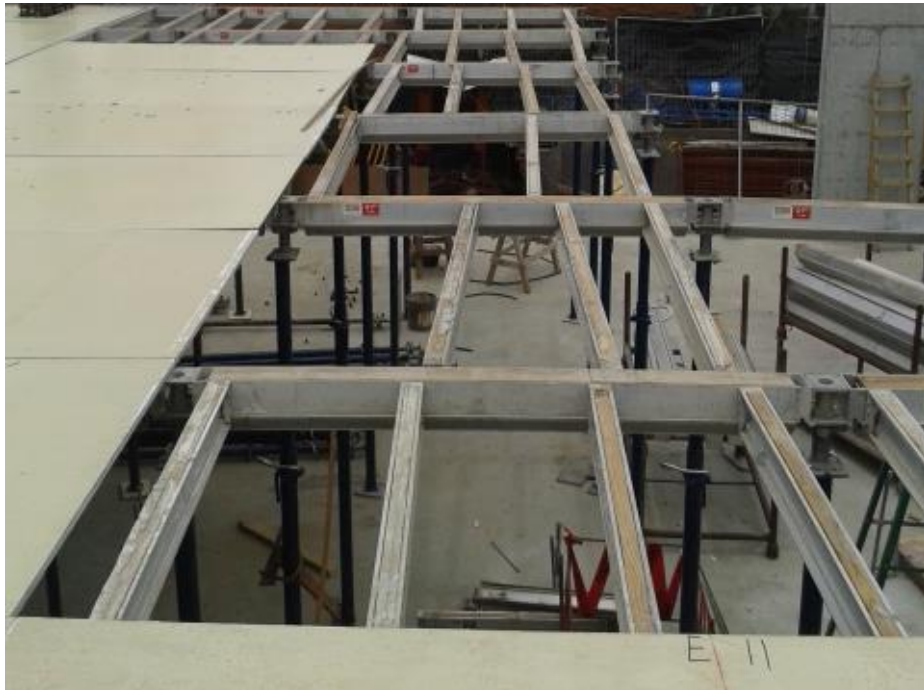
Apéndice D 7. Colocación de formaleta paneles de fondo.
