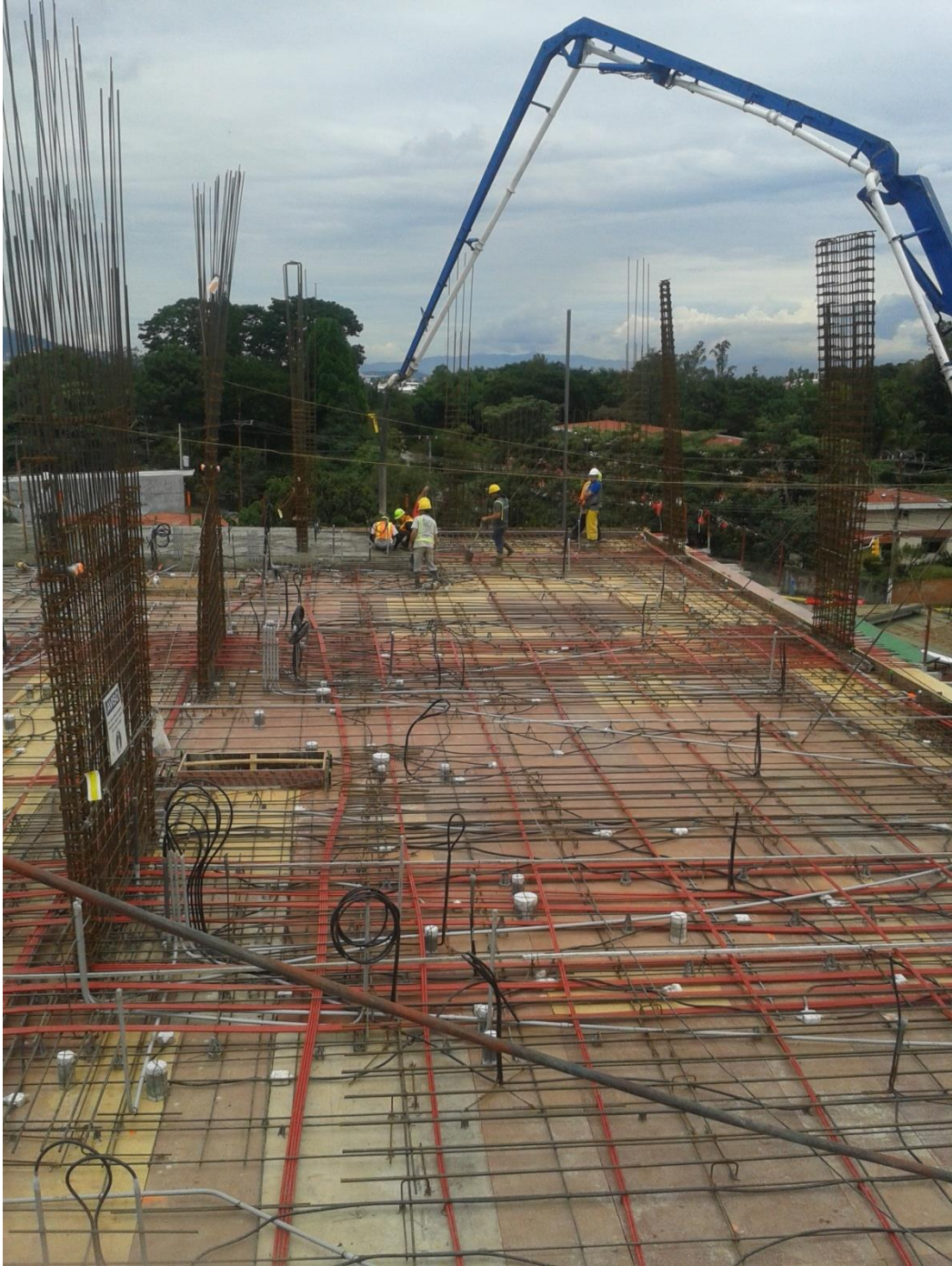
Apéndice D 17. Colocación del concreto en la losa por medio de bomba telescópica.
