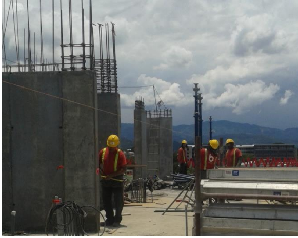
Figura 19. Colocación de guías para los puntales.
