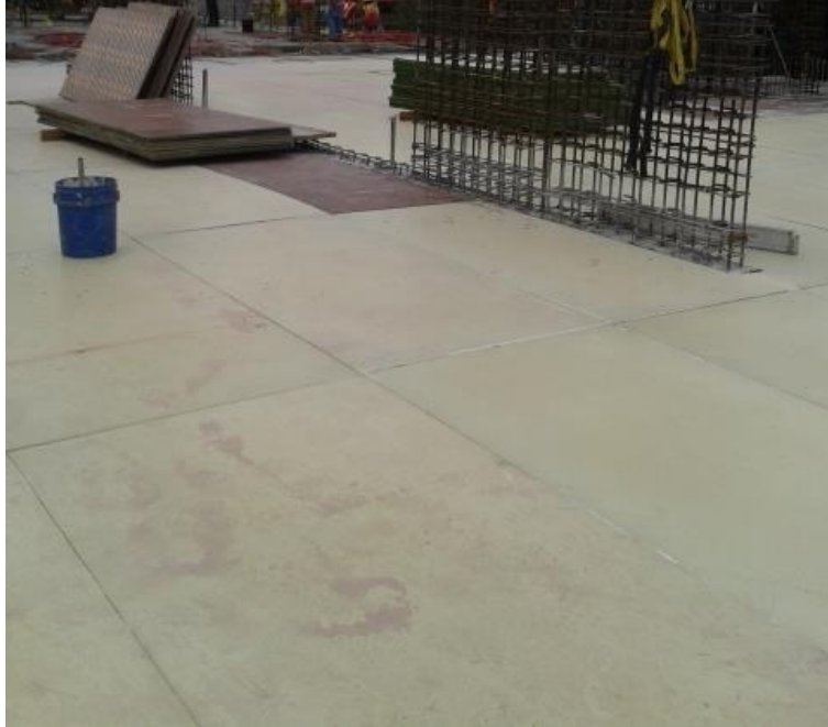
Apéndice D 6. Colocación de formaleta paneles de fondo.
