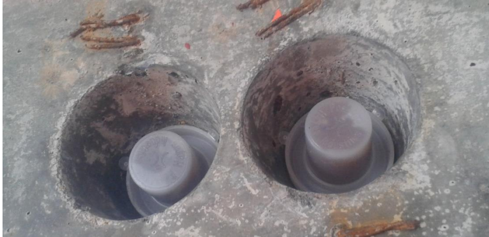
Apéndice D 26. Colocación de tapones con recubrimiento P/T, para el acabado final del cable. Fuente: Imagen propia.
