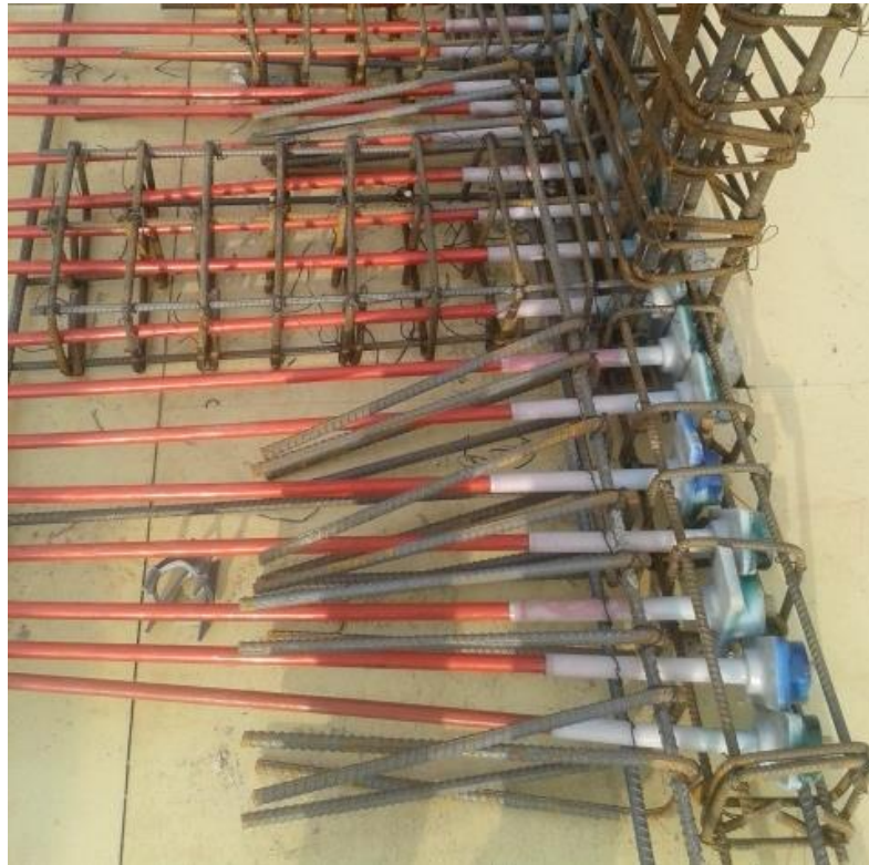
Apéndice D 13. Colocación del anclaje pasivo. Fuente: Imagen propia.
