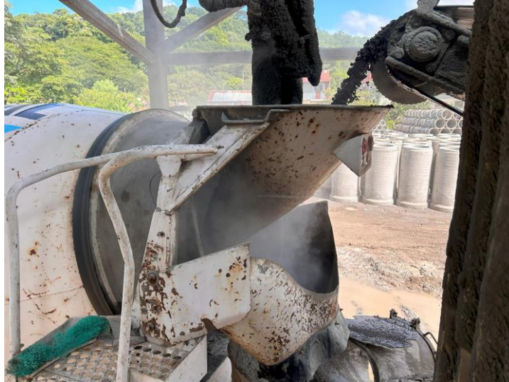
Figura 96. Descarga de material en el camión mezclador
