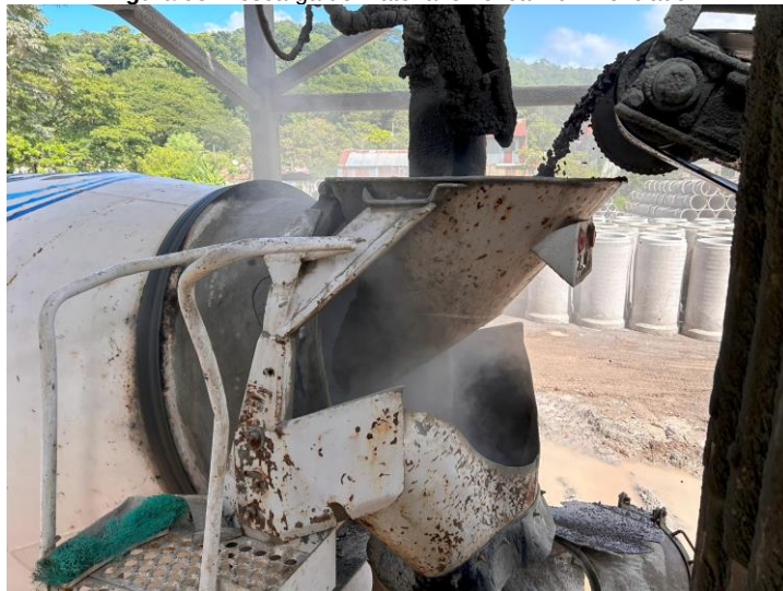
Figura 95. Descarga de material en el camión mezclador
