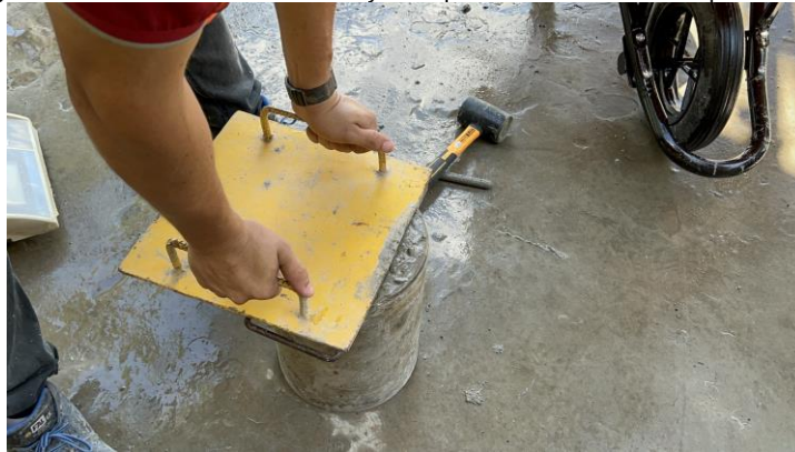
Figura 85. Procedimiento de los ensayos de peso unitario al concreto premezclado
