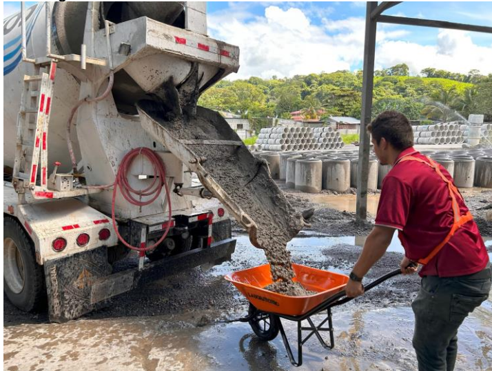
Figura 81. Muestreo de concreto de los camiones mezcladores
