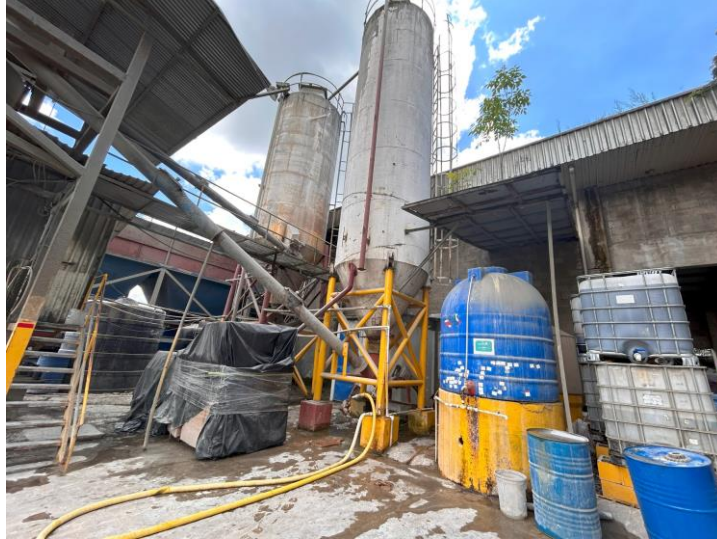
Figura 94. Silos de cemento y almacén de aditivos
