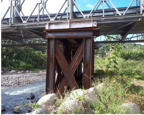
Figura 140. Pilotes de la sección P1 apoyo de los tramo I y II. Fuente: Elaboración propia.
