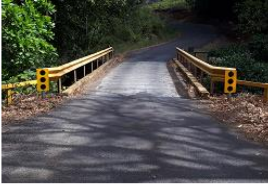
Figura 2. Vista a lo largo de la línea de centro puente Maravilla-Río San José.
