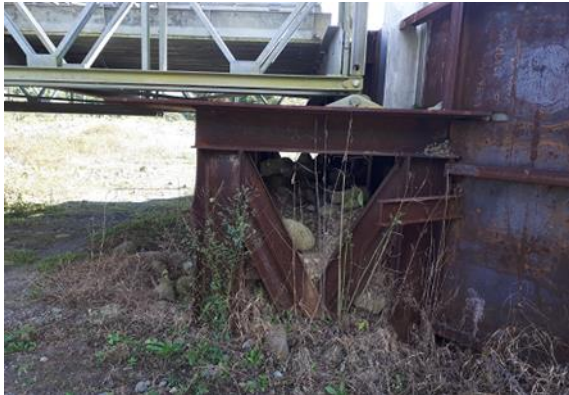
Figura 141. Bastión 1, pilotes hincados y apoyo de rodillo. Fuente: Elaboración propia.
