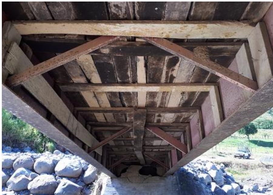
Figura 3. Vista inferior del puente San Pedro-Río Chiquito.
