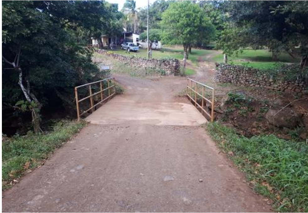
Figura 2. Vista a lo largo de la línea de centro puente Cabuyo-Río Cabuyo.
