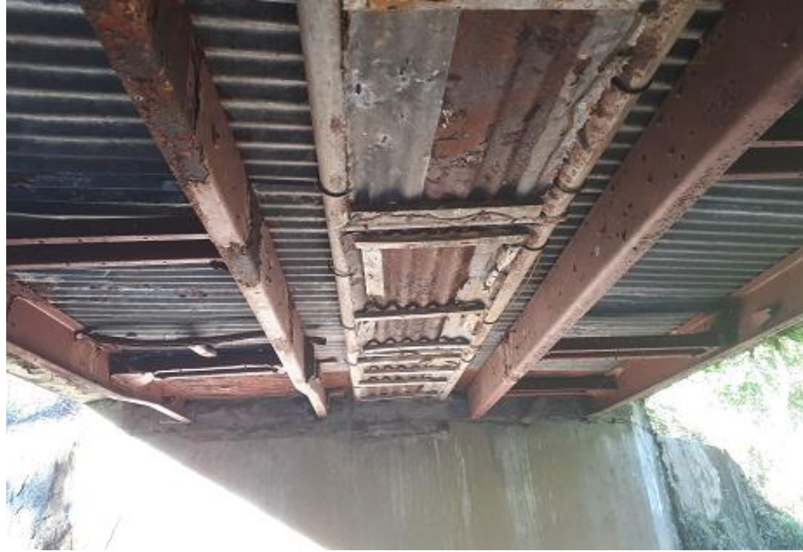
Figura 6. No se observa la sección inferior de la losa de concreto por la formaleta.
