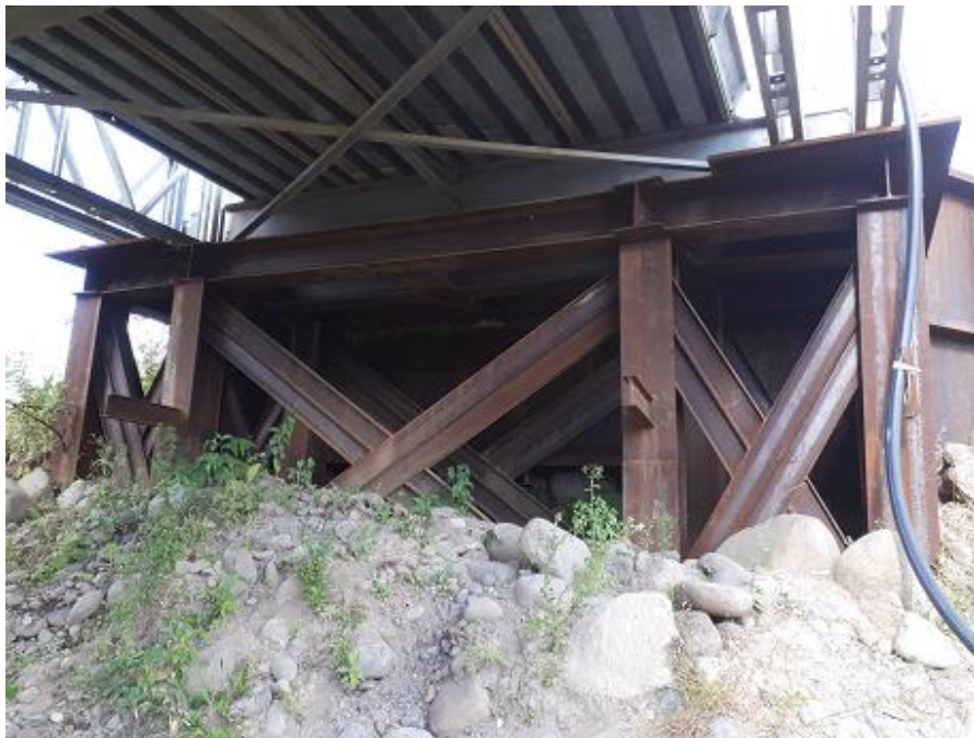
Figura 5. Se observa sistema de pilotes hincados con vigas de acero tipo H.
