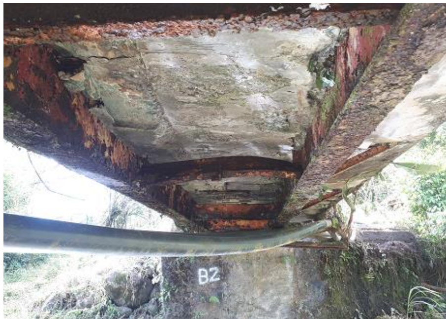
Figura 3. Vista inferior del puente Pedro Soto-Río Piedras.
