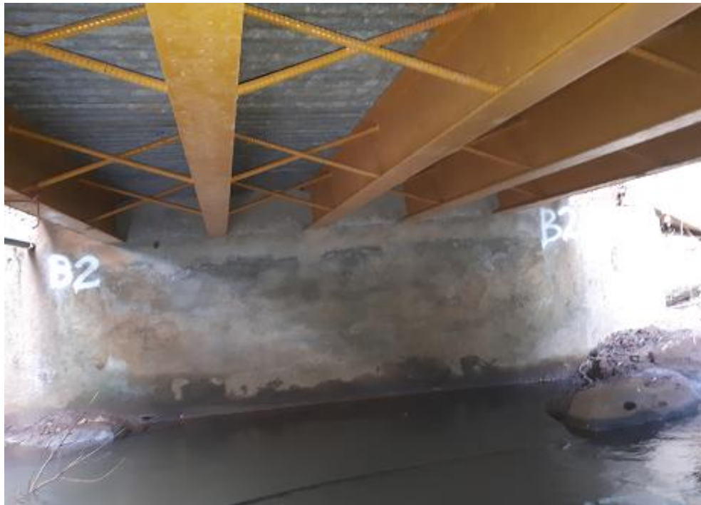
Figura 3. Vista inferior del puente Cabuyo-Río Cabuyo.
