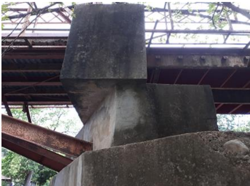
Figura 128. Vista lateral de la configuración irregular de bloques de concreto de la pila P1. Fuente: Elaboración propia.
