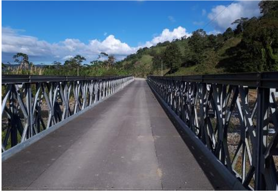
Figura 2. Vista a lo largo de la línea de centro puente Viejo Arenal-Río Chiquito.
