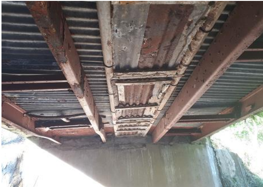
Figura 3. Vista inferior del puente Las Pavas-Río Paniagua.
