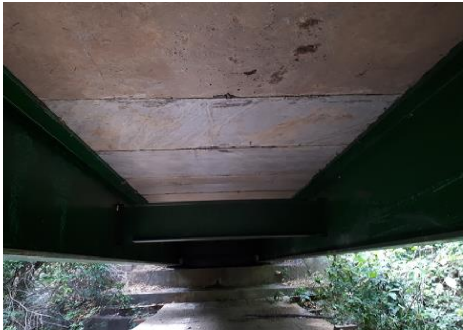
Figura 3. Vista inferior del puente Maravilla-Río San José.
