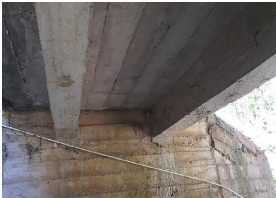
Figura 3. Vista inferior del puente Cañitas-Río Cañitas.
