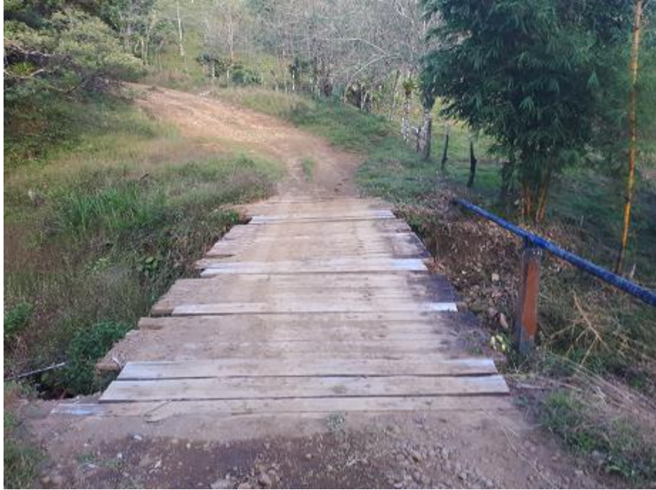
Figura 2. Vista a lo largo de la línea de centro puente Asentamiento Sibaja-Río Dos Bocas.
