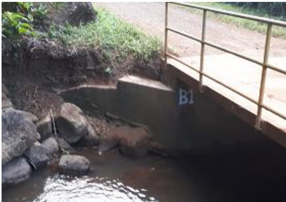
Figura 11. Aletón observado sin grietas ni socavación.
