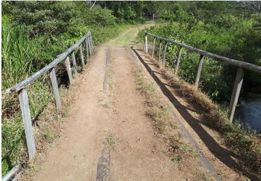
Figura 2. Vista a lo largo de la línea de centro puente Pedro Soto-Río Piedras.
