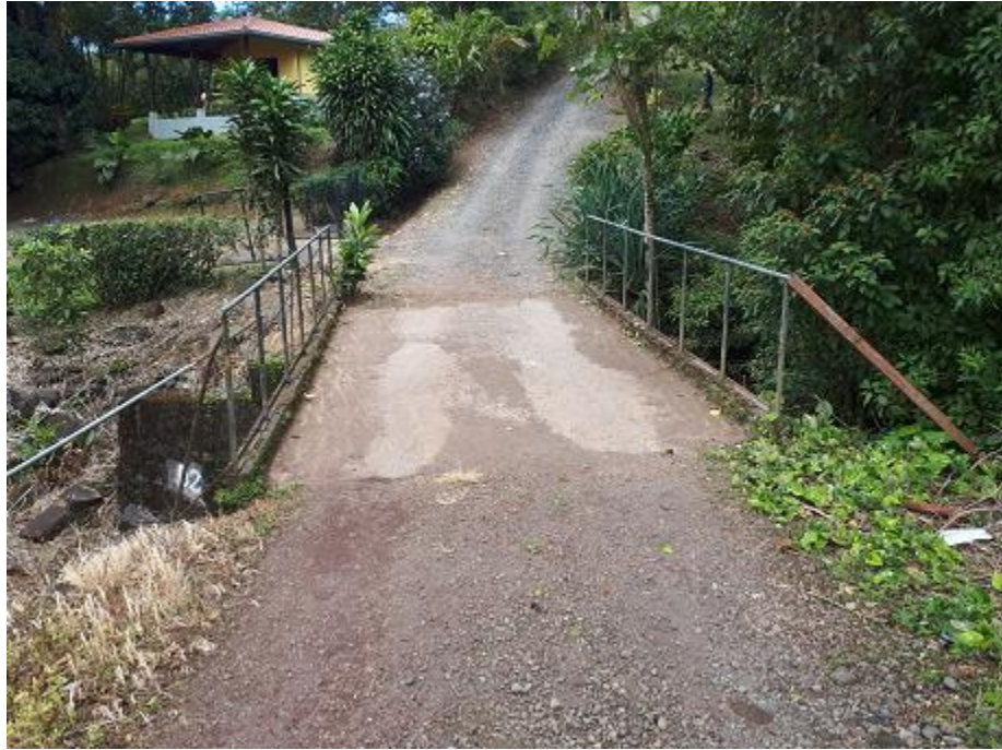
Figura 2. Vista a lo largo de la línea de centro puente La Palma-Río Aguacate.
