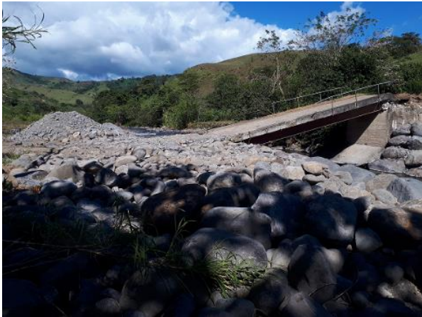
Figura 146. Relleno de aproximación realizado después del desbordamiento del río Chiquito. Fuente: Elaboración propia.
