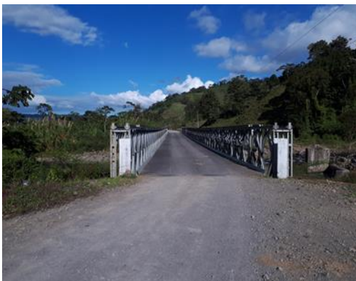
Figura 142. Falta de guarda vías en los accesos al puente Viejo Arenal. Fuente: Elaboración propia.
