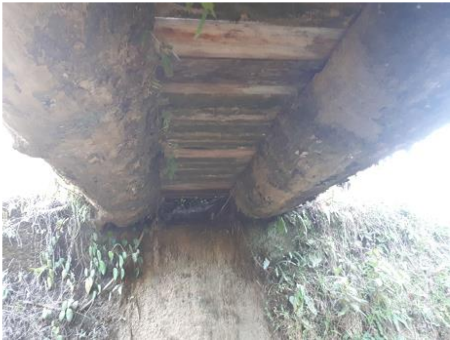
Figura 3. Vista inferior del puente Asentamiento Sibaja-Río Dos Bocas.
