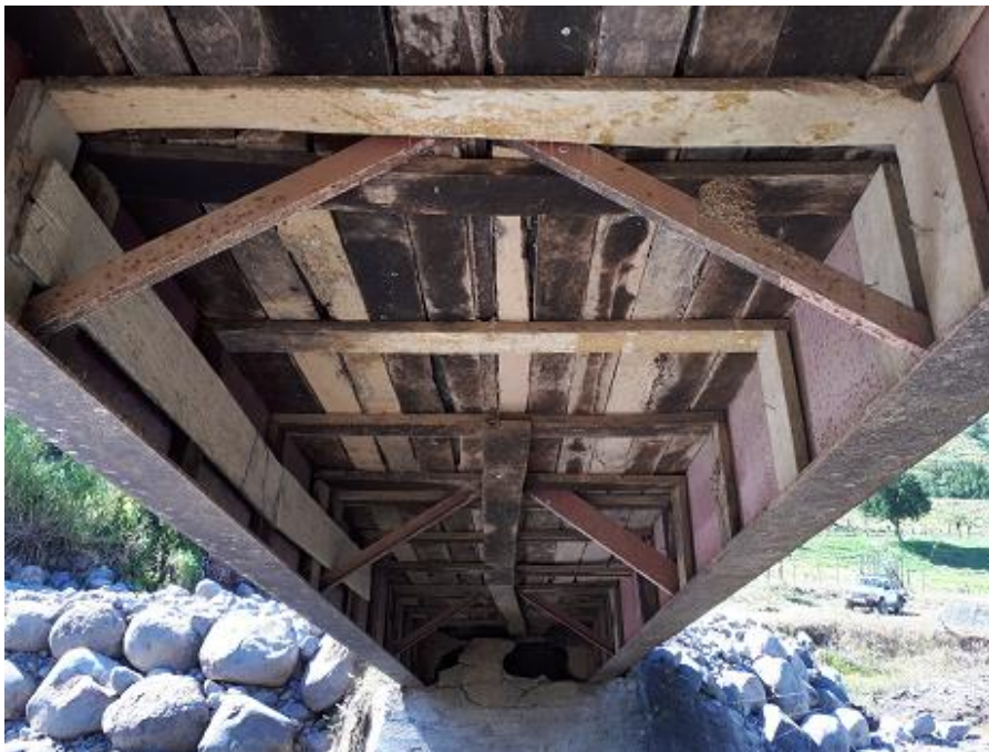
Figura 11. Sección inferior del puente con formaleta de construcción.
