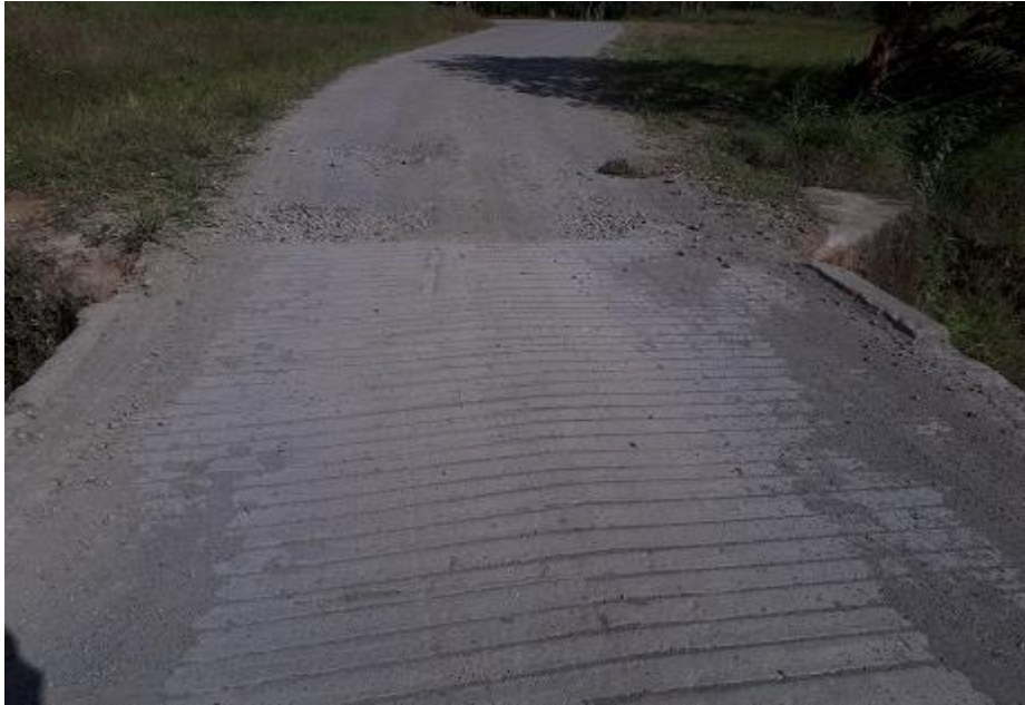
Figura 2. Vista a lo largo de la línea de centro puente Las Minas-Quebrada San Martín.
