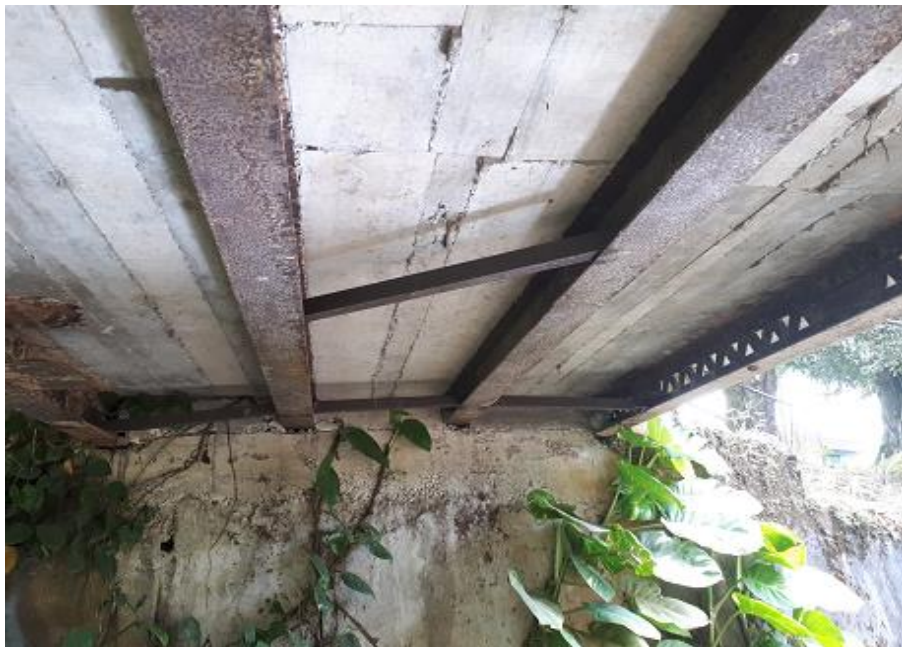
Figura 3. Vista inferior del puente La Palma-Río Aguacate.
