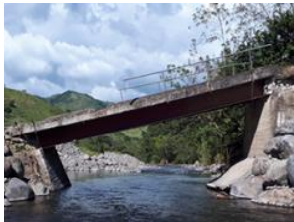
Figura 144. Vista lateral del puente San Pedro. Fuente: Elaboración propia.
