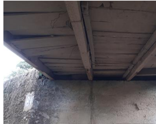
Figura 91. No se pudo observar la parte inferior porque la formaleta no ha sido removida. Fuente: Elaboración propia.
