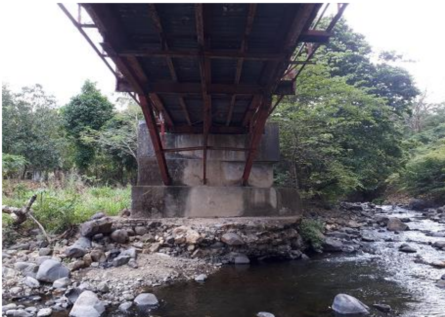
Figura 3. Vista inferior del puente San José-Río San José.
