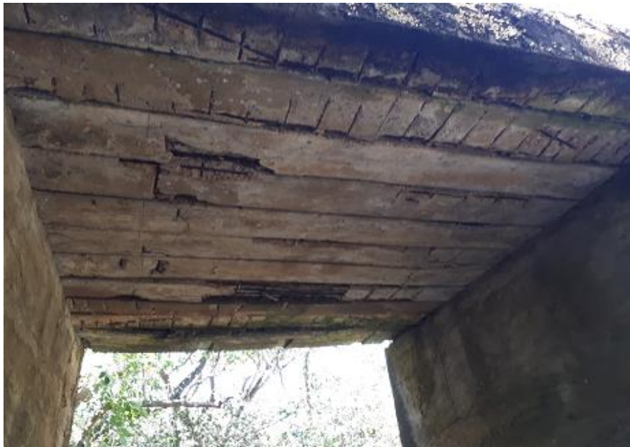
Figura 3. Vista inferior del puente Las Vueltas-Quebrada Las Vueltas.
