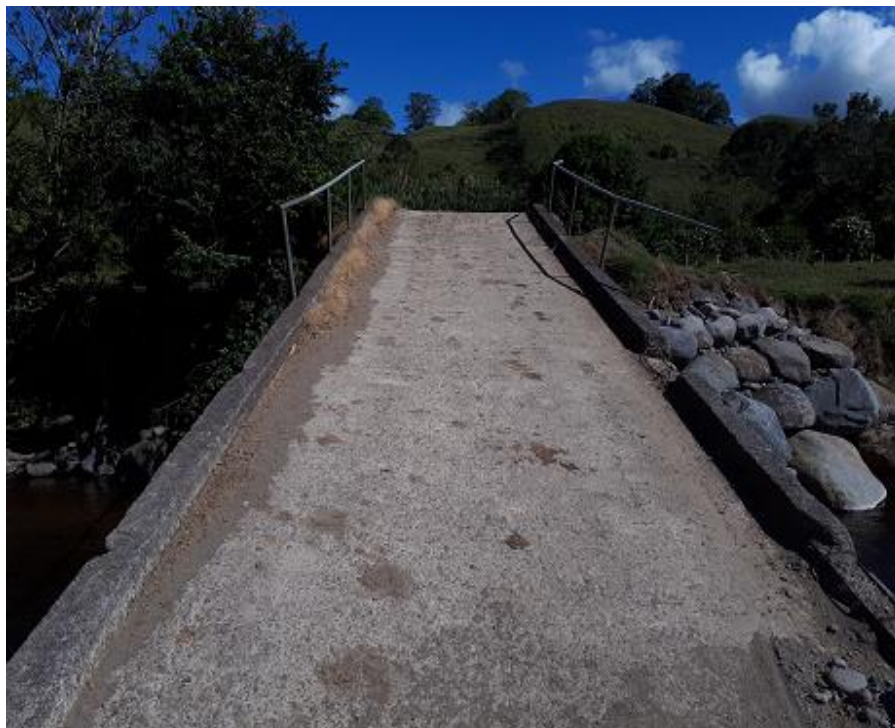
Figura 9. Debido a la pendiente longitudinal tan pronunciada no se observa el tráfico entrando al puente de frente.
