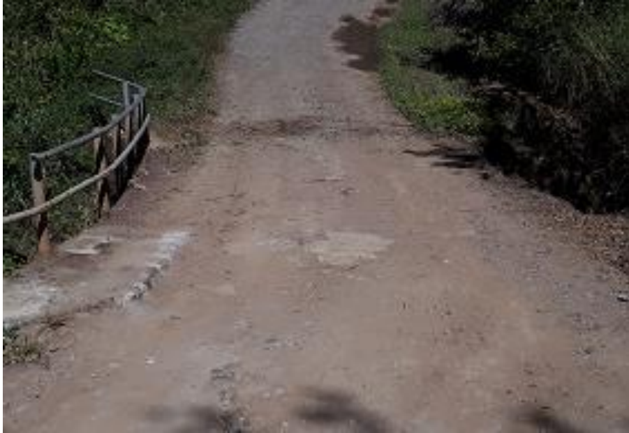
Figura 2. Vista a lo largo de la línea de centro puente Las Vueltas-Quebrada Las Vueltas.
