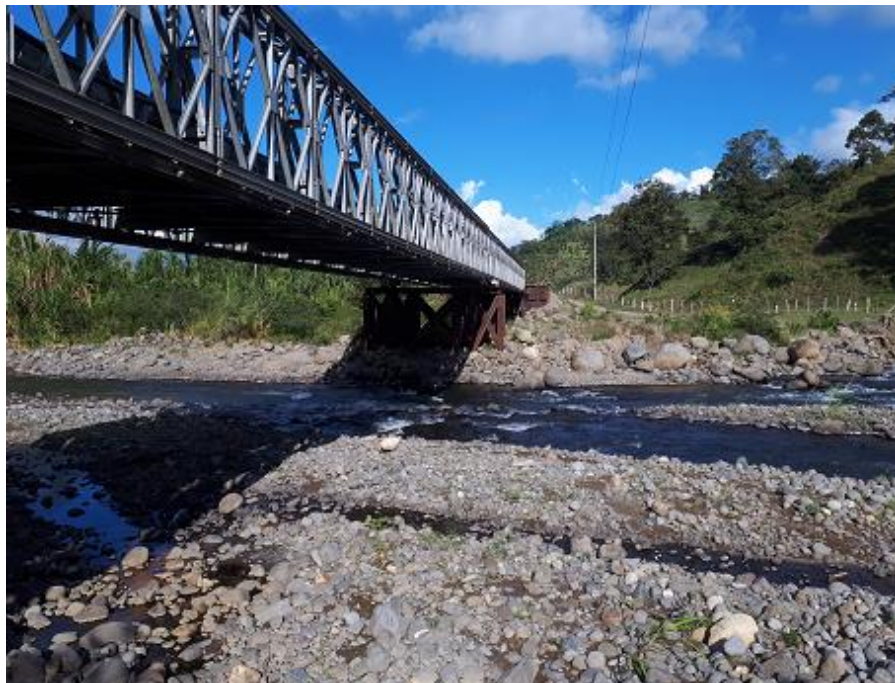
Figura 11. Material acumulado en el cauce del río que divide el flujo de agua.
