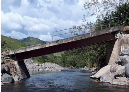
Figura 130. Superestructura con aproximadamente 20% de pendiente.
