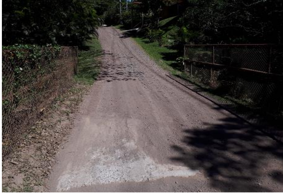
Figura 2. Vista a lo largo de la línea de centro puente Cañitas-Río Cañitas.
