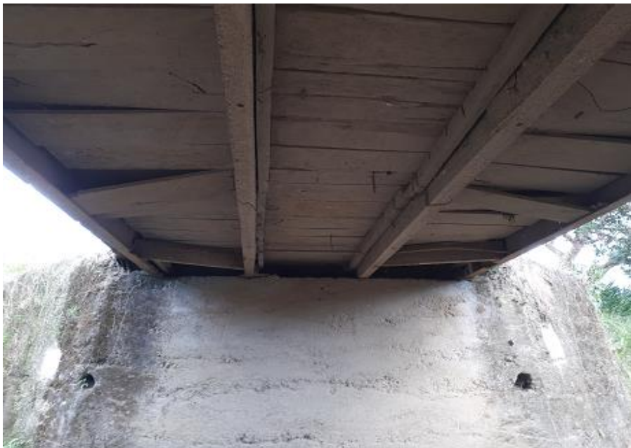
Figura 3. Vista inferior del puente Las Minas-Quebrada San Martín.
