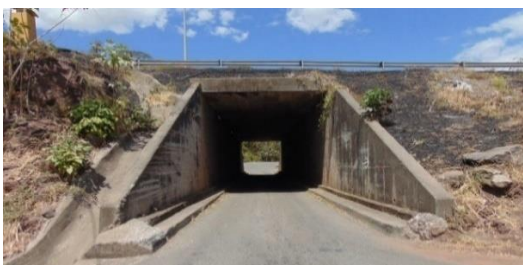
Figura 1. Vista lateral de la Alcantarilla (Paso superior). Fuente: (SAEP, 2021).
