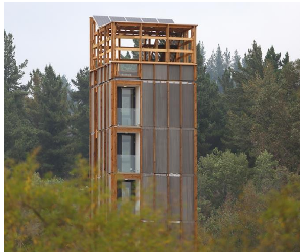
Figura 2.4. Edificaciones construidas con madera como principal material.
