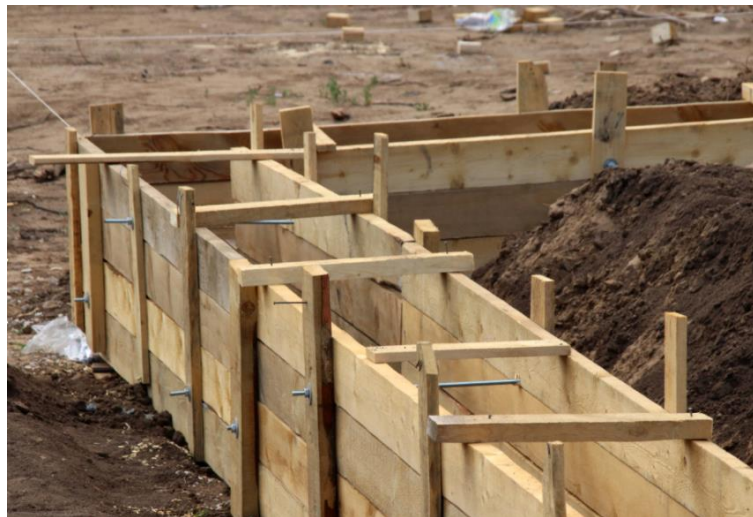
Figura 2.1. Madera de uso temporal en encofrado.
