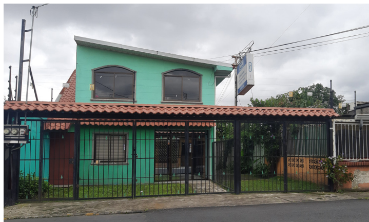
Imagen 56. Edificación con antejardín en buen estado.
