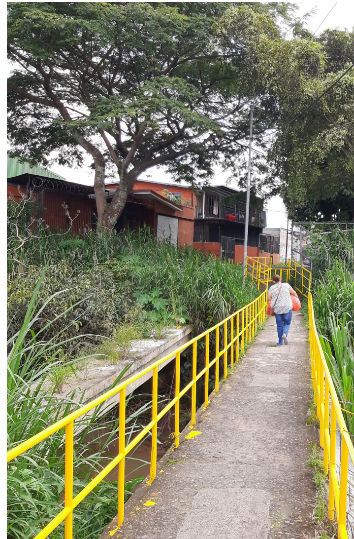
Imagen 190. Paso sobre el río Damas, estado actual.
