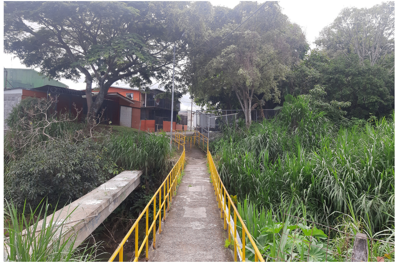
Imagen 58. Puente peatonal sobre Río Damas. Vegetación abundante.
