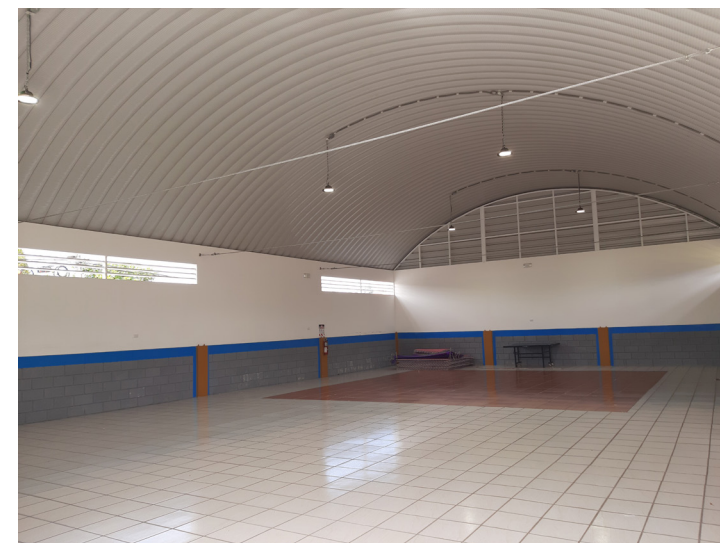
Imagen 34. Gimnasio de tenis de mesa con cubierta curva y zócalo de mampostería.
