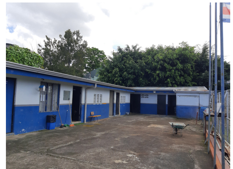
Imagen 35. Espacio de camerinos y servicios sanitarios desde el exterior.
