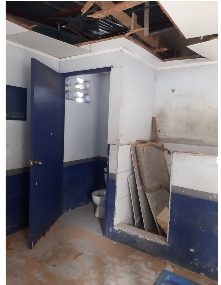
Imagen 33. Área interna de camerinos de hombres y servicio sanitario.
