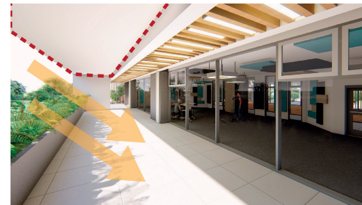
Imagen 173. Aleros y ventanales de aulas.
