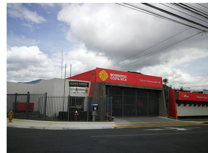
Imagen 40. Estación de Bomberos de Desamparados.
