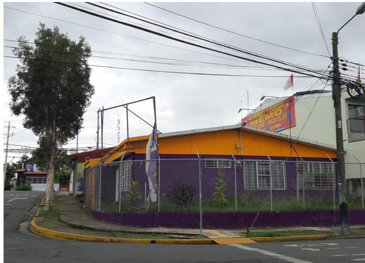
Imagen 54. Edificación con antejardín en mal estado.
