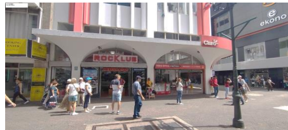
Locales comerciales en fachada sur
