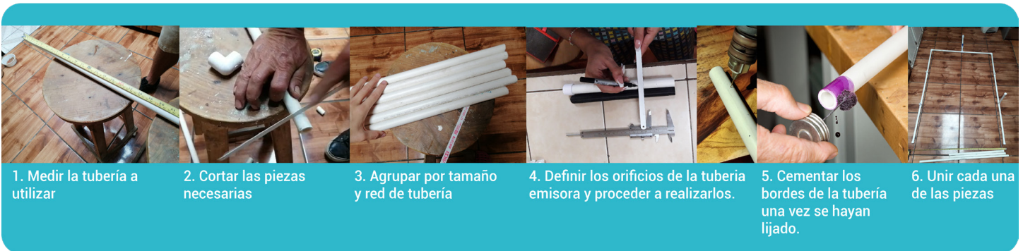
Figura 82. Resumen construcción Prototipo Aqua. Fuente: Elaboración Propia
