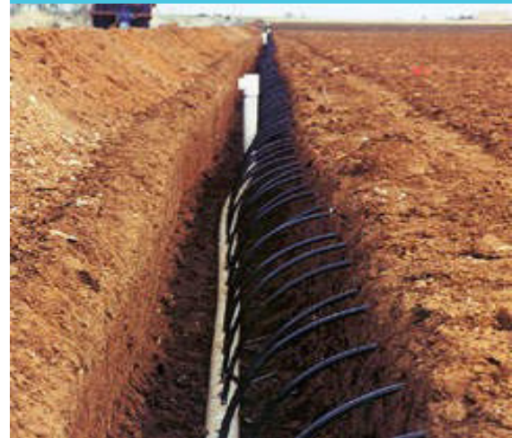
Figura 11. Riego por goteo subterráneo. Fuente: vitivinicultura.net
