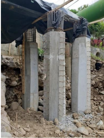
Fotografía 10. Pilotes colados sobre nivel de terreno en Bastión 1.
