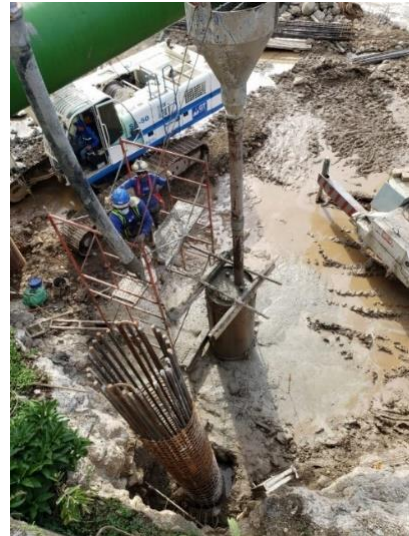
Fotografía 32. Construcción primera etapa de pilotes.
