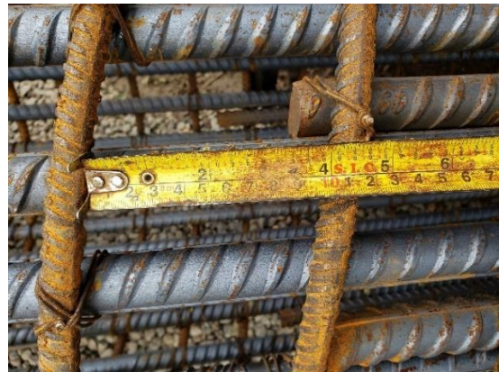
Fotografía 38. Verificación en campo de espaciado en aro circular continuo de pilotes.
