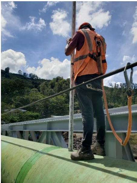
Fotografía 29. Medición topográfica de la tubería y puente.
