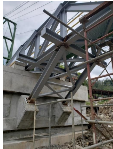
Fotografía 26. Instalación de puntales de anclaje W10X45 Bastón 1.
