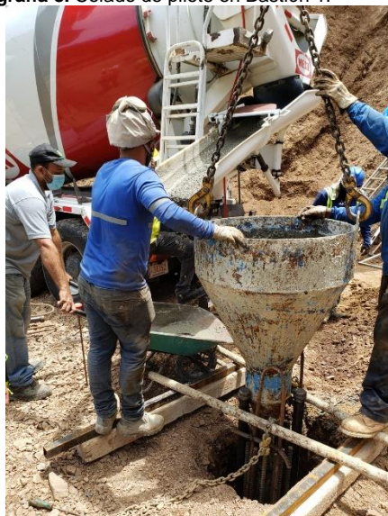
Fotografía 9. Colado de pilote en Bastión 2.
