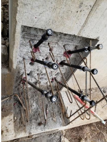
Fotografía 36. Instalación de anclajes en Bastión 2.
