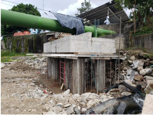
Fotografía 16. Construcción de viga Cabezal Bastión 1.
