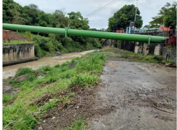
Fotografía 31. Zona de trabajo en Bastión 1 previo a la intervención.
