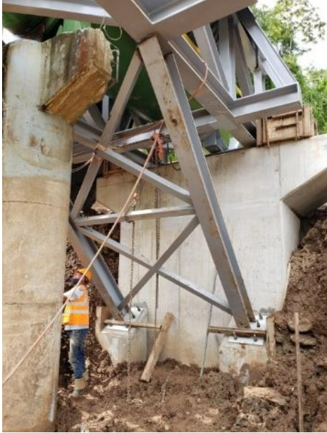
Fotografía 27. Instalación de puntales de anclaje W10X45 Bastón 2.
