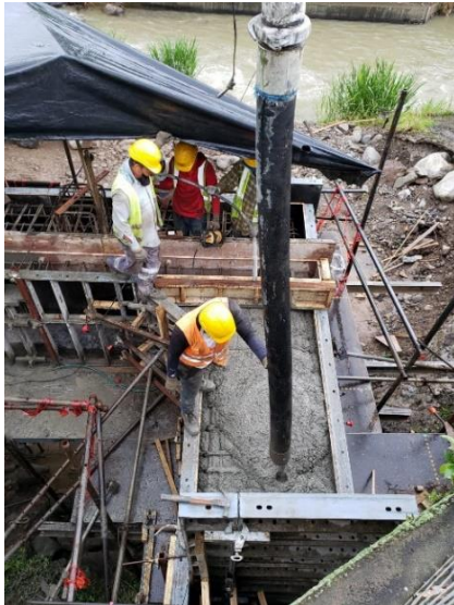
Fotografía 14. Colado de Bastión 1 con bomba telescópica.
