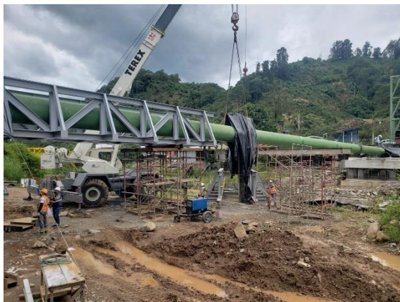
Fotografía 23. Montaje de tramo D.
