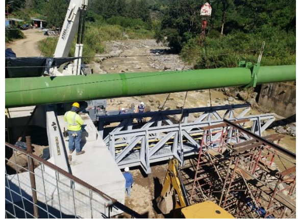
Fotografía 24. Montaje del tramo A.
