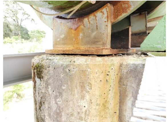
Fotografía 30. Placa de apoyo temporal a cortar sobre columna "C" a demoler.
