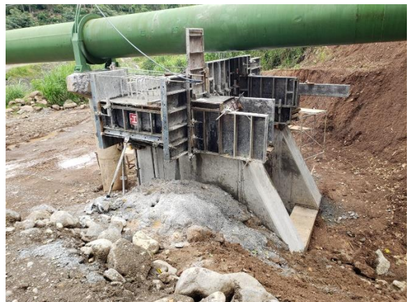
Fotografía 21. Construcción de cuerpo y aletones Bastión 2 (Parte Superior).
