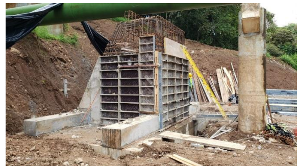
Fotografía 20. Construcción de cuerpo y aletones Bastión 2 (Parte inferior).
