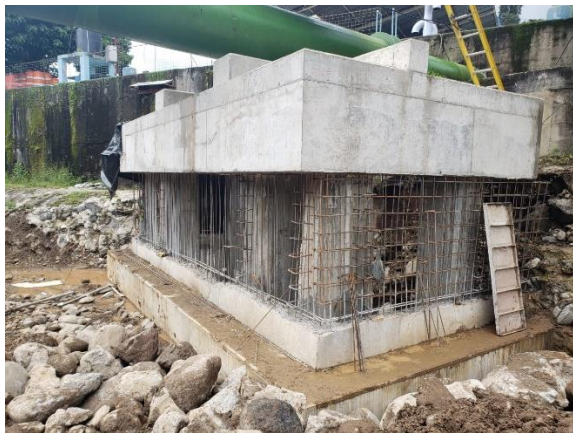
Fotografía 17. Construcción de viga inferior de fundación Bastión 1.
