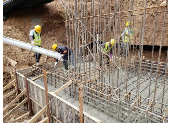
Fotografía 19. Colado de placa de fundación Bastión 2.
