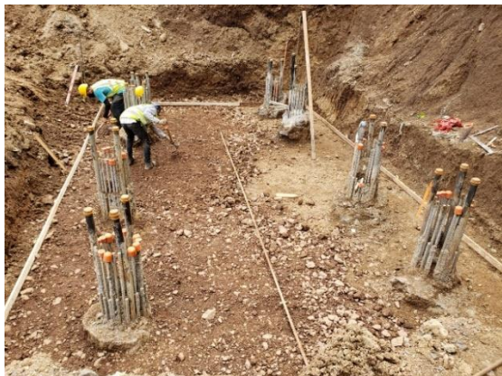
Fotografía 12. Preparación de zona de trabajo Bastión 1.
