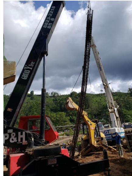
Fotografía 7. Izado de armadura de pilote.
