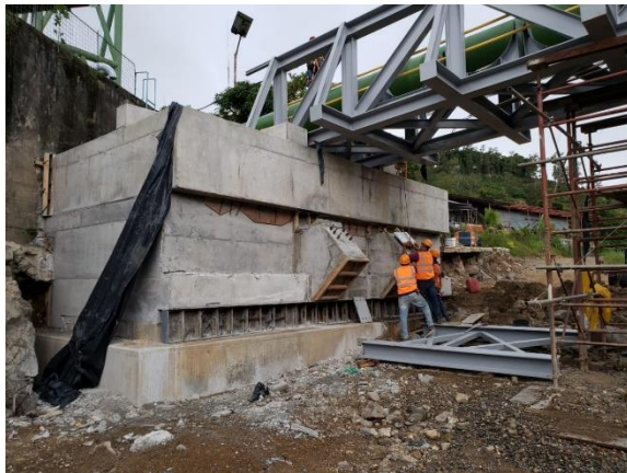
Fotografía 18. Construcción de muro pantalla, ménsulas y viga intermedia Bastión 1.
