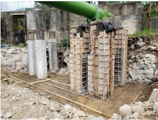
Fotografía 11. Replanteo de Bastión 1.
