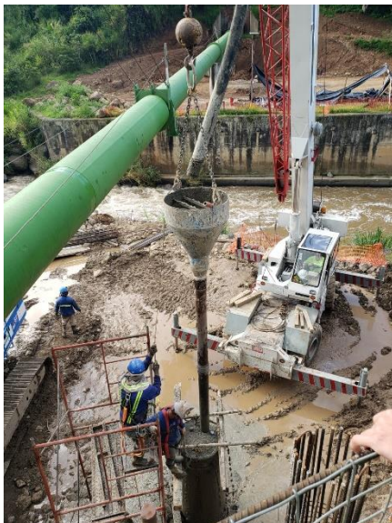
Fotografía 8. Colado de pilote en Bastión 1.
