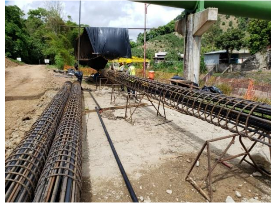
Fotografía 4. Armado de pilotes Bastión 2.
