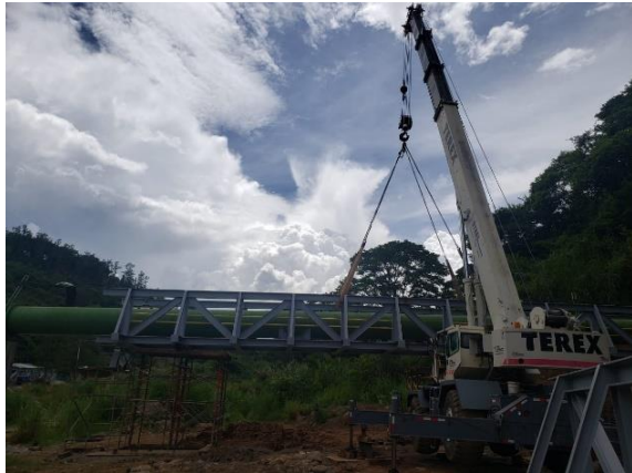
Fotografía 22. Montaje de tramos E y F.
