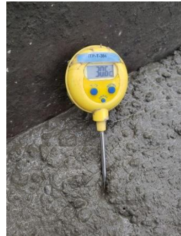
Fotografía 44. Temperatura del concreto fresco en Pilote 1 (30,6°C).
