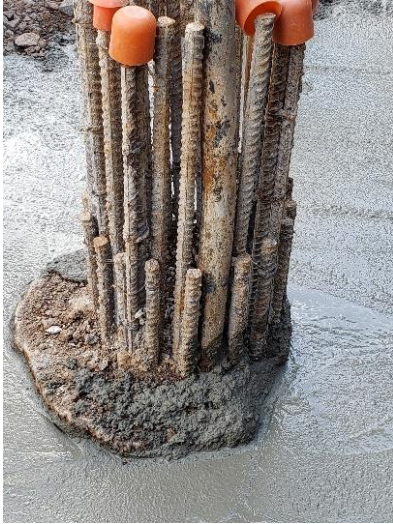
Fotografía 40. Traslapes para confección de anclaje y dobléz a 90°.
