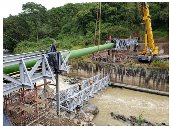
Fotografía 25. Montaje de los tramos B y C.
