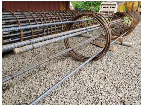
Fotografía 5. Armado de pilotes Bastión 1.
