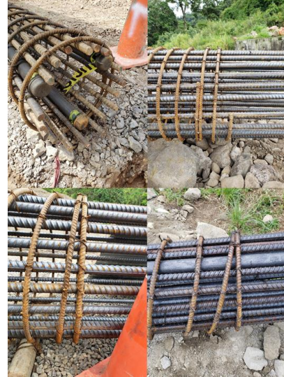
Fotografía 39. Anclaje de aros circulares continuos de pilotes en campo.
