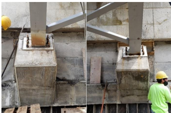
Fotografía 37. Posición de ménsulas respecto a los puntales del puente en Bastión 1.
