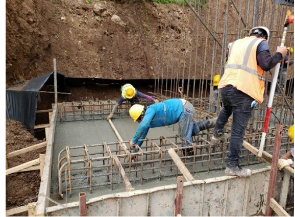
Fotografía 15. Acabado final a placa de Bastión 2.
