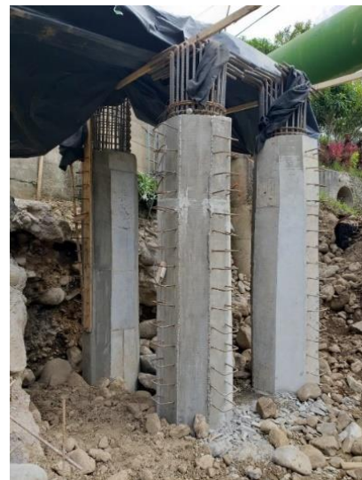
Fotografía 33. Construcción de segunda etapa de pilotes (solo Bastión 1).
