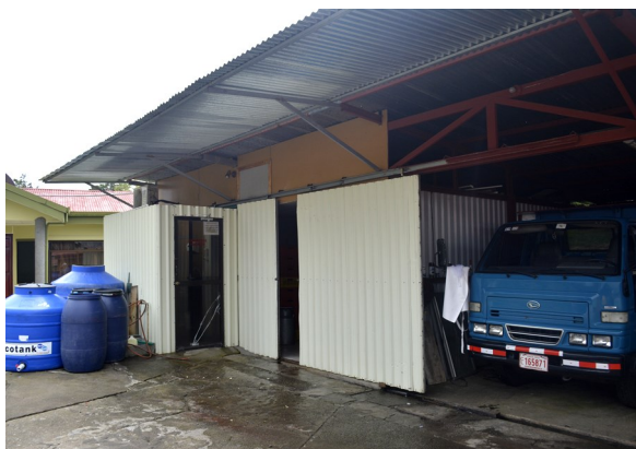
20. Vista exterior de la quesera.
