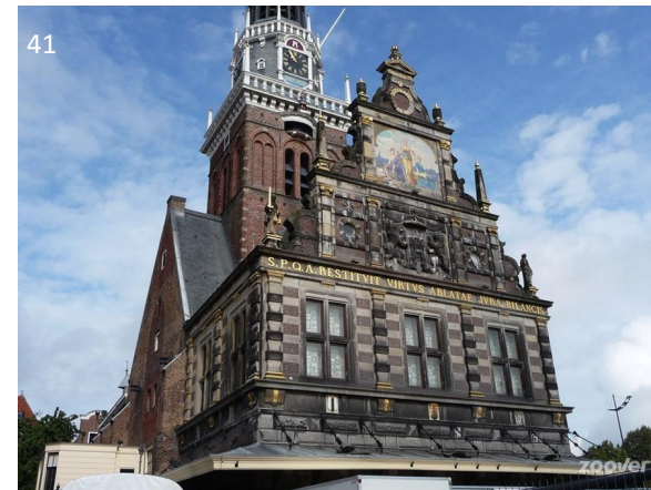
Exterior: Fachada principal.
