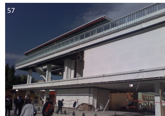
Imagen del proceso de construcción del edificio.
