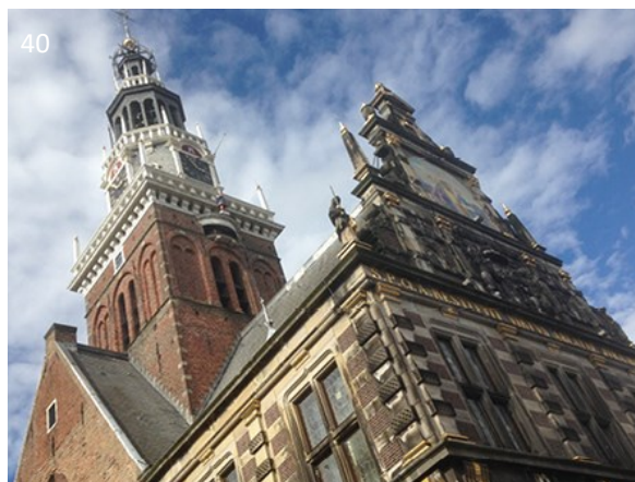
Exterior: Fachada principal y el antiguo campanario.
