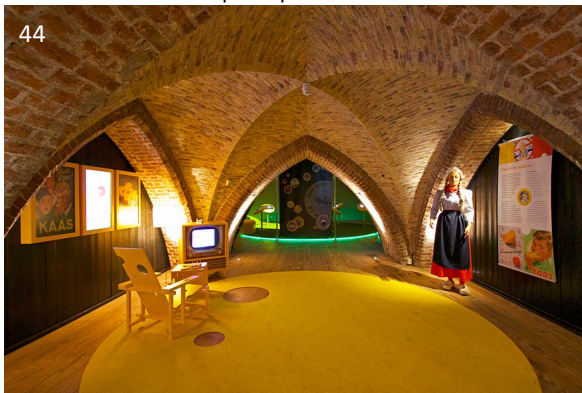
Interior: bóvedas de crucería.
