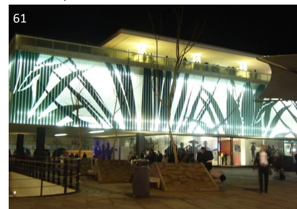
Detalle de iluminación artificial del edificio.
