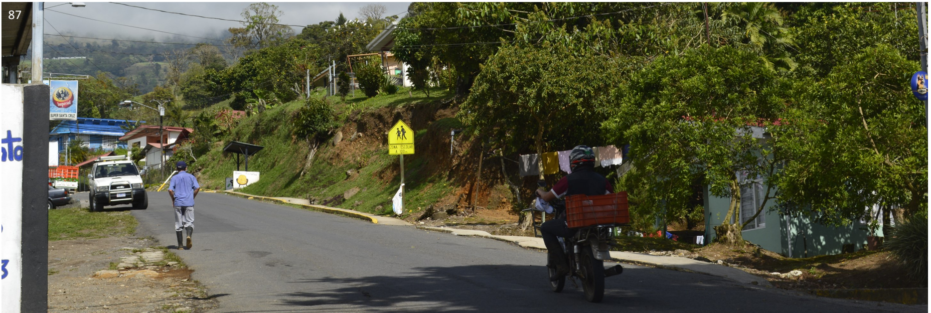
1. Vía principal (ruta 230), a la izquierda se puede apreciar la ausencia de aceras mientras que a la derecha la acera presenta varios desniveles y es muy estrecha.
