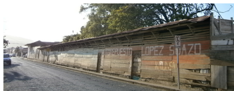
IMAGEN 89 - CALLE SUR AL LOTE
