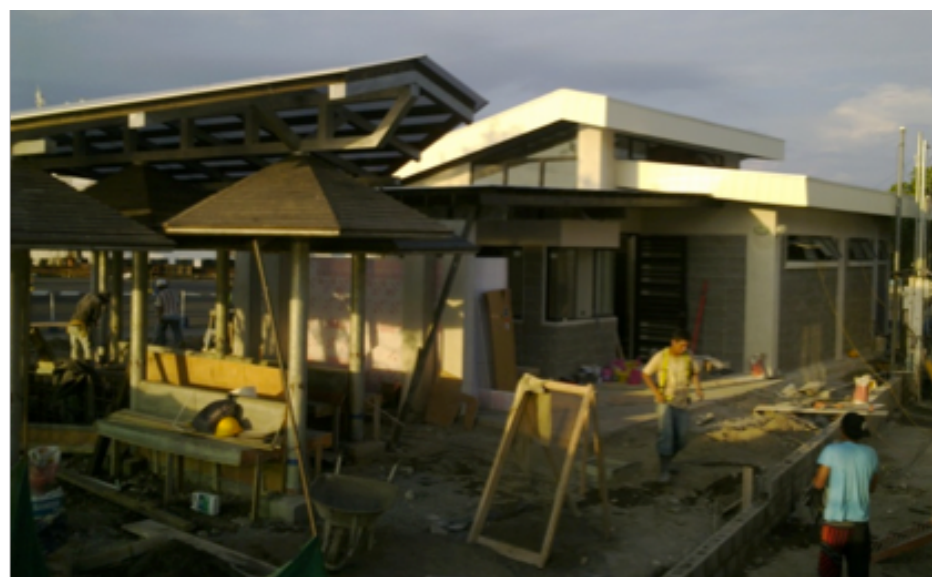
Figura 12. Construcción de la terminal de Transbordadores. Fuente: Kohkemper, Silvia, 2012.
