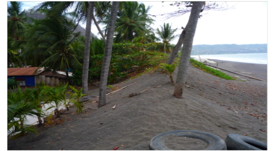
Figura 59. Vivienda en Caldera susceptible al aumento del nivel del mar. Fuente: El autor, 2012.
