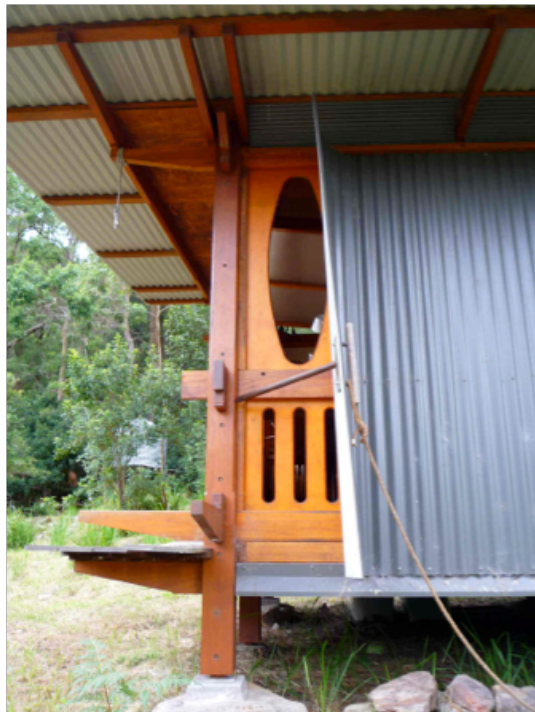
Figura 28. Construcción sobre pilotes, con materiales de baja energía embebida y con sistemas constructivos desarmables. Fuente: El autor, 2012.
