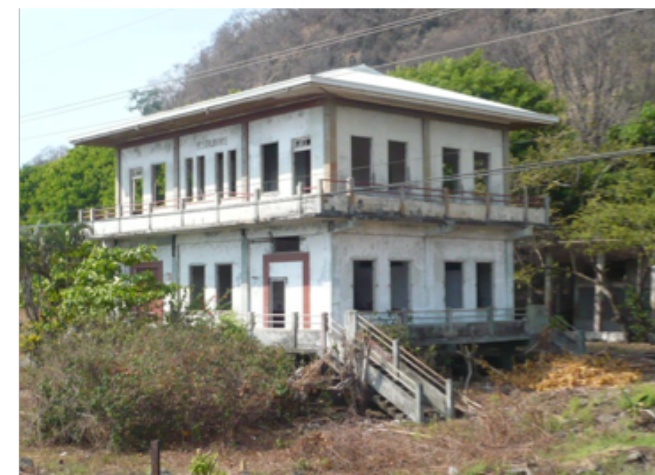
Figura 20. Estación del tren en Caldera. Fuente: El autor, 2012.
