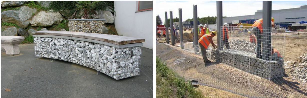
EJEMPLO DE ESTRUCTURA Y DISEÑO EN GAVIONES
