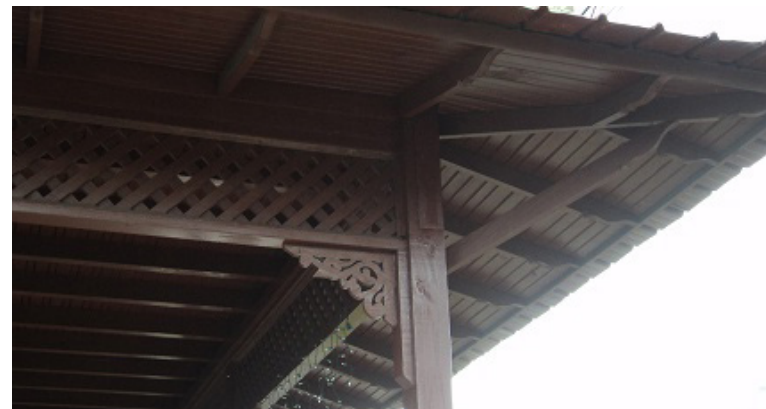
Imagen 22. Tornapunta decorativo entre la columna y la viga de madera
