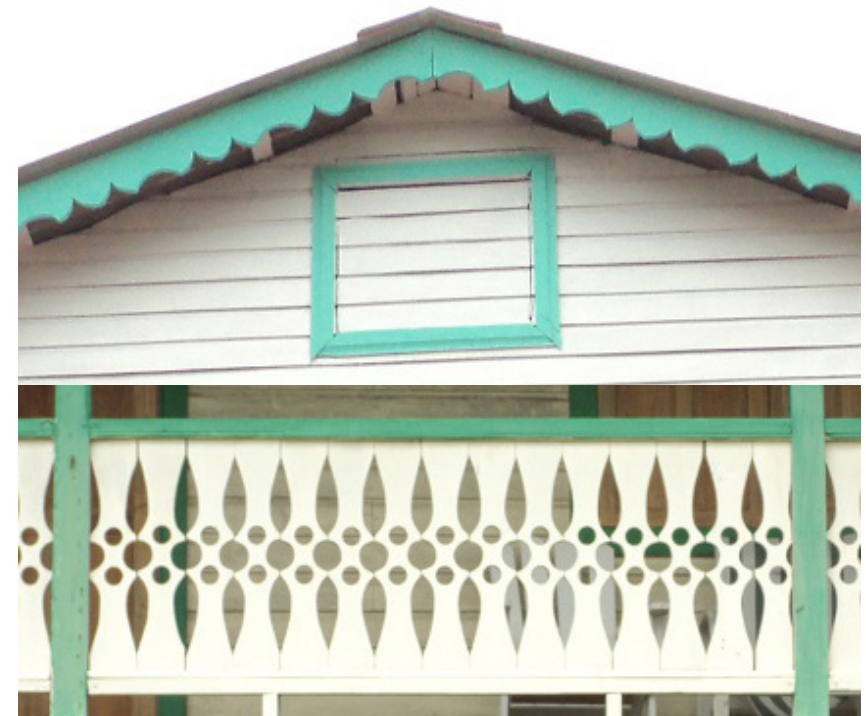
Imagen 23. Buhardillas y Balcón con baranda construida de madera.
