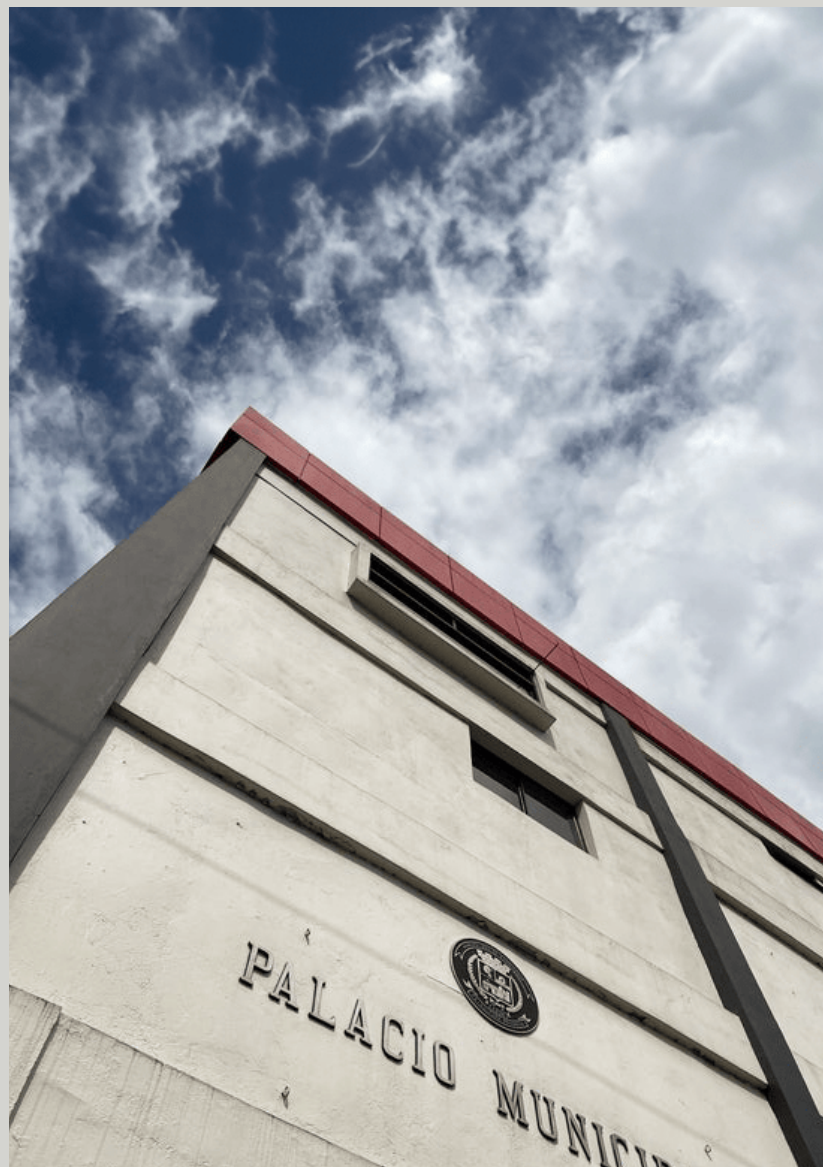
Figura 1 Edificio de la Municipalidad de Curridabat (El Mundo.CR, 2022).
