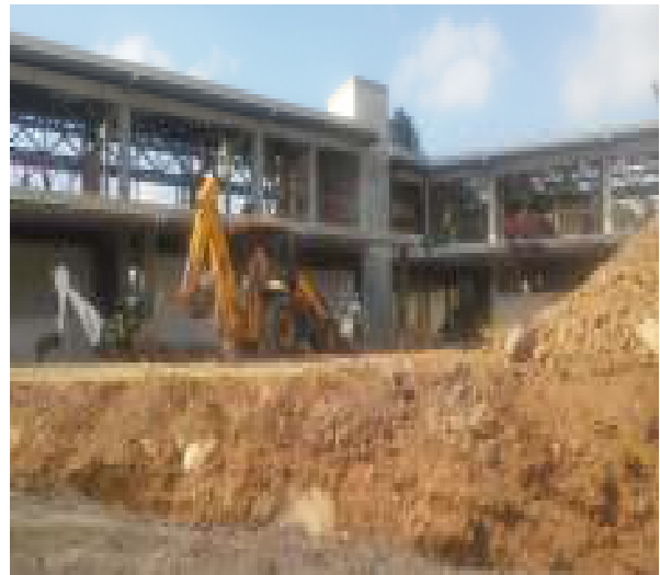
Figura 4. Fachada del edificio al mes de marzo del 2016
