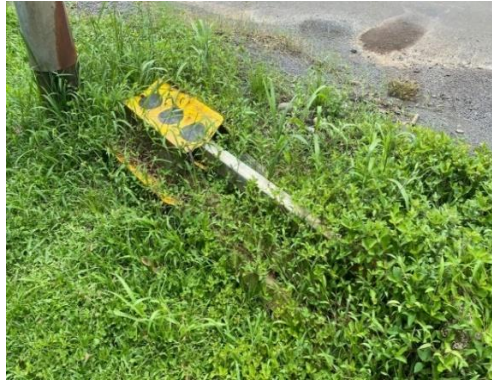
Figura 16. Falta de mantenimiento en señales verticales sobre el recorrido de la ruta..
