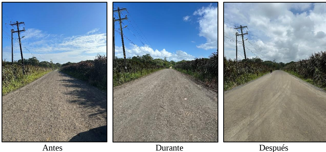
Figura 30, 31, 32. Etapas constructivas antes durante y después de la colocación de RAP.
