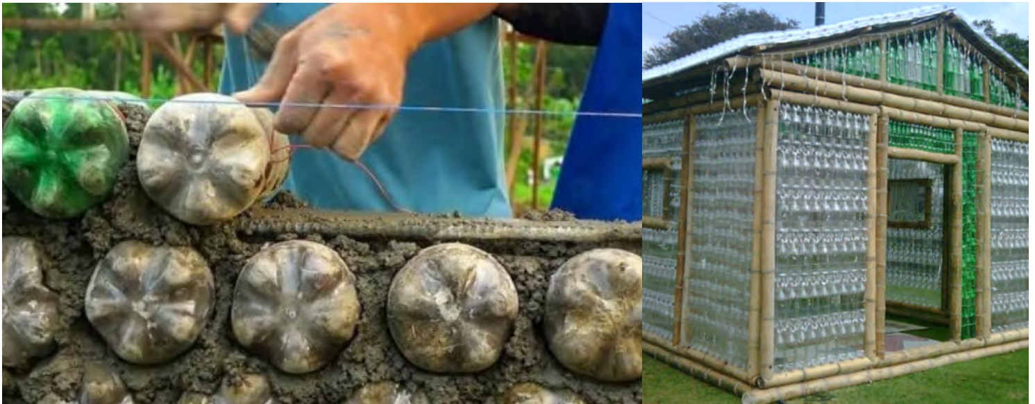
Fig.2. Estructuras realizadas con ecoladrillos. [2]
