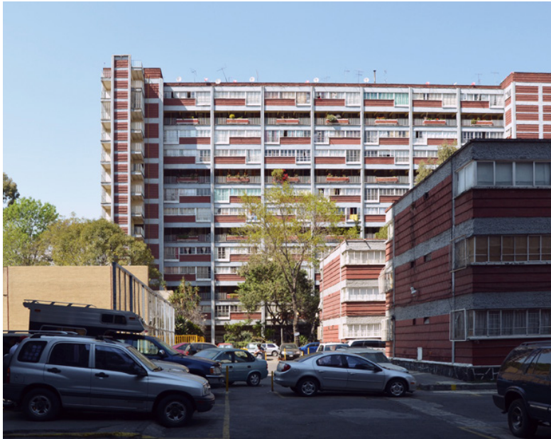
Imagen MT.12 Vista de las fachadas del CUPA
