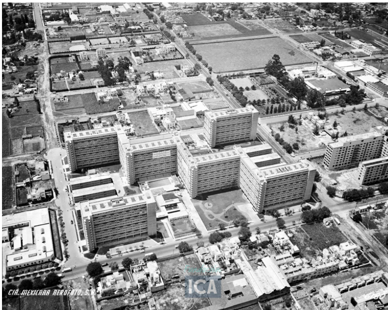
Imagen MT.13 Vista área del conjunto, Proyecto CUPA
