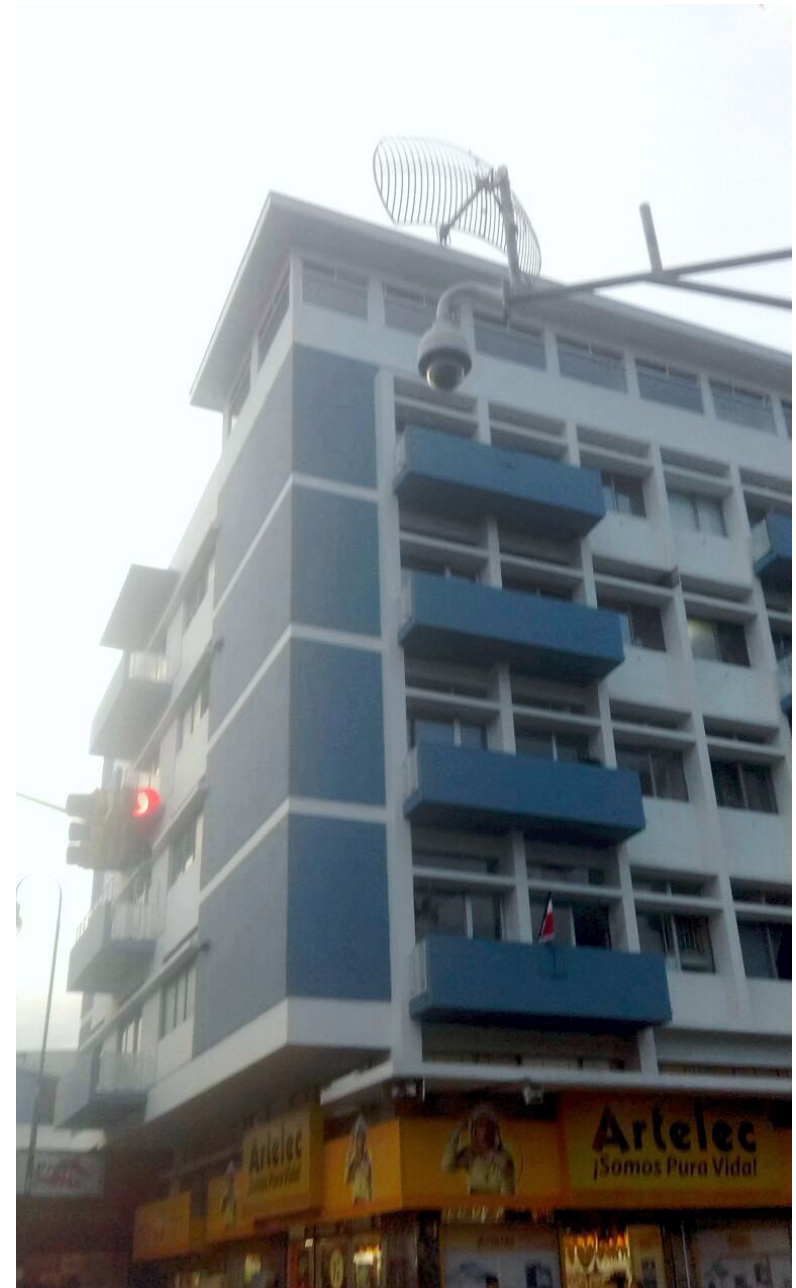
Imagen MT.5 Edificio Solera Bennett, San José
