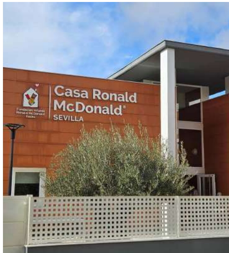
Figura 7. Fachada Casa Ronald McDonald Sevilla. Fuente : Ybarra.com.
