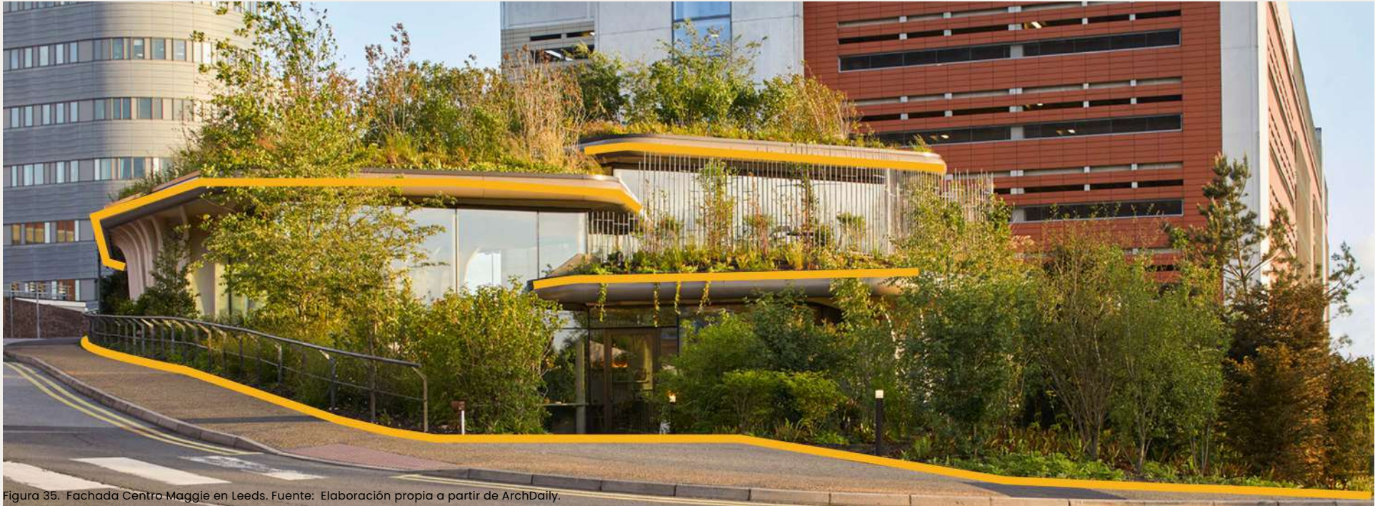
Figura 35. Fachada Centro Maggie en Leeds. Fuente: Elaboración propia a partir de ArchDaily.
