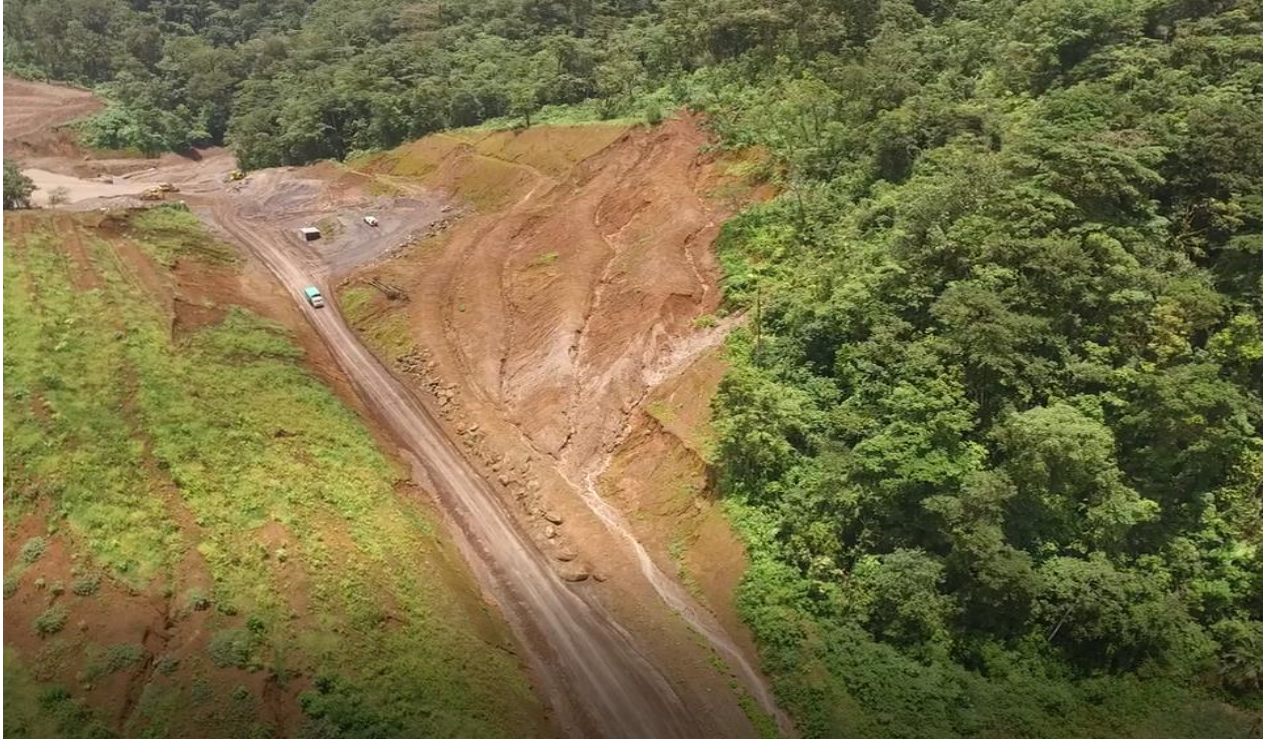
Figura 52. Zona crítica, estación 30+700 Fuente: Asesorías GEOTEC.
