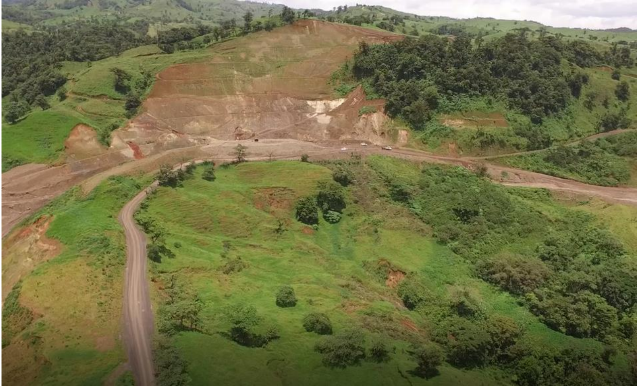
Figura 45. Zona crítica, estación 18+600 Fuente: Asesorías GEOTEC.
