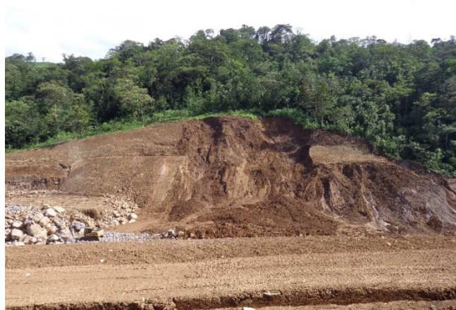
Figura 19. Deslizamiento en estacionamiento 30+700. Asesorías Geotec S.A. (2015).
