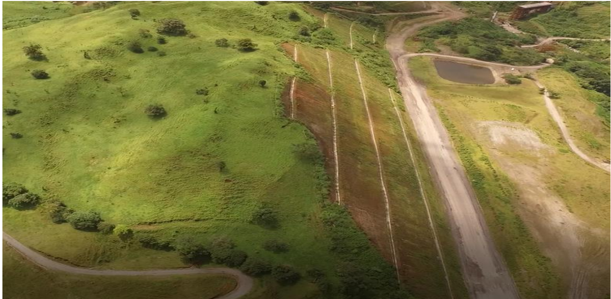
Figura 47. Zona crítica, estación 20+050 Fuente: Asesorías GEOTEC.
