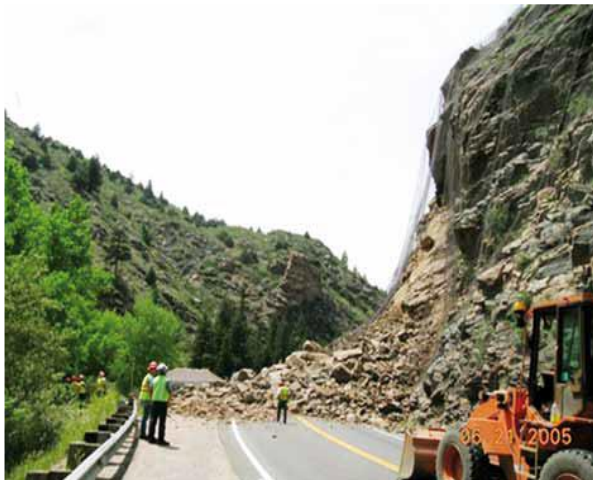
Figura 6. Desprendimiento de Roca. Fuente: Manual de Derrumbes 2008.
