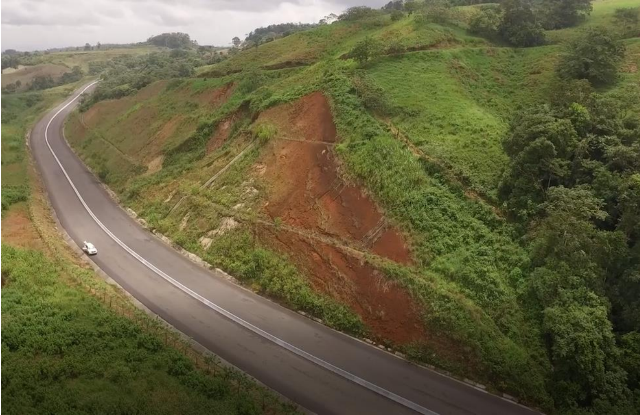
Figura 55. Zona crítica, estación 34+770 Fuente: Asesorías GEOTEC.
