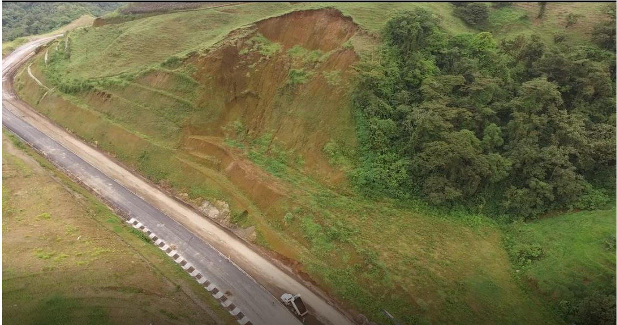
Figura 44. Zona crítica, estación 17+400 Fuente: Asesorías GEOTEC.
