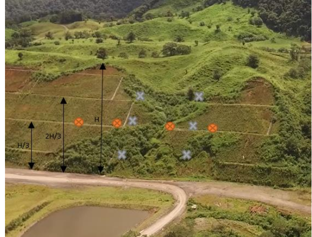
Figura 60. Ubicación de instrumentación para zona crítica en estación 19+800.
