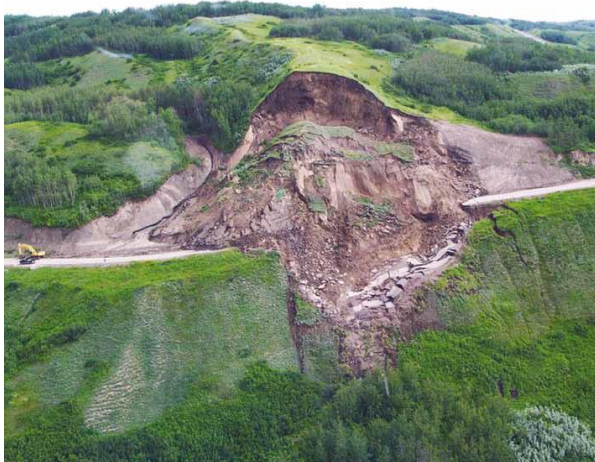
Figura 8. Deslizamiento Traslacional Fuente: Manual de Derrumbes, 2008.
