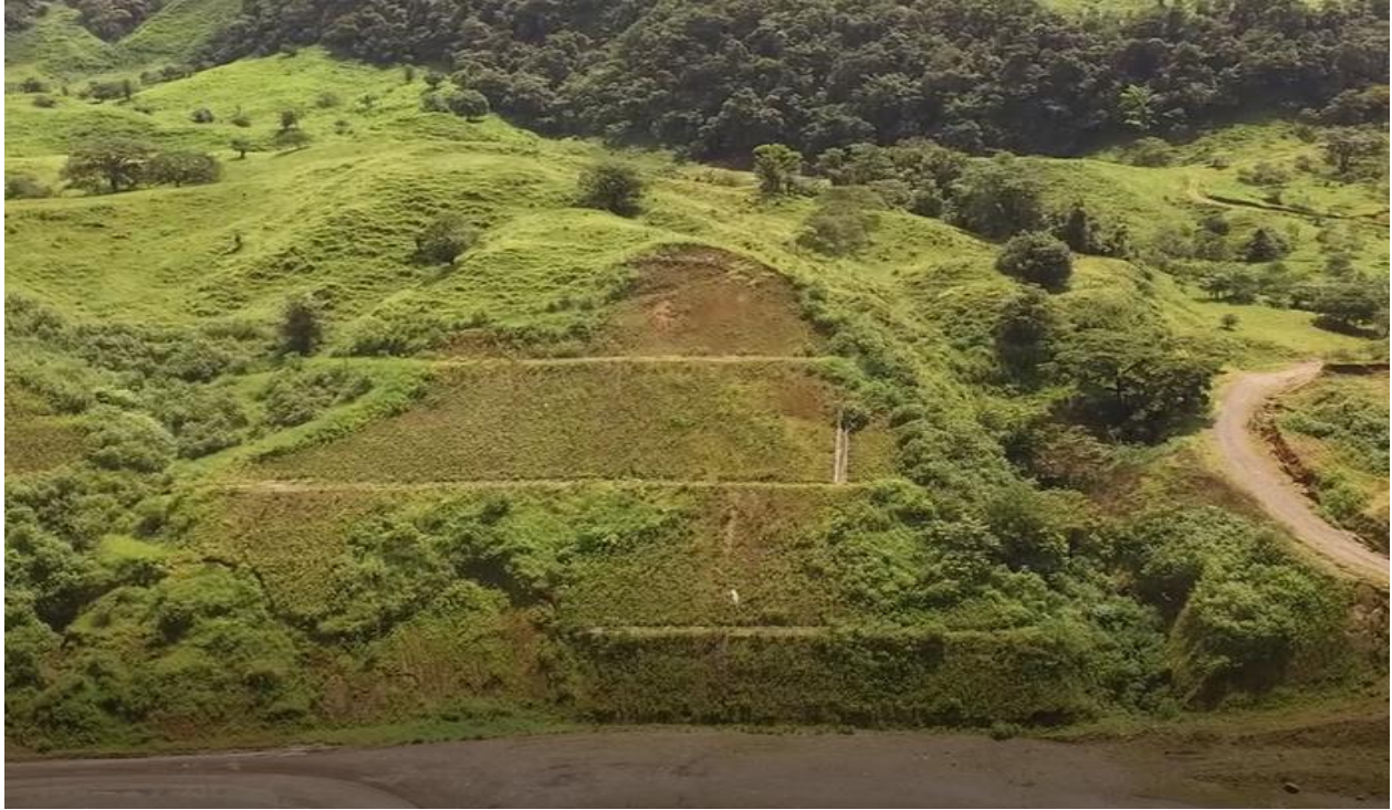
Figura 46. Zona crítica, estación 19+800 Fuente: Asesorías GEOTEC.
