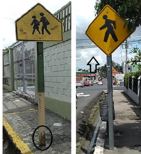
Figura 155. Señales oxidadas y dobladas.
