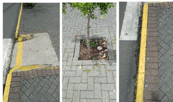
Figura 119. Rampa y confinamiento en zona 4. Fuente. Elaboración propia.
