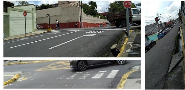
Figura 133. Señales horizontal calle 2 y 4. Fuente. Elaboración propia.
