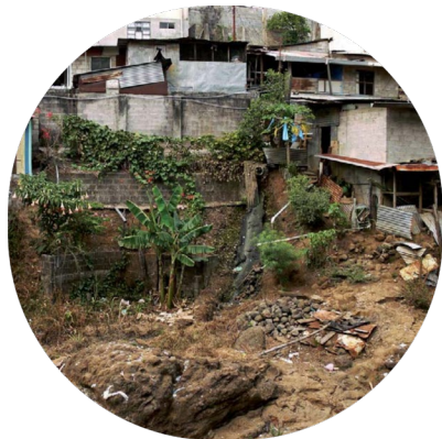
Viviendas contaminando el río Pirro
