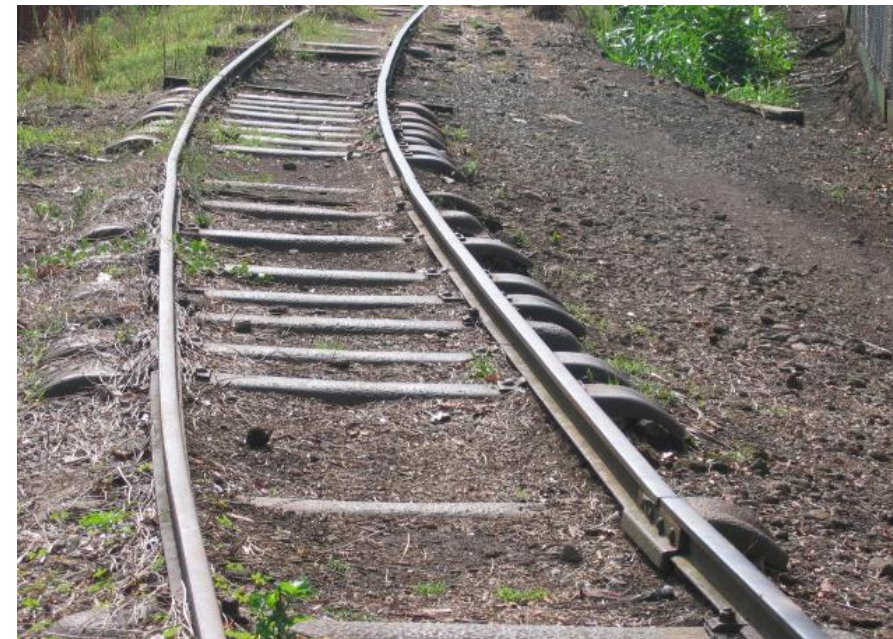
Figura N° 3. Vía Férrea Fuente: Propia
