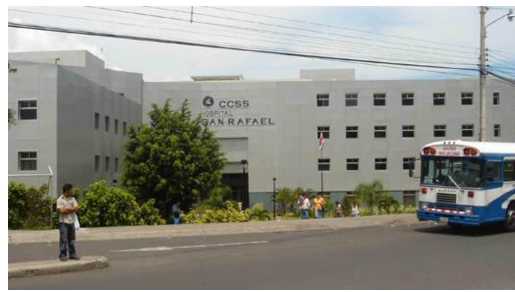
Figura N° 30. Hospital San Rafael
