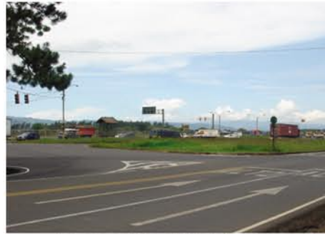
Intersección vial del aeropuerto
