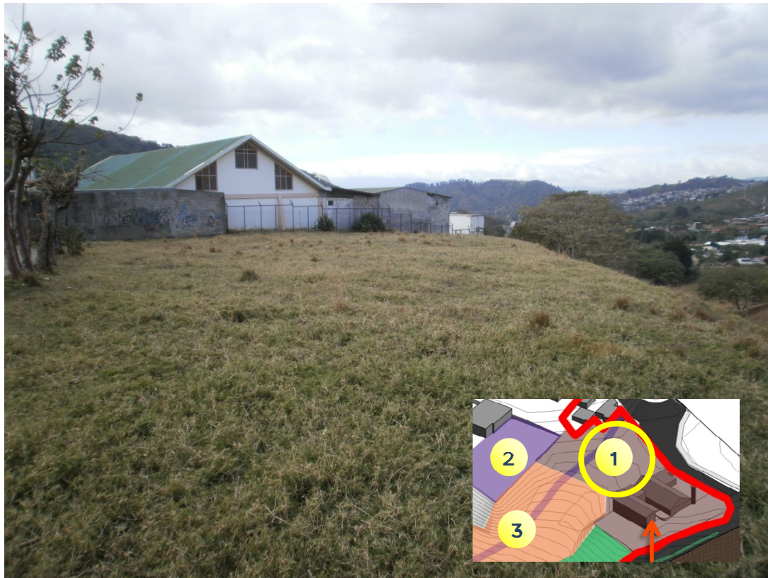
Ilustración 55. Parte Posterior del Templo. Fuente: propia.
