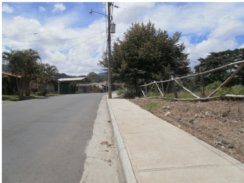
Ilustración 34. Acera de reciente construcción. Fuente: propia.
