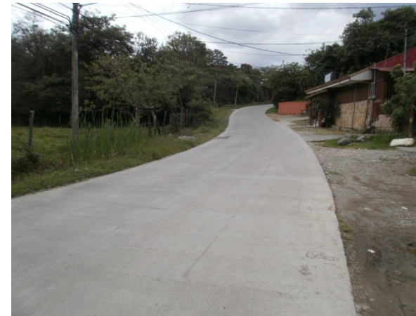
Ilustración 42. Obras de Infraestructura en Los Güízaros. Fuente: propia.
