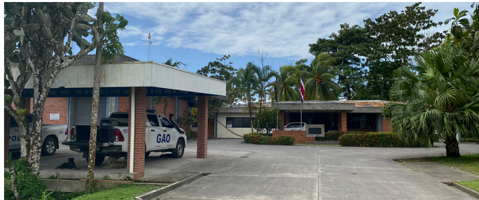
Figura 3.30. Contexto inmediato. Instalaciones de Fuerza Pública. Fuente: propia
