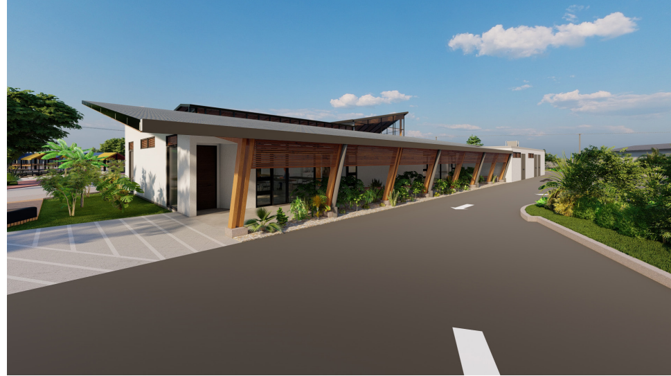
Figura 4.44. Fachada posterior noroeste.
