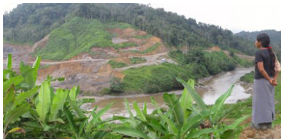
Imagen [1] 35. Proyecto Hidroeléctrico Chan-75. Fuente web.
