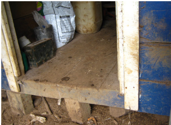
Imagen [2] 83 Piso de madera elevado del terreno. Fuente: UR-PHED.
