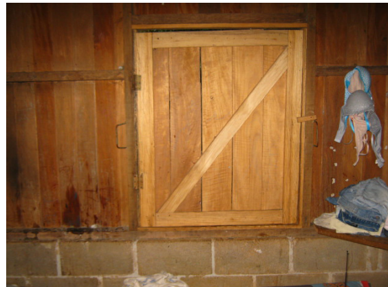
Imagen [2] 101. Ventana de madera desde el interior. Fuente: UR-PHED.
