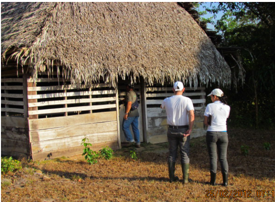
Imagen [2] 96. Pared de madera que permite la ventilación a nivel del usuario. Fuente propia.
