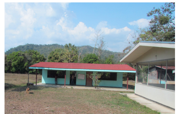
Imagen [2] 47. Vista de las aulas. Fuente propia.
