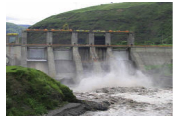
Imagen [1] 15. Proyecto Hidroeléctrico Arenal. Fuente web.
