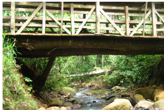
Imagen [2] 56. Materiales de la zona para la construcción. Fuente: UR-PHED.
