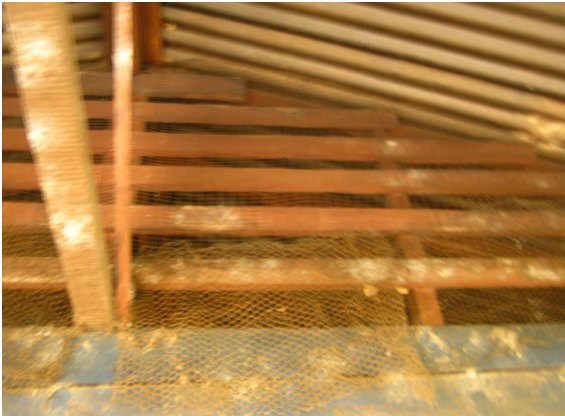
Imagen [2] 95. Aberturas en la parte alta de las paredes para mayor ventilación. Fuente: UR-PHED.
