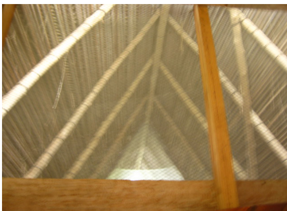
Imagen [2] 79. Interior de cubierta con varillas de bambú como aislante del calor. Fuente: UR-PHED.
