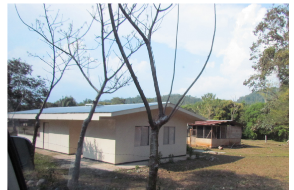
Imagen [2] 46. Vista del comedor escolar. Fuente propia.
