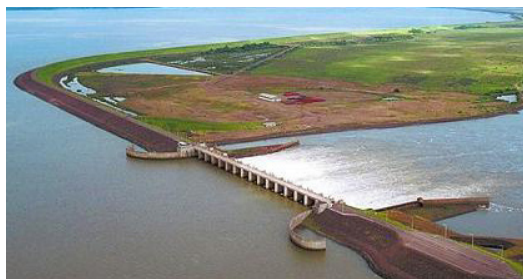
Imagen [1] 30. Proyecto Hidroeléctrico Yacyretá. Fuente web.
