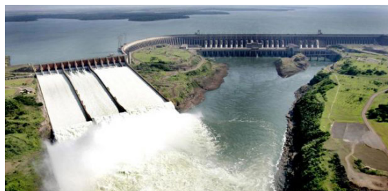
Imagen [1] 31. Proyecto Hidroeléctrico Yacyretá. Fuente web.
