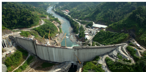
Imagen [1] 34. Proyecto Hidroeléctrico Chan-75. Fuente web.
