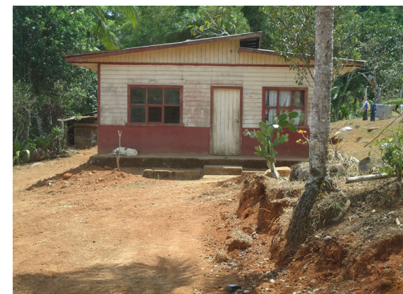
Imagen [2] 77. Pared de concreto y madera de doble forro. Fuente propia.
