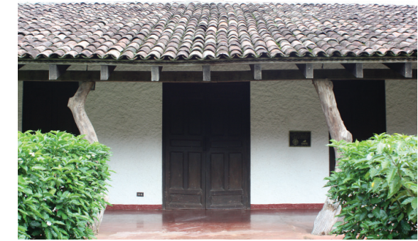
INFRAESTRUCTURA EXISTENTE Imagen F-14. Colección propia.
