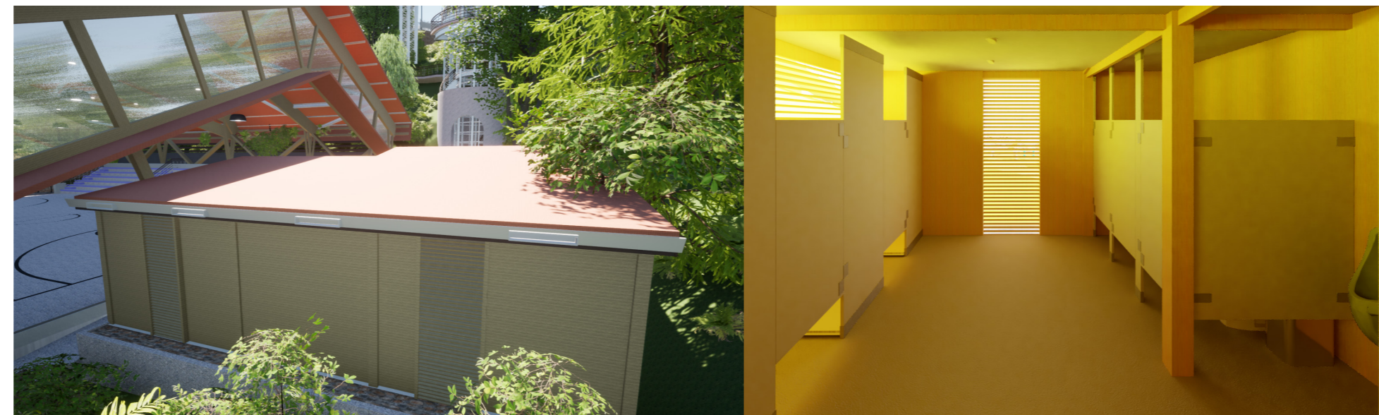
Figura 4.74. Visualización de los baños por el exterior y al interior
