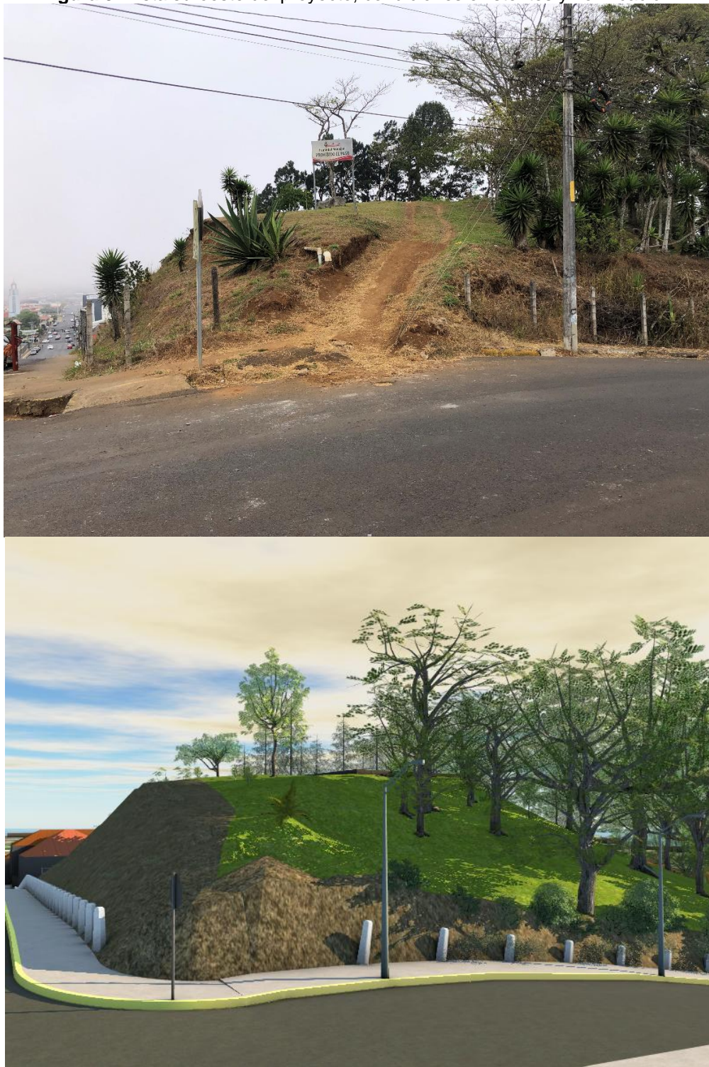
Figura 5. Vista suroeste del proyecto, condiciones existentes y zonificación.
