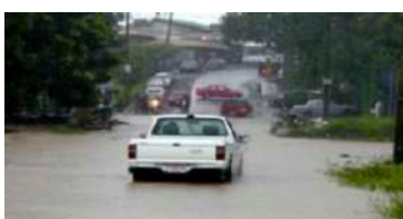
Imagen 45. Inundación puente urbanización El Solar. Fuente: Municipalidad de Desamparados (2006).
