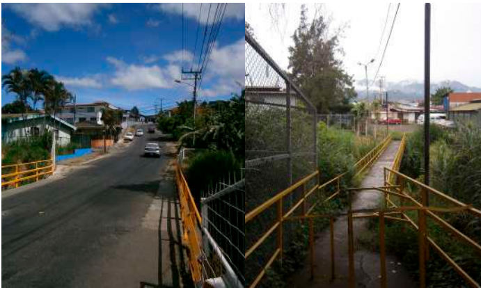
Imagen 25. Puente Calle Pómez. Fuente: Elaboración propia.
