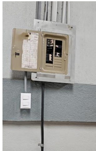
Figura 13: Tablero con tierra independiente
