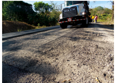
Figura 39. Riego de liga sobre superficie sucia y empolvada
