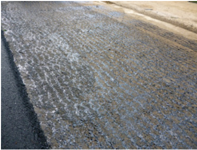
Figura 43. Riego de liga no uniforme y sin adecuada cobertura, producto del uso de boquillas con una abertura mayor según tasa de dosificación aplicada Fuente: LanammeUCR, 2016
