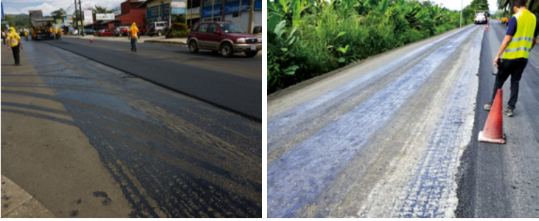
Figura 60. Arrastre del riego de liga por vagonetas en la colocación de asfalto
