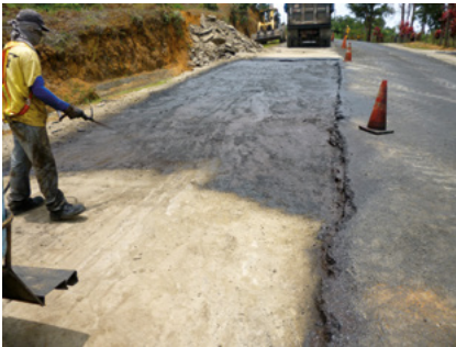
Figura 39. Riego de liga sobre superficie sucia y empolvada
