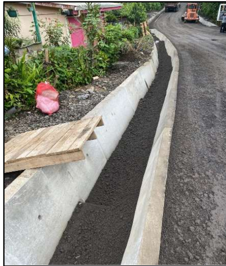
Figura 1. Ejemplo de una cuenta revestida.
