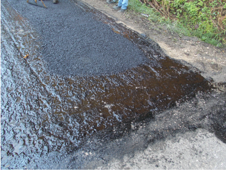
Figura 62. Colocación mezcla asfáltica en emulsión sin romper
