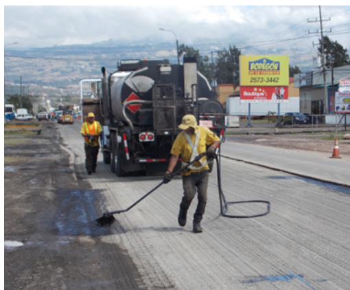
Figura 58. Aplicación manual de emulsión asfáltica sobre zonas con presencia de humedad y polvo
