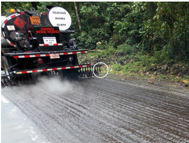
Figura 44. Ángulo de boquillas distinto entre ellas, modifica patrón de riego en borde
