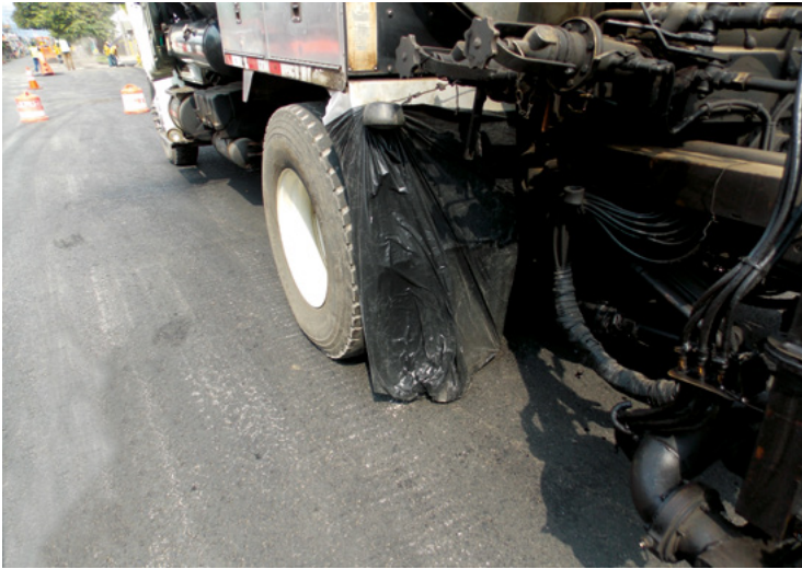
Figura 37. Protección del camión dosificador para evitar salpicaduras de emulsión asfáltica
