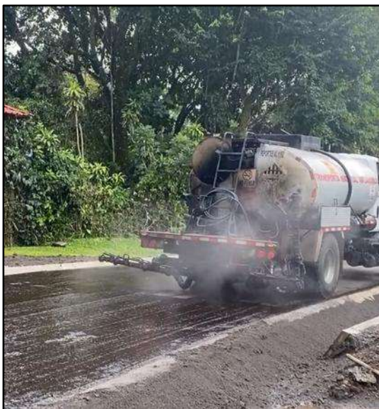
Figura 5. Colocación de riego de imprimación.
