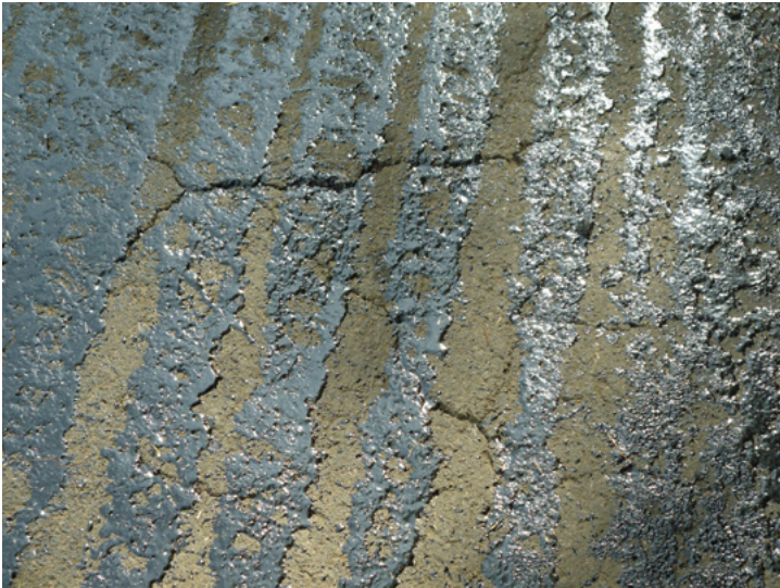
Figura 41. Aplicación de riego de liga sobre superficie con grietas sin sellar
