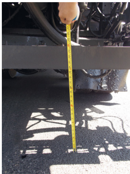
Figura 45. Altura de barra excesiva hasta 50 cm de altura
