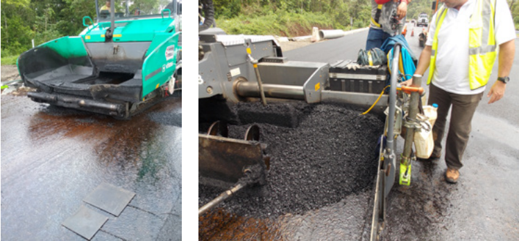
Figura 61. Colocación de mezcla asfáltica sobre emulsión sin romper y con humedad
