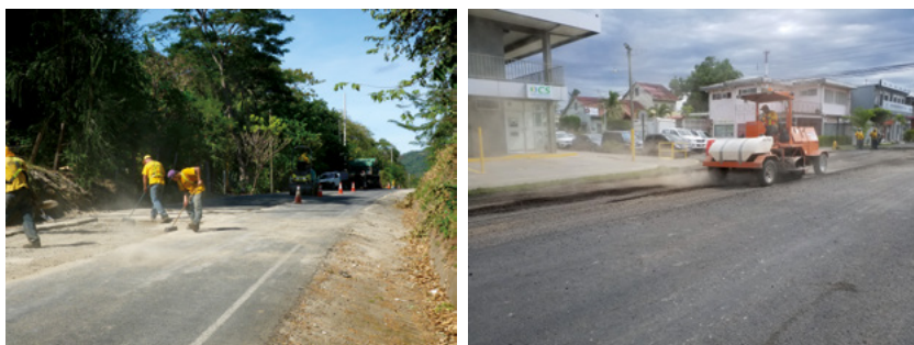
Figura 27. Limpieza de la superficie a intervenir con cepillos o barredora mecánica
