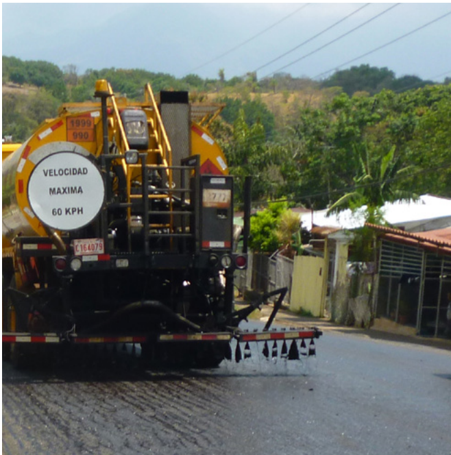
Figura 47. La presión de rocío no es suficiente para que la expulsión de la emulsión asfáltica sea en forma de abanico. El patrón de rocío no es el mismo para todas las boquillas
