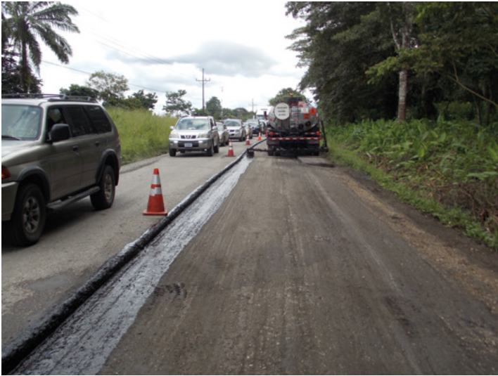
Figura 34. Adecuada cobertura en cortes de junta longitudinal
