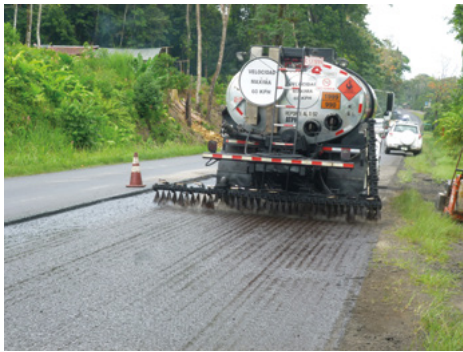
Figura 20. Riego de liga uniforme con cobertura total Fuente: LanammeUCR, 2016
