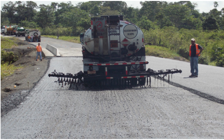
Figura 46. Variación de la altura a lo largo de la barra rociadora
