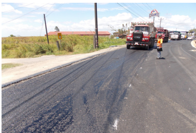
Figura 59. Vagonetas estacionadas sobre el riego de liga
