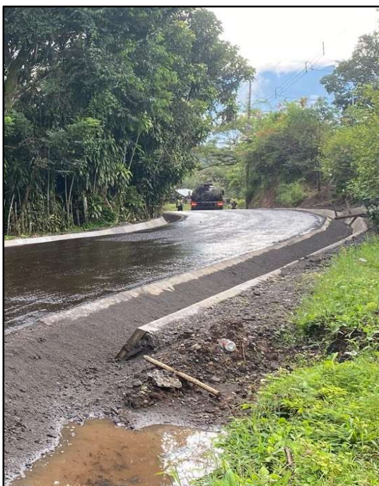
Figura 5. Colocación de riego de imprimación.
