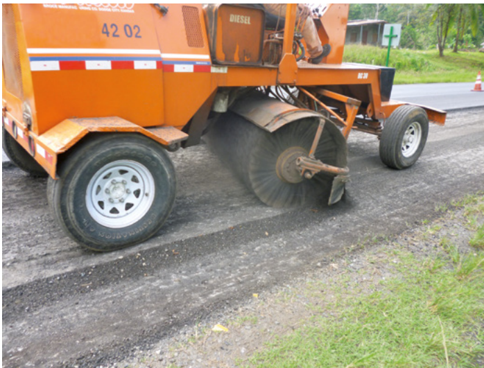
Figura 18. Limpieza de la superficie a intervenir con barredora mecánica Fuente: LanammeUCR, 2016
