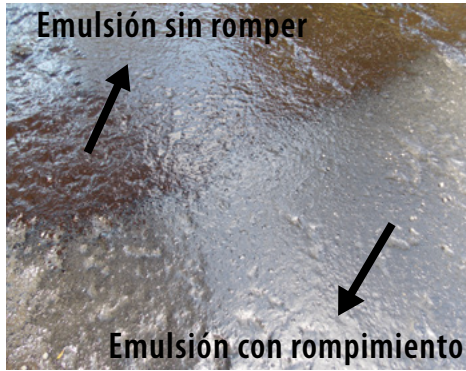
Figura 1. Rompimiento de emulsión asfáltica Fuente: LanammeUCR, 2018
