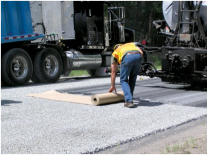
Figura 19. Colocación de papel en juntas Fuente: pavementinteractive.org
