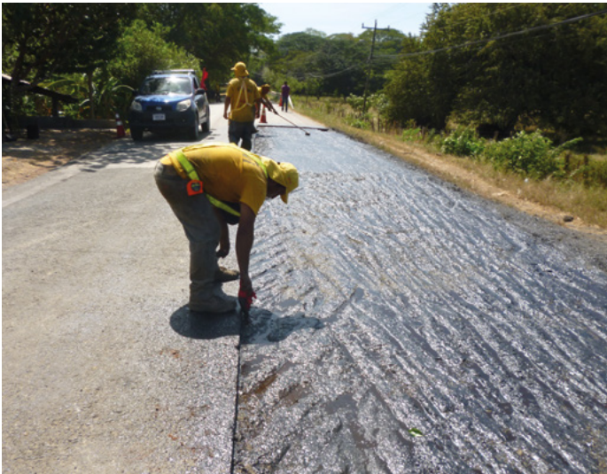
Figura 35. Eliminación del exceso de riego de liga, el excedente se debe retirar con esponjas, toallas o cepillos
