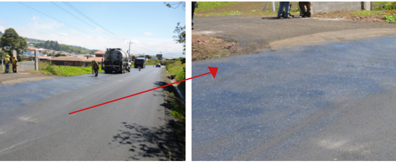
Figura 51. Aplicación manual no uniforme del riego de liga. Los patrones de riego de liga son distintos en el área de aplicación
