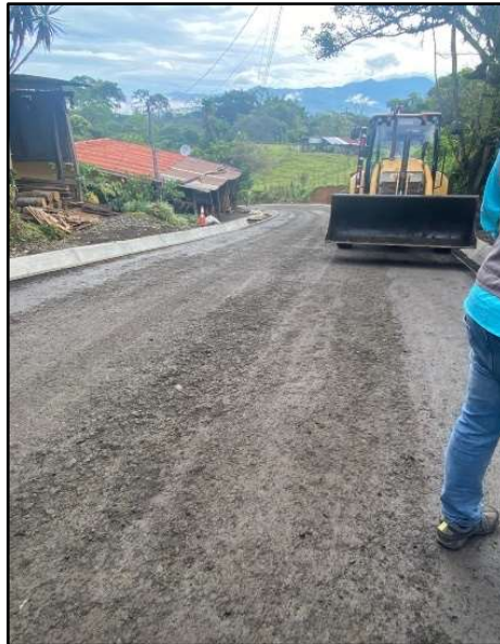
Figura 2. Superficie una vez barrida.
