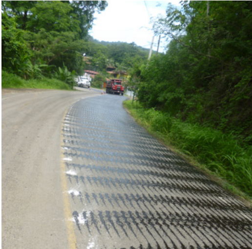
Figura 49. Riego de liga heterogéneo y sin cobertura total de la superficie
