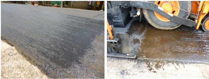
Figura 56. Concentración de riego de liga por traslape entre aplicaciones en tramos adyacentes
