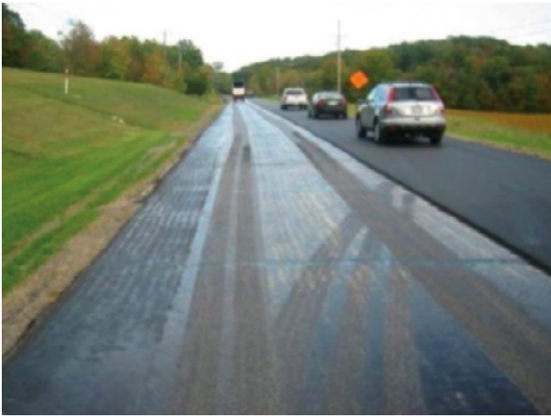
Figura 25. Arrastre riego de liga debido al tránsito de vehículos sobre la emulsión Fuente: Asphalt Institute, 2014
