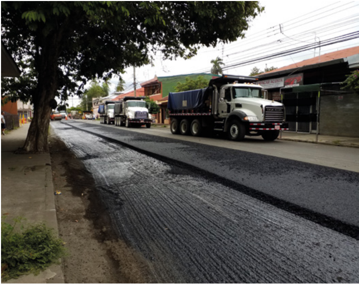
Figura 38. Vagonetas estacionadas fuera del riego de liga
