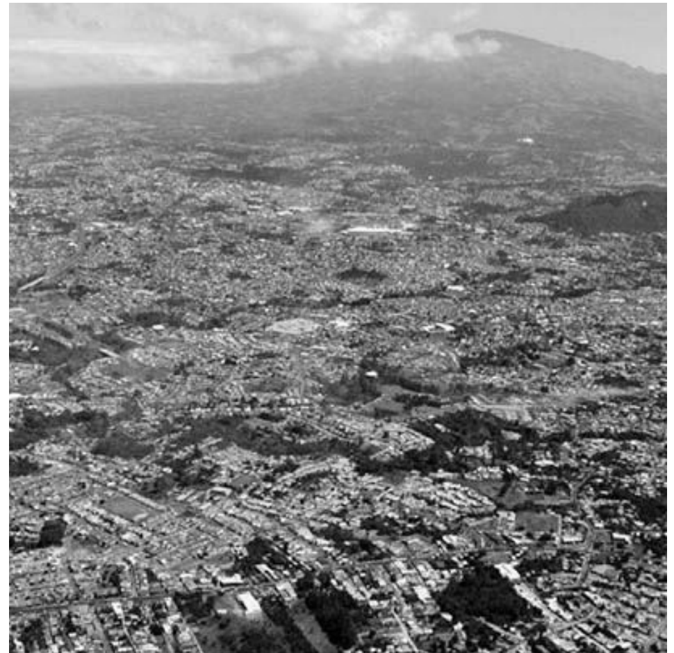
Figura 1.33: Vista del Cantón de Montes de Oca . Fuente Municipalidad de Montes de Oca
