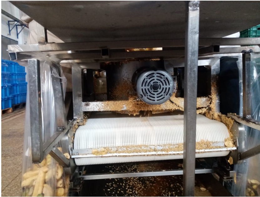
Figura 4.17: Motor de las cortadoras, bajo la tapa se encuentra una estructura similar a los demás actuadores.
