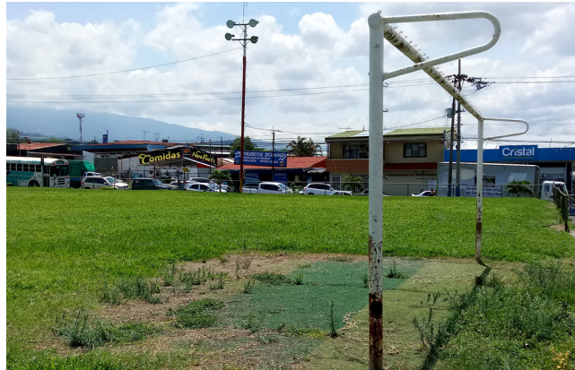
Figura 48. Deterioro de la cancha de fútbol [Fotografía], por Autoría propia.
