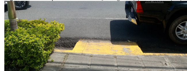
Figura 43. Rampa de acceso [Fotografía], por Autoría propia.
