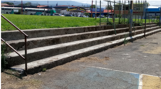
Figura 44. Desnivel sector sur del lote [Fotografía], por Autoría propia.
