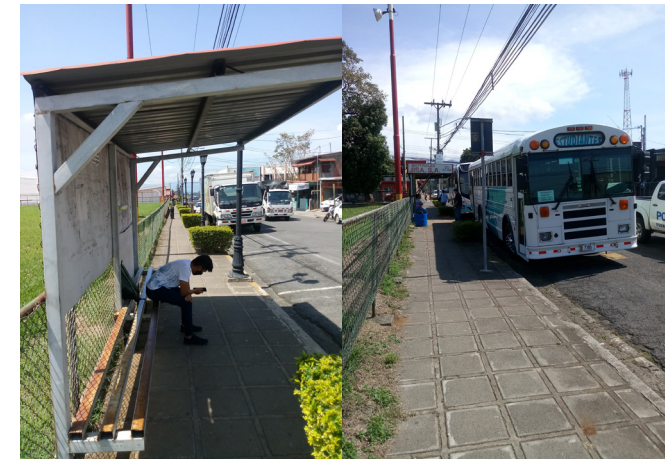
Figura 65 y 66. Paradas sector este y oeste [Fotografía], por Autoría propia.
