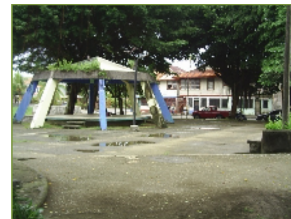
Img. n. 94. Estado del kiosco y la plaza del Parque Los Baños. Fuente: colección propia.
