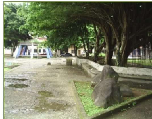
Img. n. 19. Acumulación de aguas pluviales, Parque Los Baños, Limón. Fuente: colección propia
