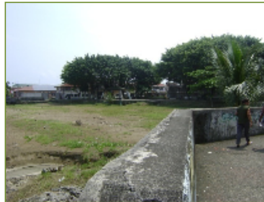
Img. n. 96. Falta de mantenimiento en la playa Los Baños. Fuente: colección propia.
