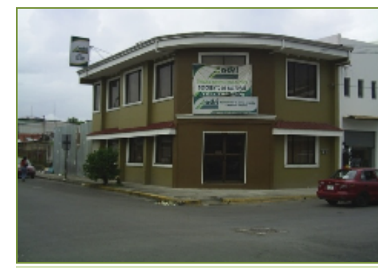
Img. n. 65. Edificio de uso comercial, hecho en concreto y de color verde opaco. Fuente: colección propia.
