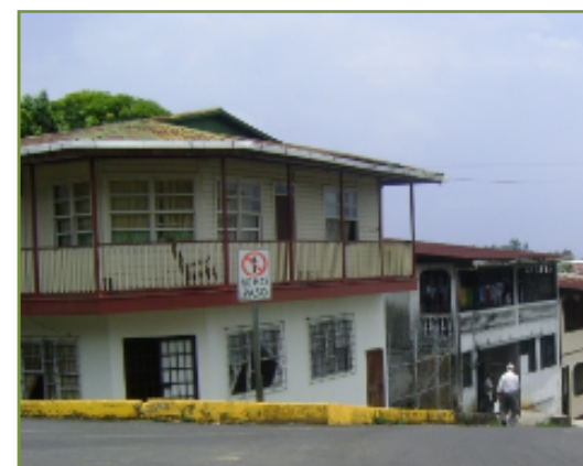
Img. # 66. Casa construida en madera en Limón. Fuente: colección propia.
