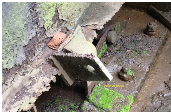
Figura 19: Deformación – Grado 5
