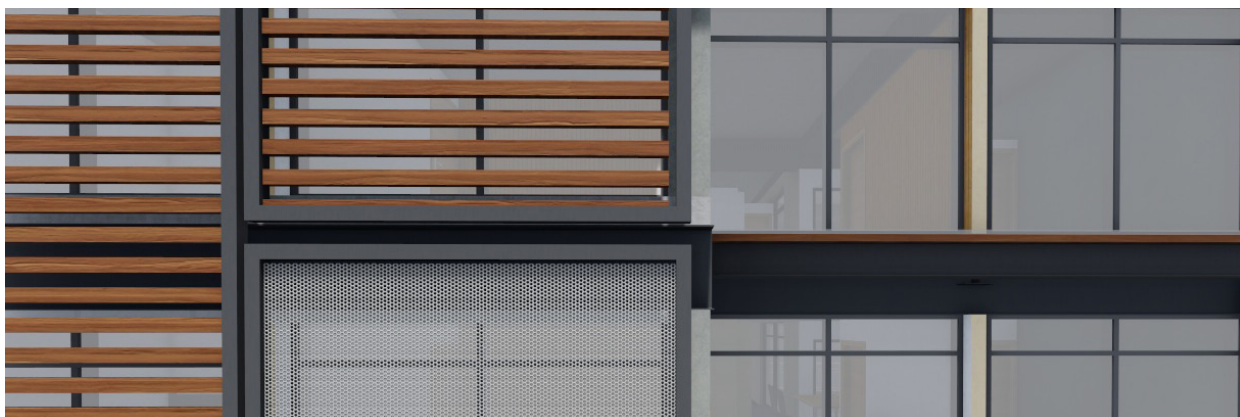
Imagen 4.13. Protección solar mediante louvers de madera y malla perforada.
