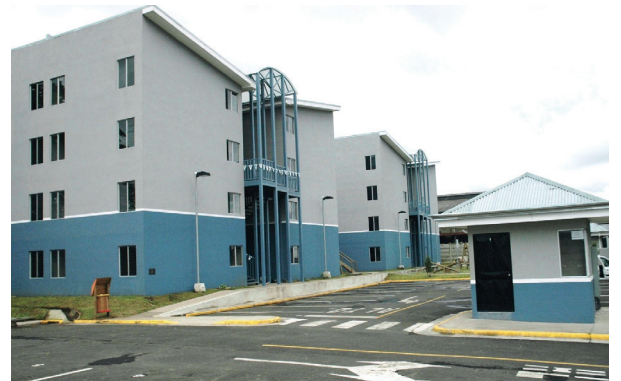
Imagen 1.10. Vista externa del proyecto, se evidencia poca visibilidad hacia adentro del proyecto.
