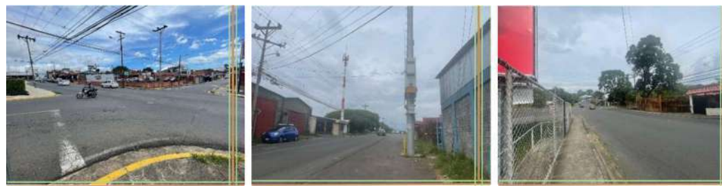
Figura 4.2. Situación actual de las calles en el casco central de Alajuela.
