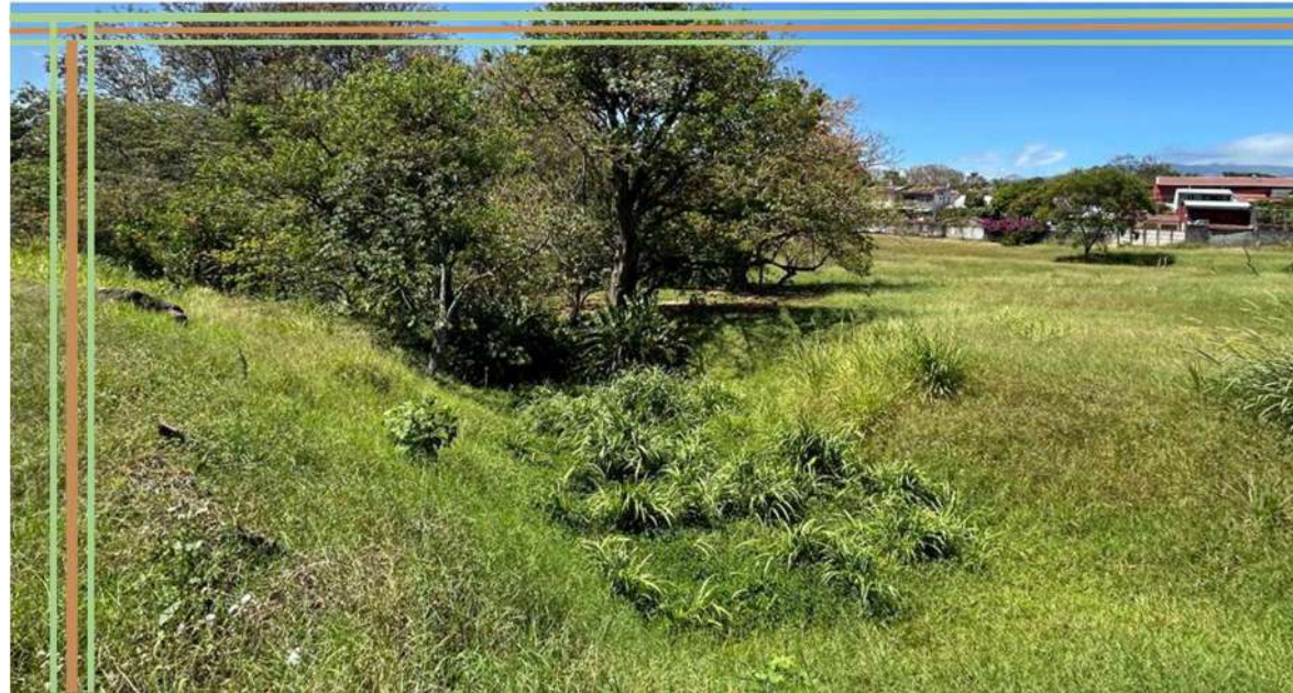
Figura 4.15. Hundimiento de tierra en el espacio.
