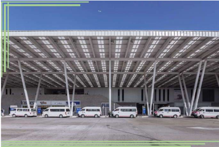
Figura 1.8. Andén de abordaje de buses de la Estación de Transferencia Multimodal Cuatro Caminos, Naucalpan de Juárez, México.
