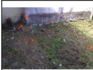
Foto #3: Replanteo Topográfico de Lindero y Determinación de Niveles
