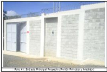
Foto #1: Entrada Principal Proyecto (Pórtico Principal y Medidor)
