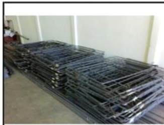
Foto #9: Armadura Construida en Taller (58 unidades)
