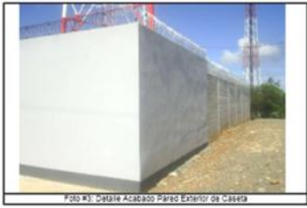
Foto #3: Detalle Acabado Pared Exterior de Caseta
