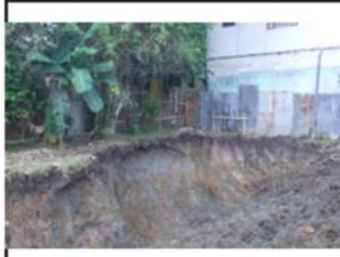
Foto #1: Início de Excavación de Cimiento para Torre (252 m 3 )
