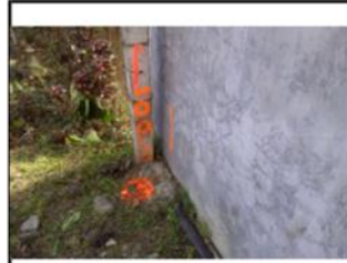
Foto #4: Marcación Topográfica y Determinación de Niveles
