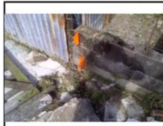
Foto #6: Replanteo Topográfico de Lindero
