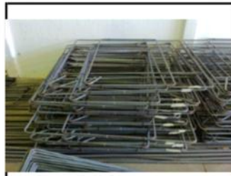
Foto #10: Detalle de Armadura Construida en Taller (58 unidades)
