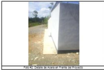
Foto #2: Detalle de Acera en Frente del Proyecto
