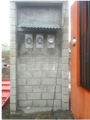
Figura Ap.4 Colocación de medidores de sitio de torre en Heredia Fuente: Elaboración propia del grupo técnico
