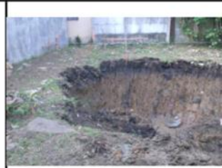
Foto #2: Início de Excavación de Cimiento para Torre (252 m 3 )
