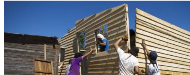
Figura 60 Armado Vivienda Temporal. Fuente: La Colmena. (2021). de: lacolmenaenred.com.ar
