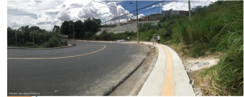
Foto por: Arq. Jessica Peralta Q. Fotografía proceso de intervención, fecha 27-11-2019
