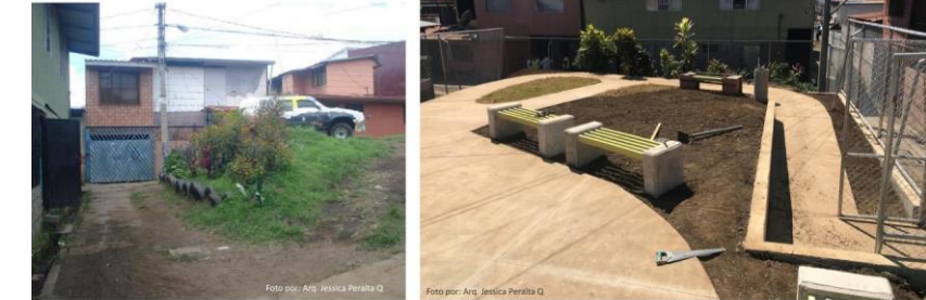
Foto por: Arq. Jessica Peralta Q. Fotografía previo a intervención Fotografía proceso de intervención fecha 9-12-2019
