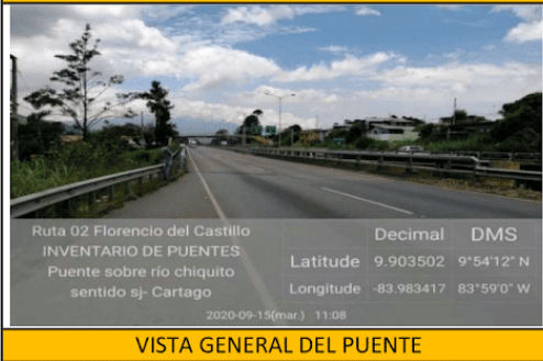
VISTA GENERAL DEL PUENTE
