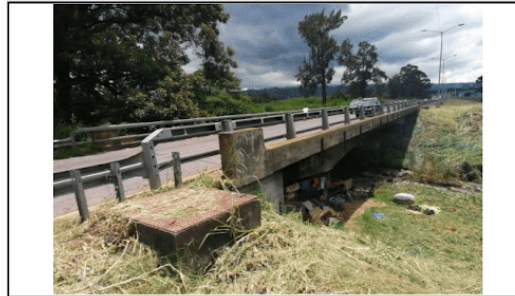
MARGEN DE PUENTE
