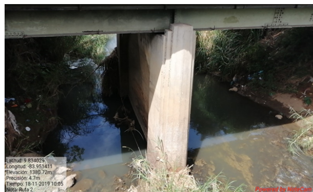
Figura 29. Puente sobre Río Purires.
