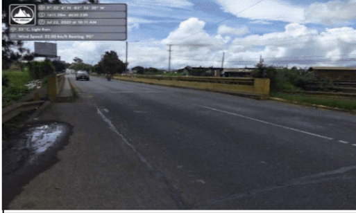
VISTA GENERAL DEL PUENTE
