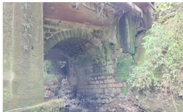
Figura 41. Puente sobre Río Barquero. Fuente: Elaboración propia.
