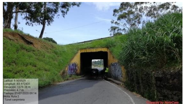
Figura 25. Paso superior sobre ruta 251.
