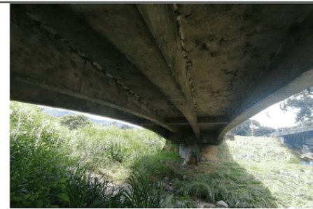
VISTA INFERIOR PUENTE
