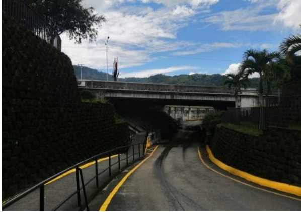
Figura 13. Puente de acceso a Terra Mall. Fuente: Elaboración propia.
