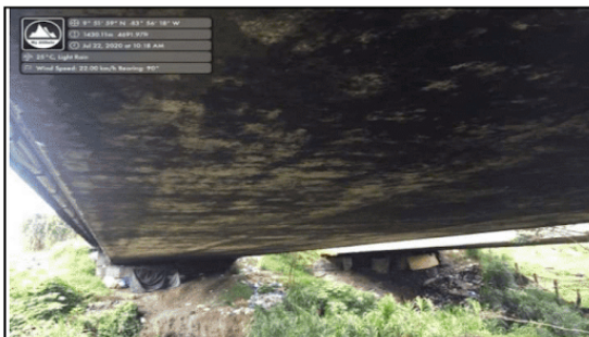
VISTA INFERIOR PUENTE
