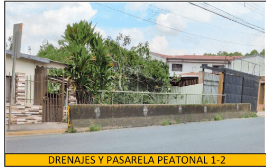
DRENAJES Y PASARELA PEATONAL 1-2
