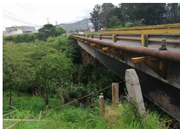
Figura 35. Puente sobre Río Reventado sentido San José - Cartago.
