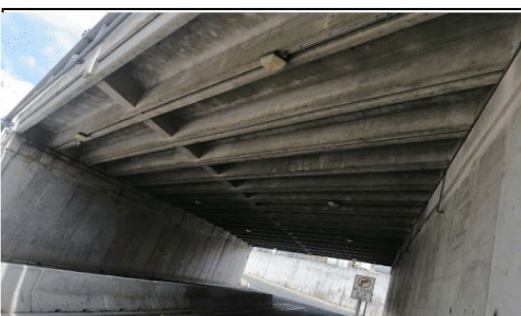
VISTA INFERIOR PUENTE
