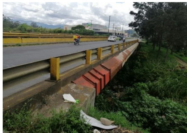
Figura 33. Puente sobre Río Reventado sentido Cartago – San José.
