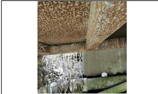
APOYOS DE PASARELA PEATONAL 1-2
