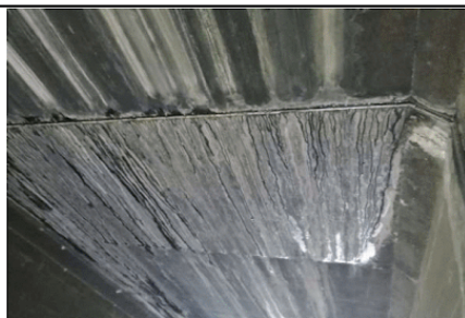
VISTA INFERIOR PUENTE
