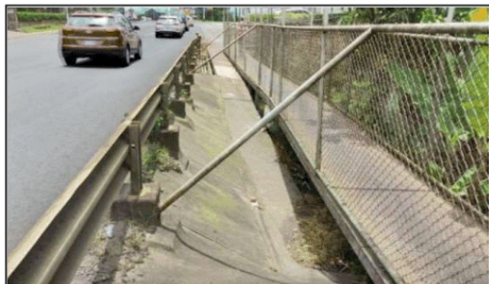
DRENAJES Y PASARELA PEATONAL 1-2
