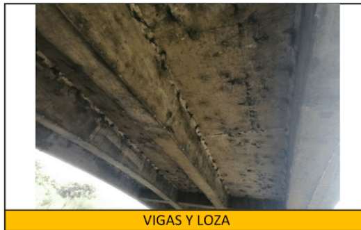
VIGAS Y LOZA
