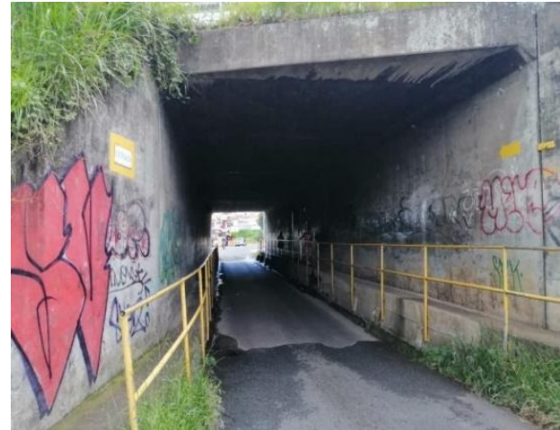
Figura 23. Paso superior sobre ruta vecinal.
