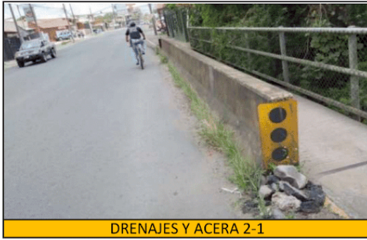
DRENAJES Y ACERA 2-1
