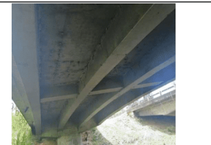
ARRIOSTRES DE CONCRETO
