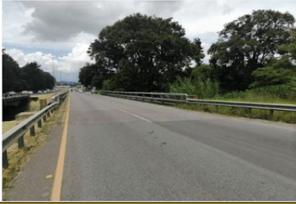
VISTA GENERAL DEL PUENTE
