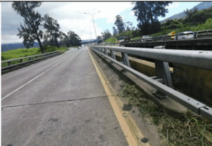
BARANDA Y DRENAJES
