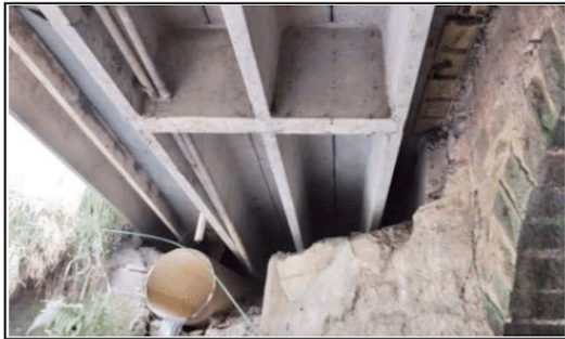
VIGAS Y LOSA
