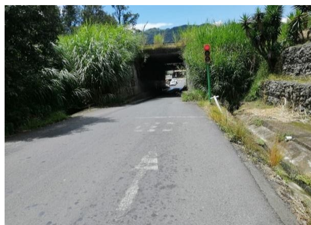
Figura 11. Paso superior sobre ruta 409. Fuente: Elaboración propia.
