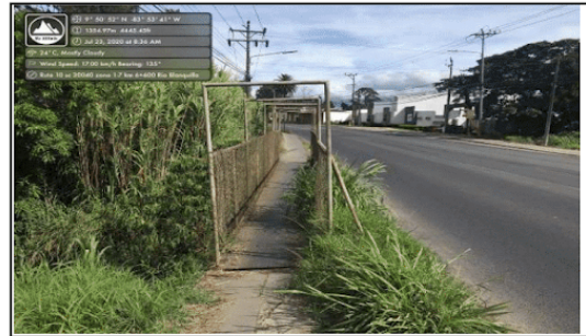
PASARELA PEATONAL SENTIDO 1-2
