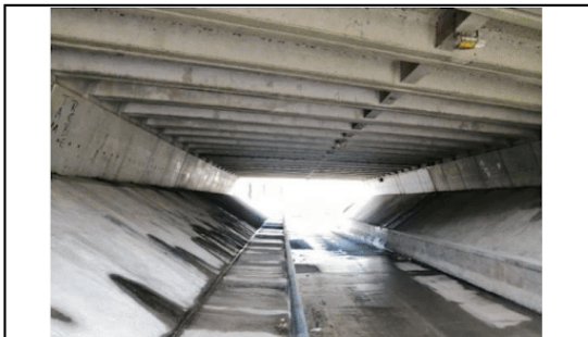
DRENAJES DE TALUD INTERNO
