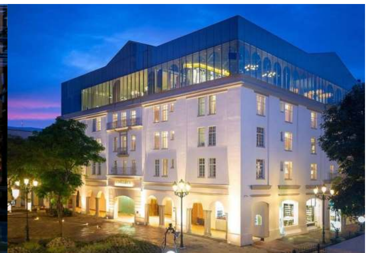
Figura 15: Restauración del antiguo Hotel Costa Rica (2018)
