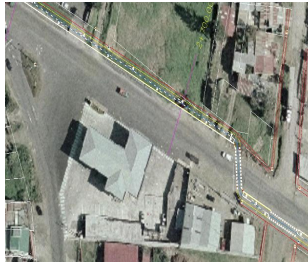
Figura 38. Cerca 2+647 m, cambio antes de puente Bailey
