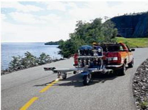
Figura 24. Equipo de demarcación
