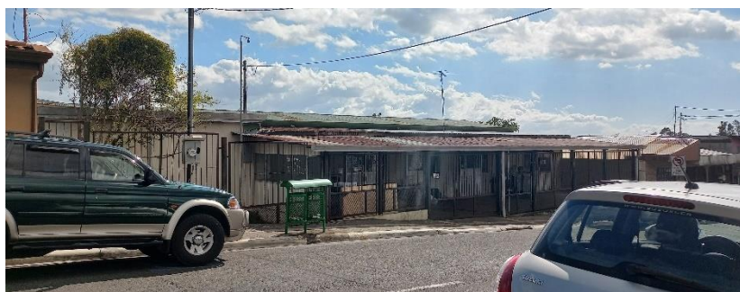
Ilustración 46: Antiguo Centro de Salud de San Isidro, costado norte. Fuente: propia, 2023
