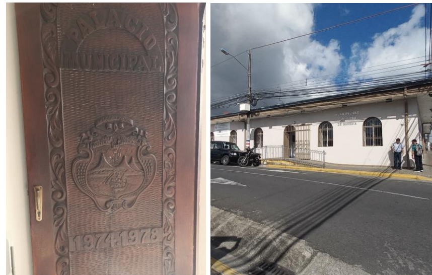
Ilustración 19: Puerta principal y acceso del Palacio Municipal de San Isidro de Heredia. Fuente: Propia, 2023
