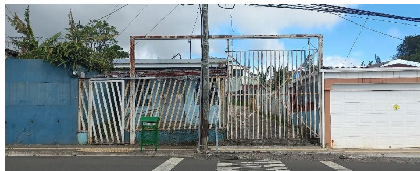
Ilustración 47: Antiguo Centro de Salud de San Isidro, costado oeste. Fuente: propia, 2023
