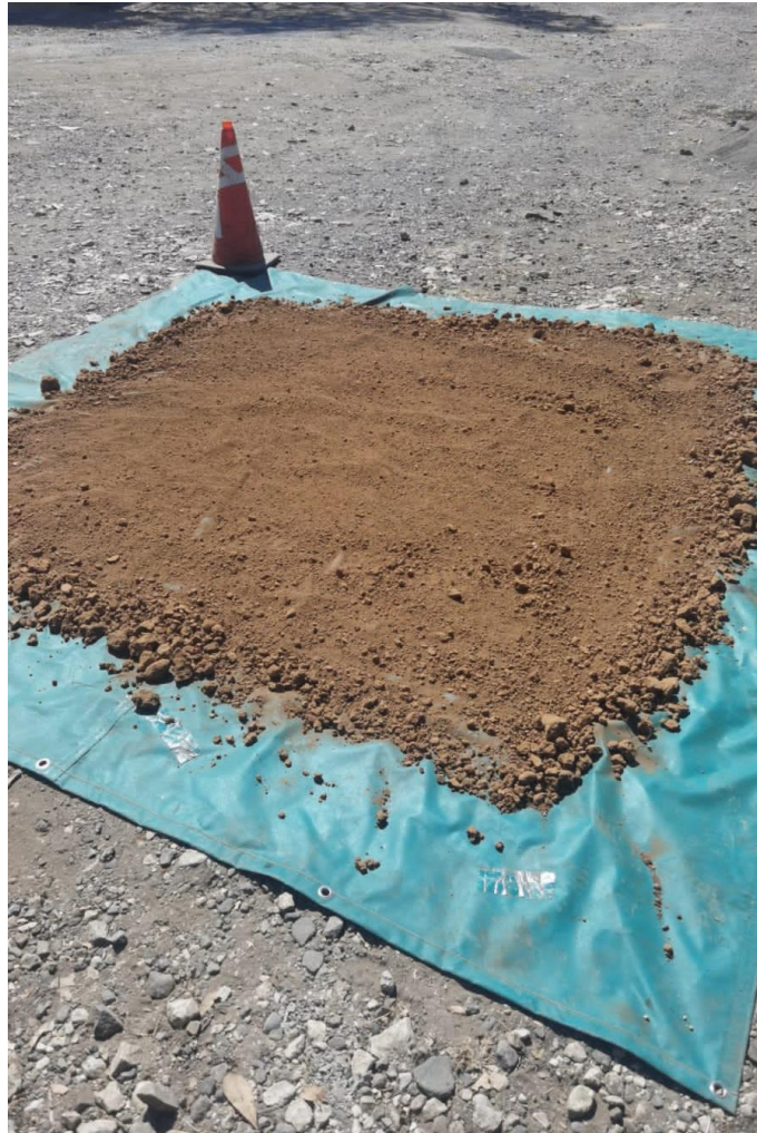
Figura 4.24. Extendido y secado de material de subrasante previo a los ensayos.
