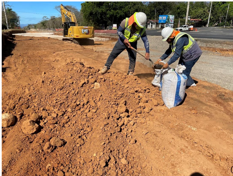
Figura 4.21. Sitio de muestreo de material de subrasante.
