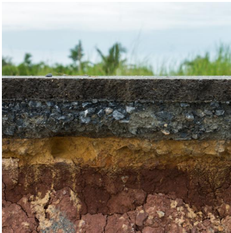
Figura 2.1. Capas de un determinado pavimento.
