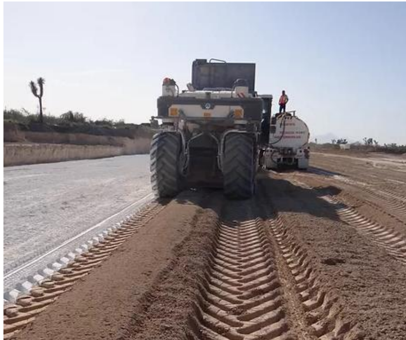
Figura 2.3. Proceso de mezclado de suelo con cemento hidráulico. Fuente: https://www.seceyco.com/mejoramiento-de-suelos
