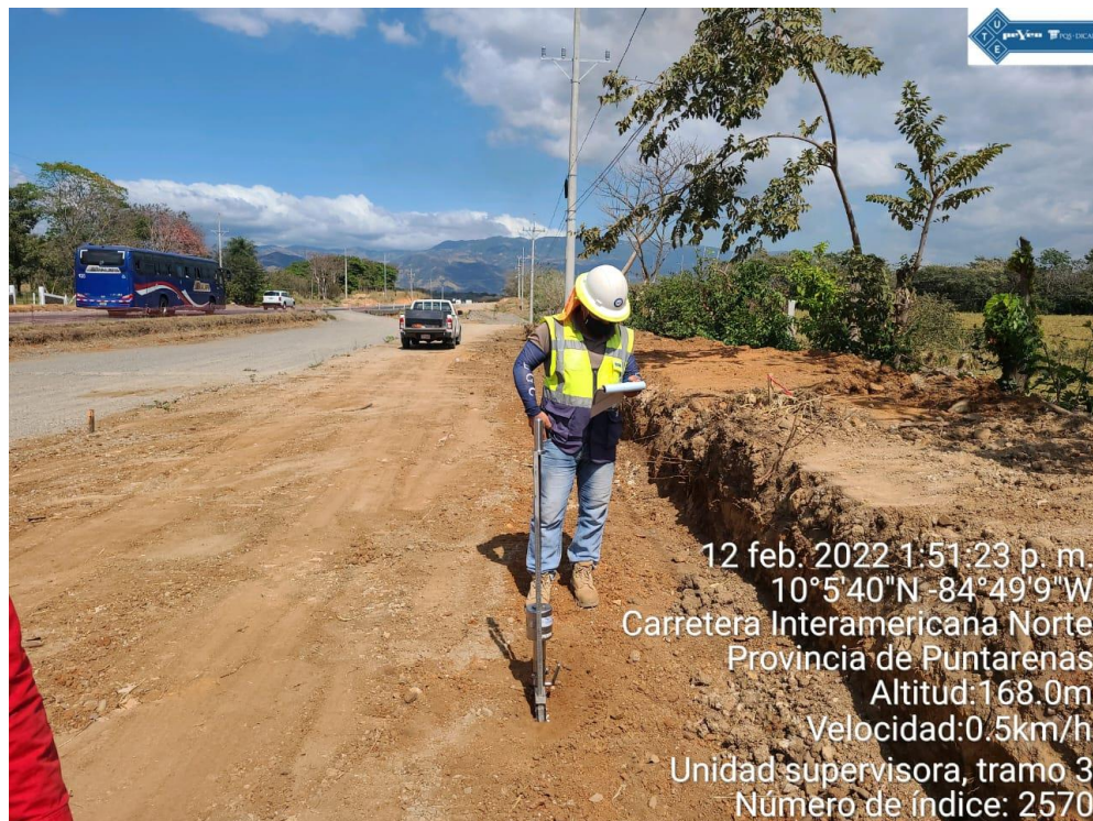
Figura 4.23. Ensayo de CBR en sitio con DCP al material de subrasante.
