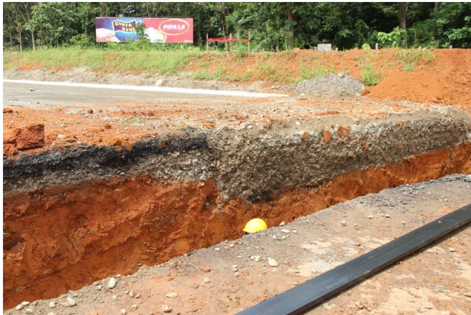
Figura 1.1. Estructura de pavimento, Subrasante.
