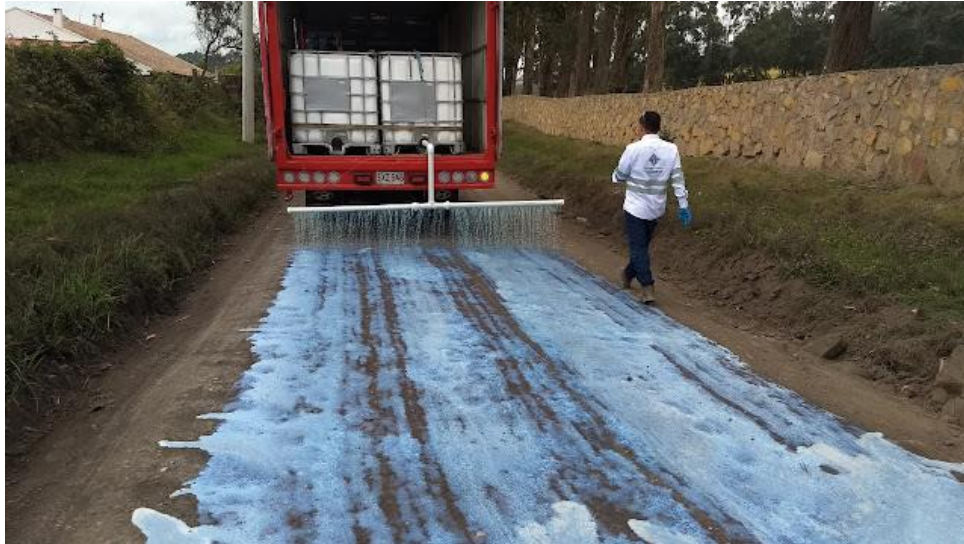
Figura 2.2. Estabilización de suelo mediante aplicación de polímero.
