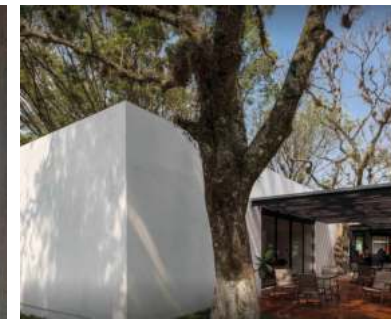
Figura Ci 4: La Casa del Abuelo. Fuente: https://www.plataformaarquitectura.cl/cl/872702/casa-del-abuelo-taller-diez-05
