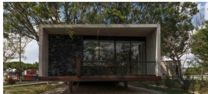
Figura Ci 5: La Casa del Abuelo. Fuente: https://www.plataformaarquitectura.cl/cl/872702/casa-del-abuelo-taller-diez-05
