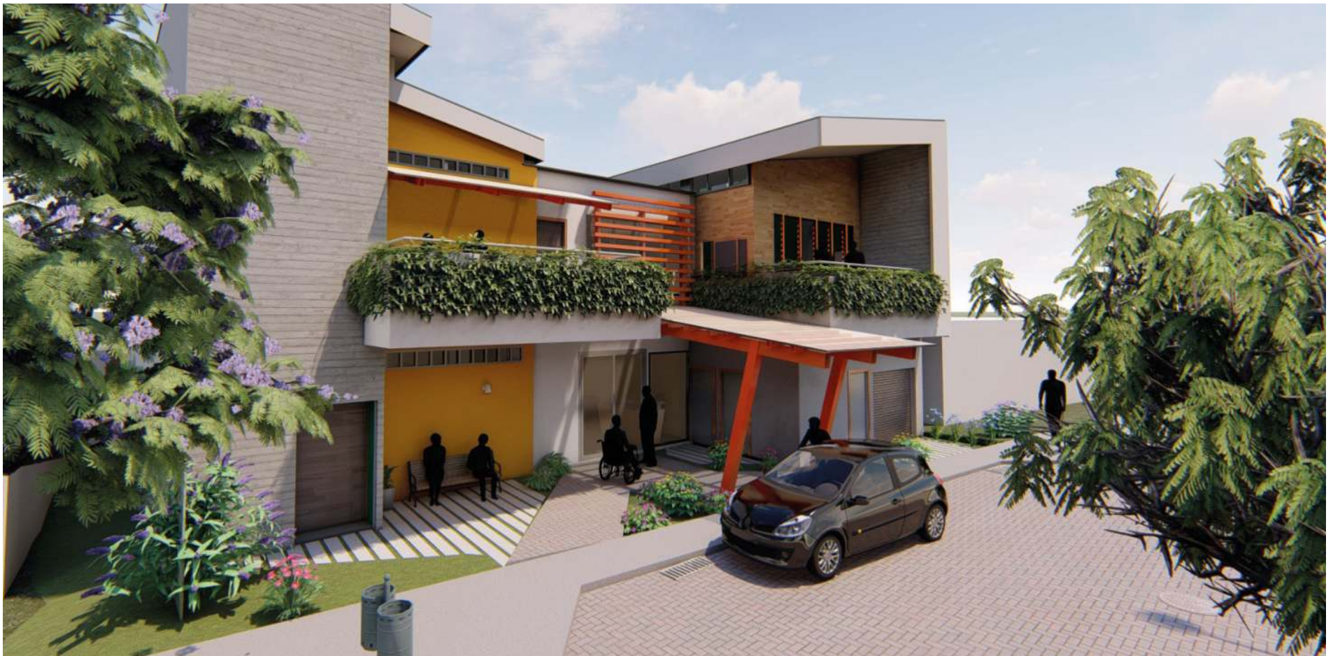
Figura C4.2: Render externo - Centro Diurno de Florencia. Fuente: Elaboración propia (2020)
