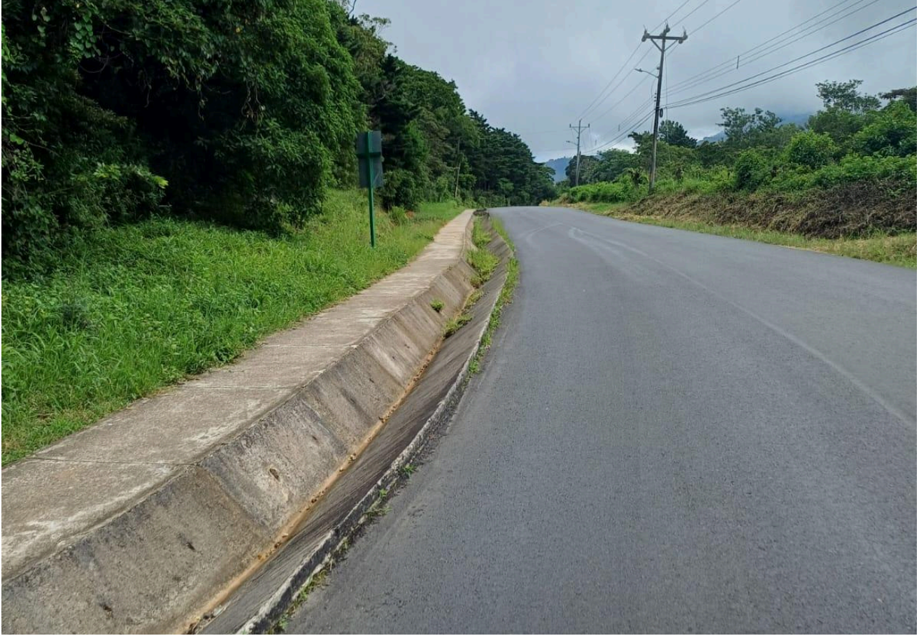
Figura 48. Acera sobre la RN-606 gasolinera JSM urbanización la Colina 2.
