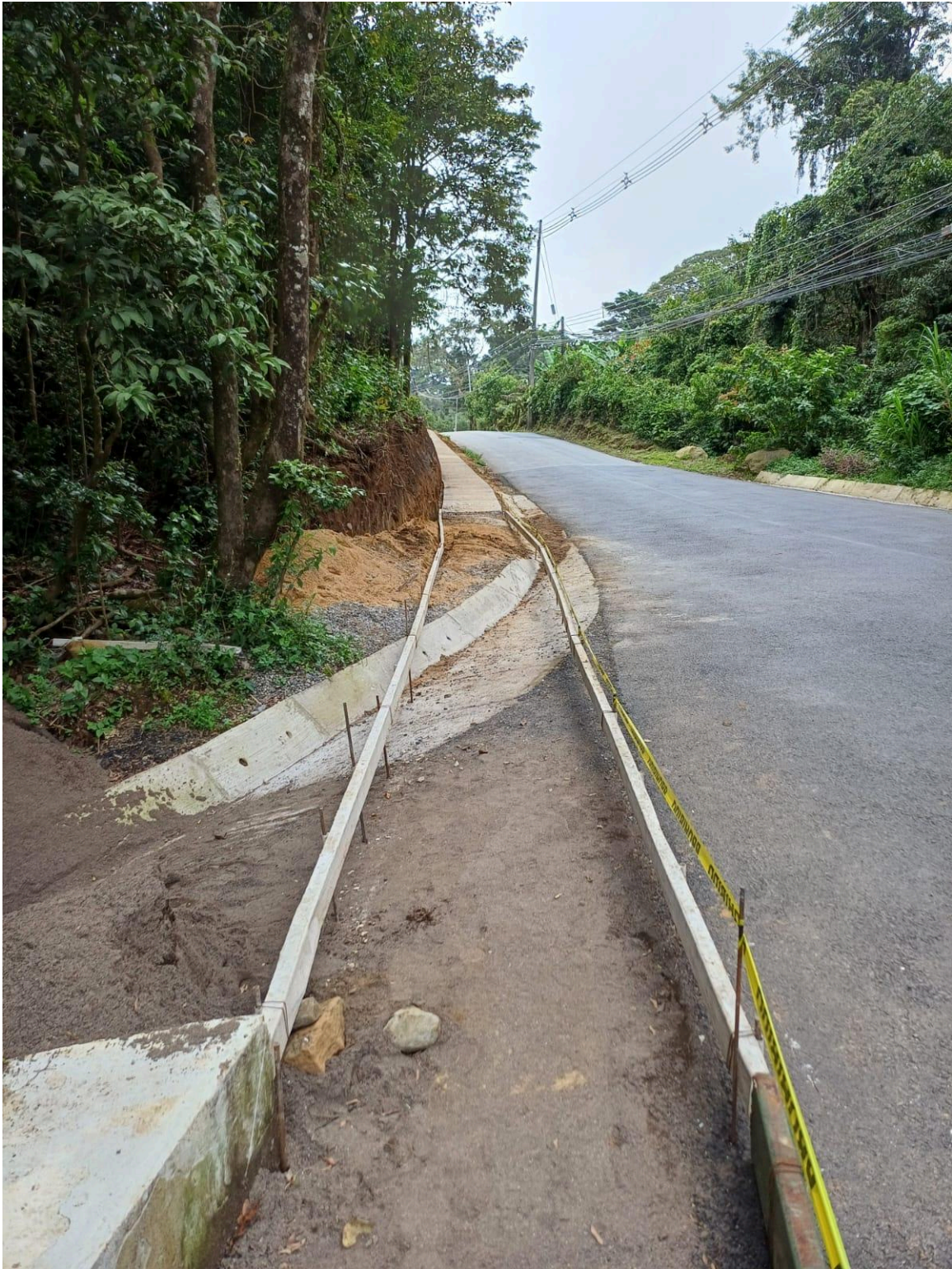
Figura 90. Acera en construcción sobre la RN 606 paso de alcantarilla quebrada intermitente 2.
