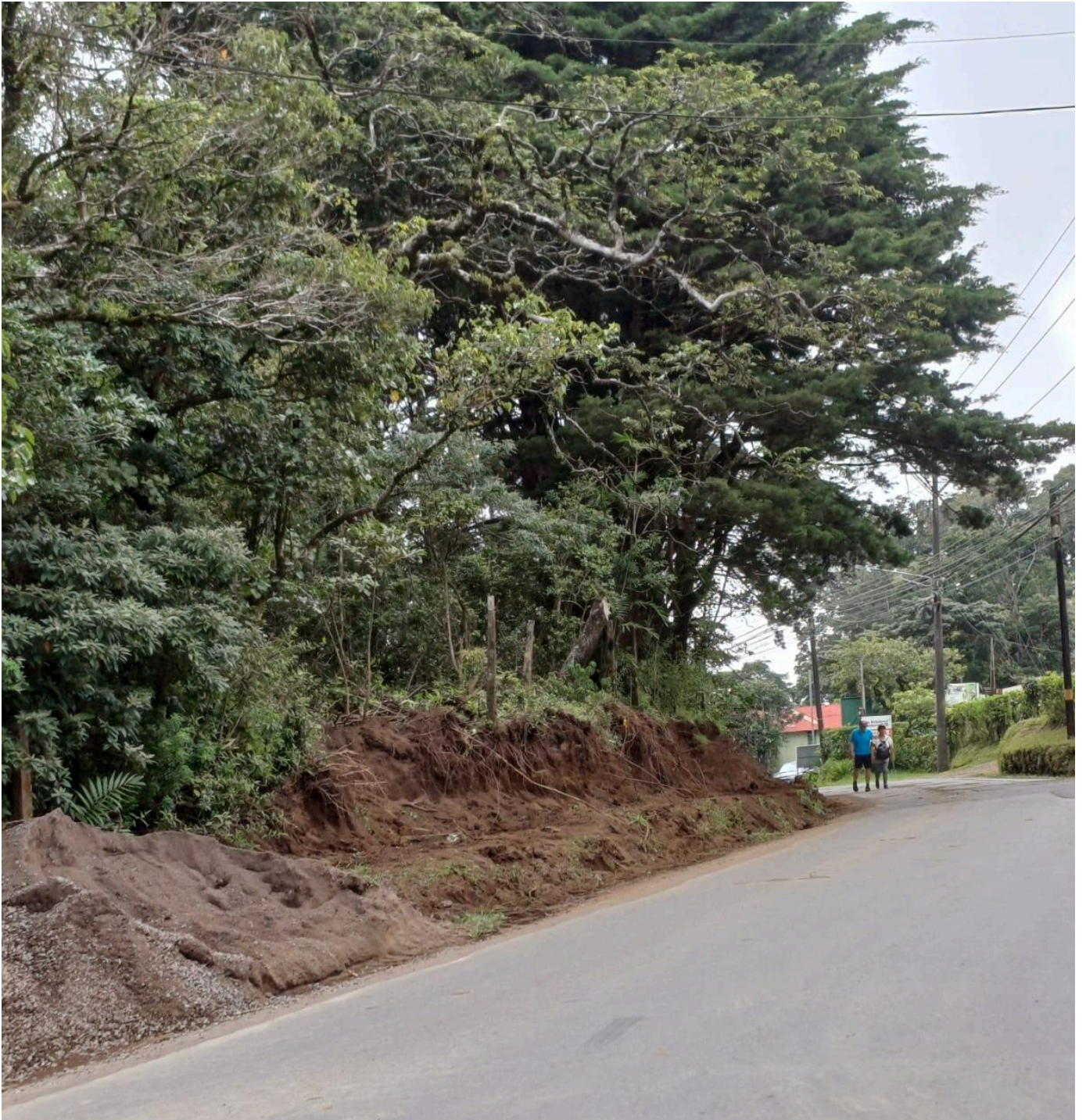
Figura 93. Acera en construcción sobre la RN 606 barrio La Virgen 1.
