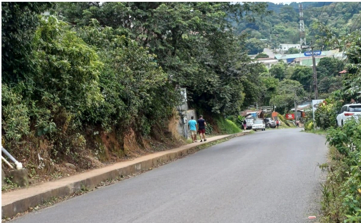
Figura 58. Acera sobre la RN-606 tramo entre entronques con RC-612011 y RN-620 pt.2.
