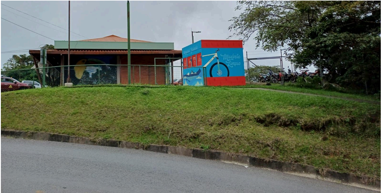
Figura 159. Acera sobre RC 612038 Plaza Comercial Monteverde 3.
