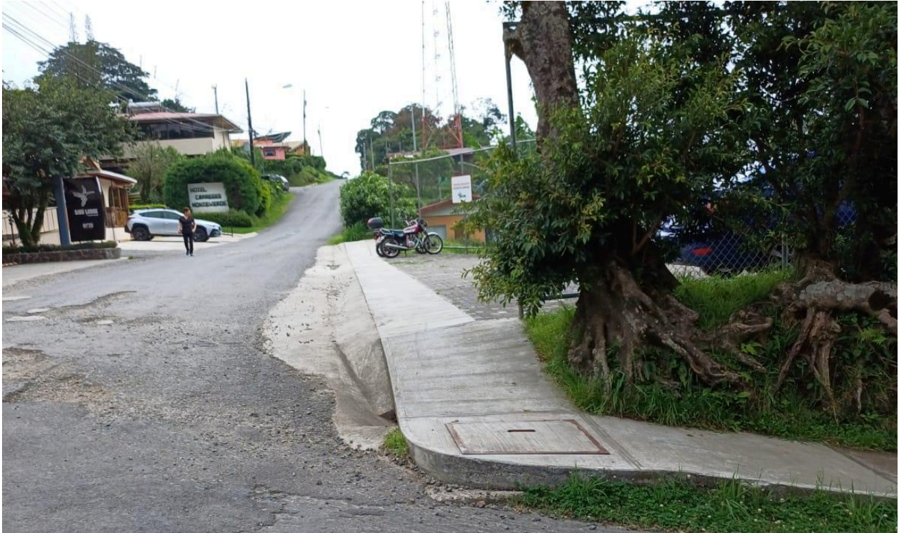
Figura 108. Acera sobre RC 612033 Sibü Lodge.
