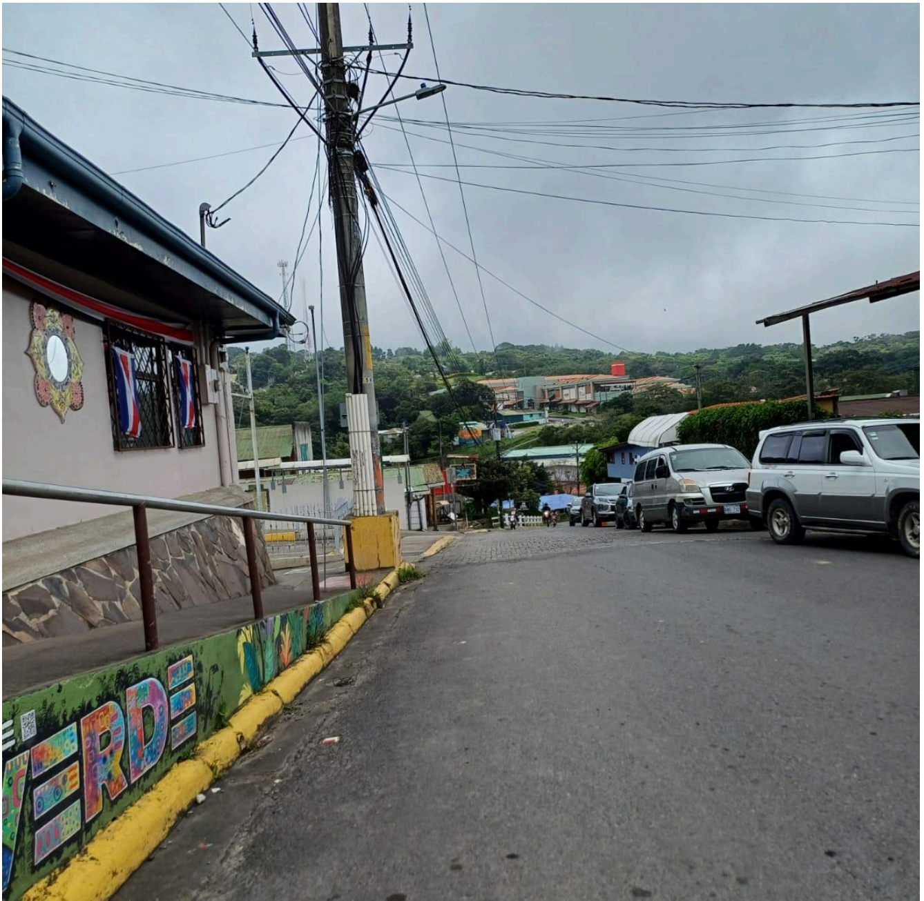
Figura 64. Acera sobre la RN-606 Santa Elena 5.
