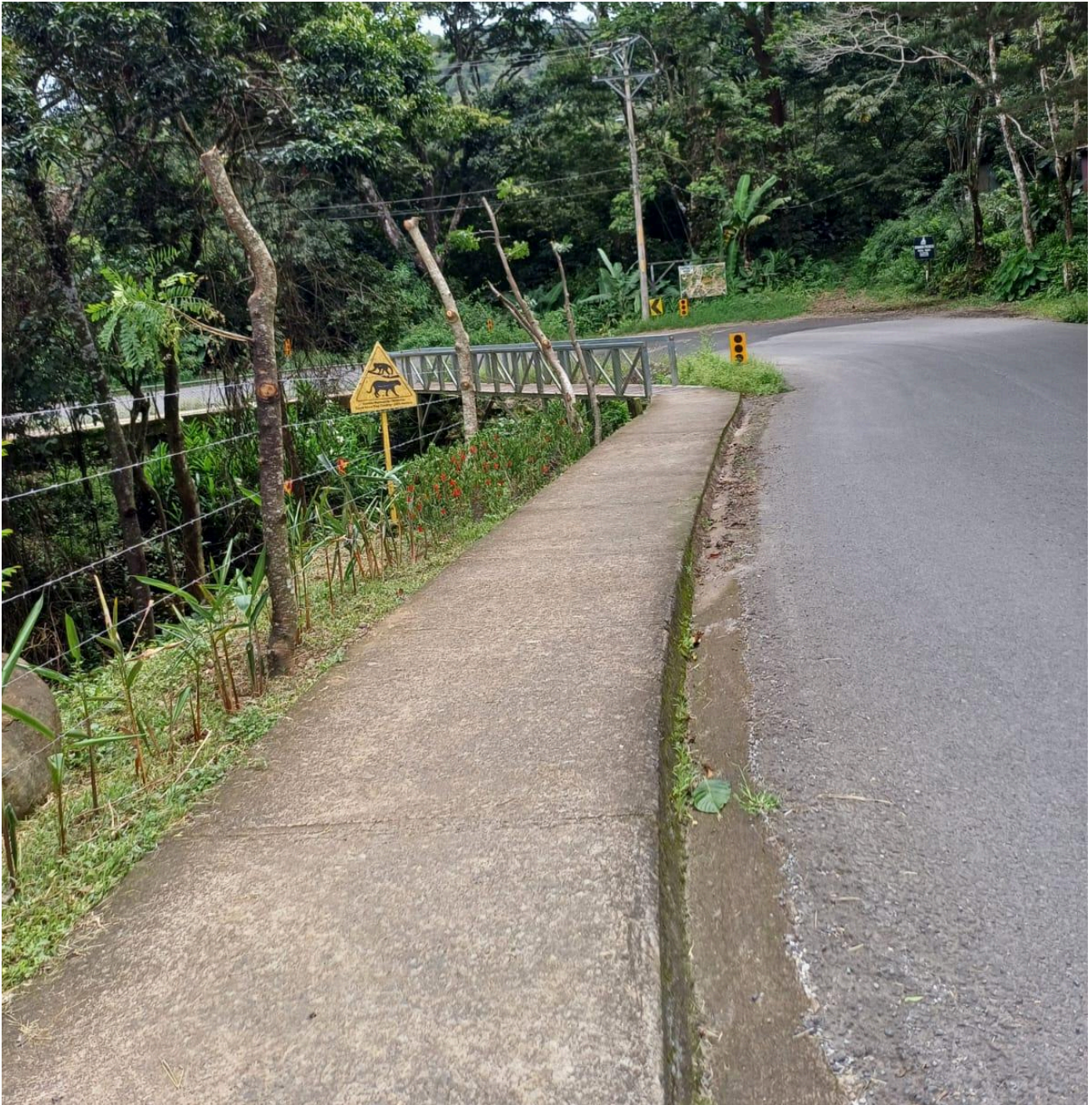
Figura 145. Acera sobre la RN 620 puente peatonal 2.
