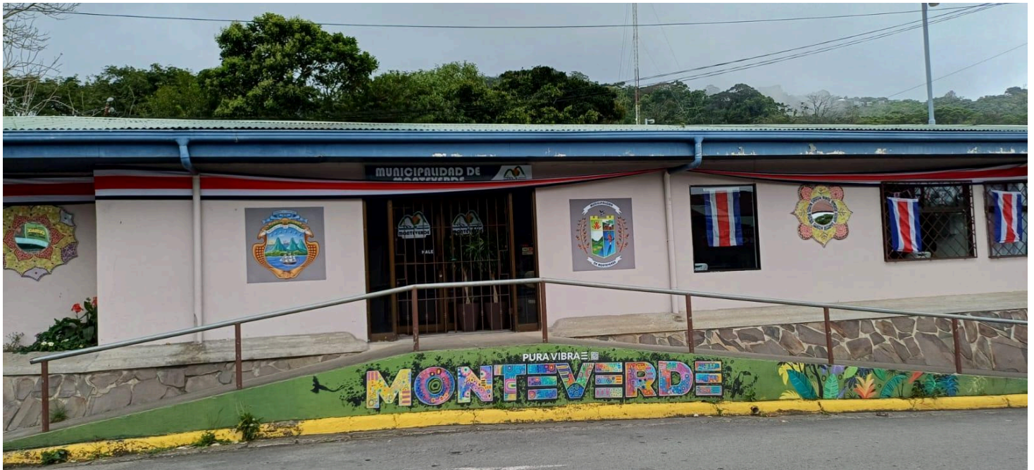
Figura 65. Acera sobre la RN-606 Municipalidad de Monteverde.
