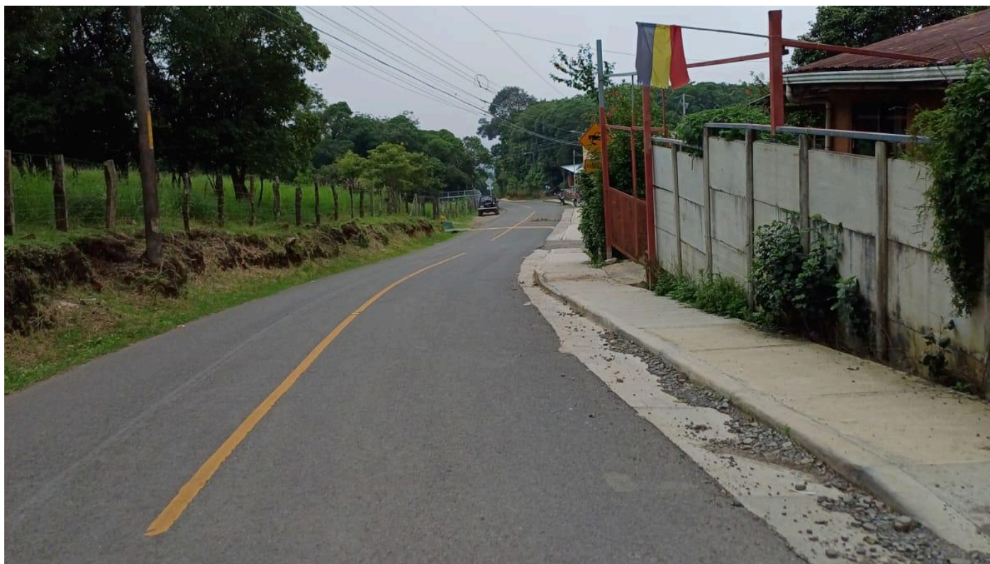
Figura 135. Acera sobre RC 612011 Valle Bonito 4.
