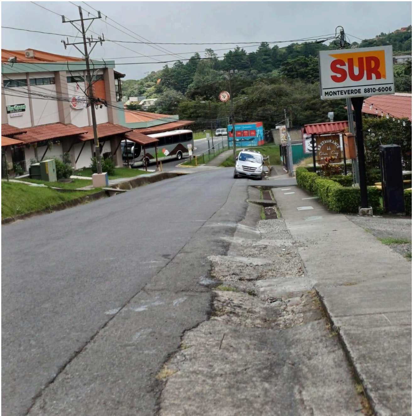
Figura 158. Acera sobre RC 612038 Plaza Comercial Monteverde 2.
