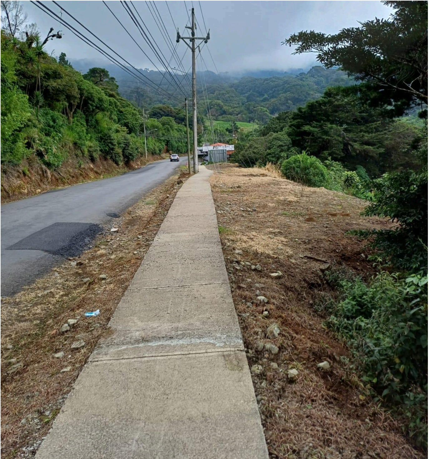
Figura 98. Acera sobre la RN 606 Don Juan - Trapiche 2.
