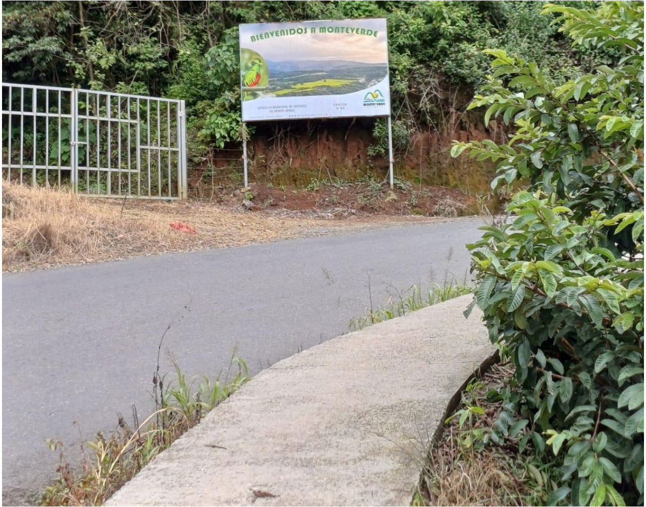
Figura 103. Acera sobre la RN 606 Don Juan - Trapiche 7.
