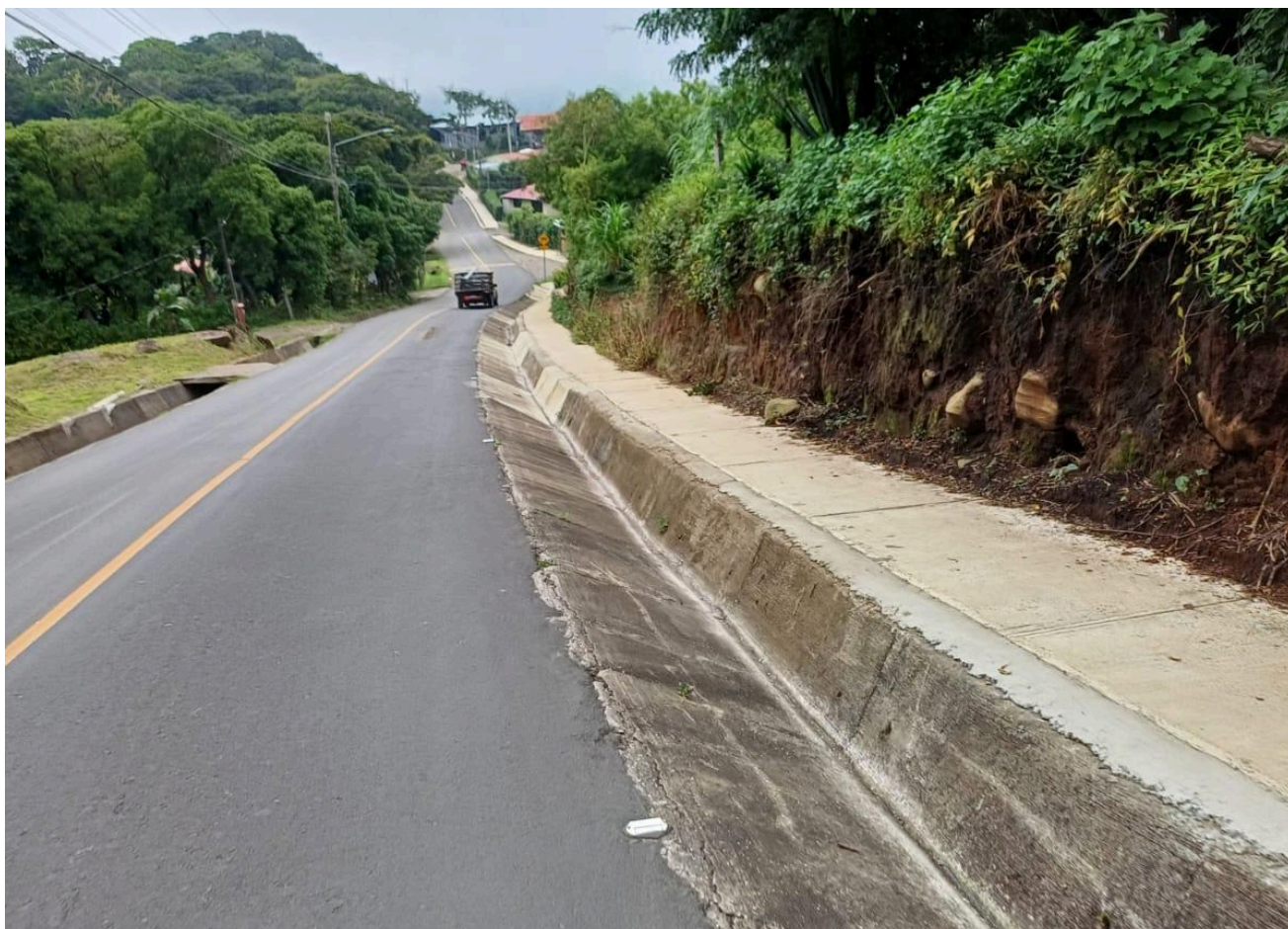
Figura 130. Acera sobre RC 612011 Valle Bonito 1.
