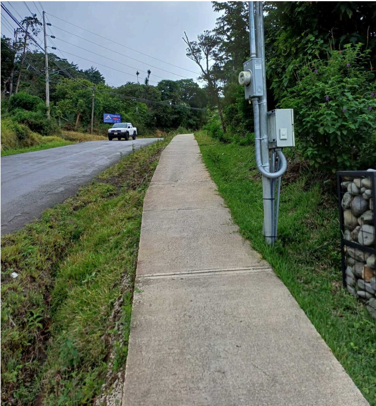
Figura 100. Acera sobre la RN 606 Don Juan - Trapiche 4.
