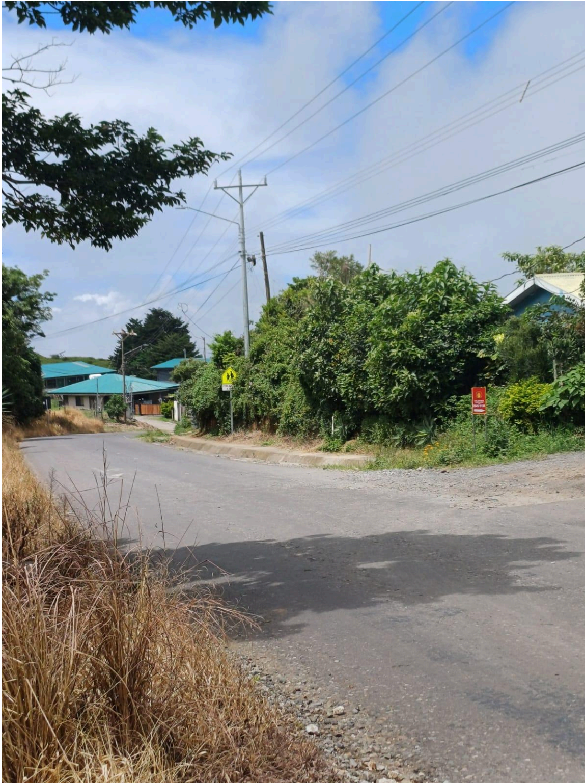
Figura 44. Acera sobre la RN-606 escuela de los Llanos OIJ 3.
