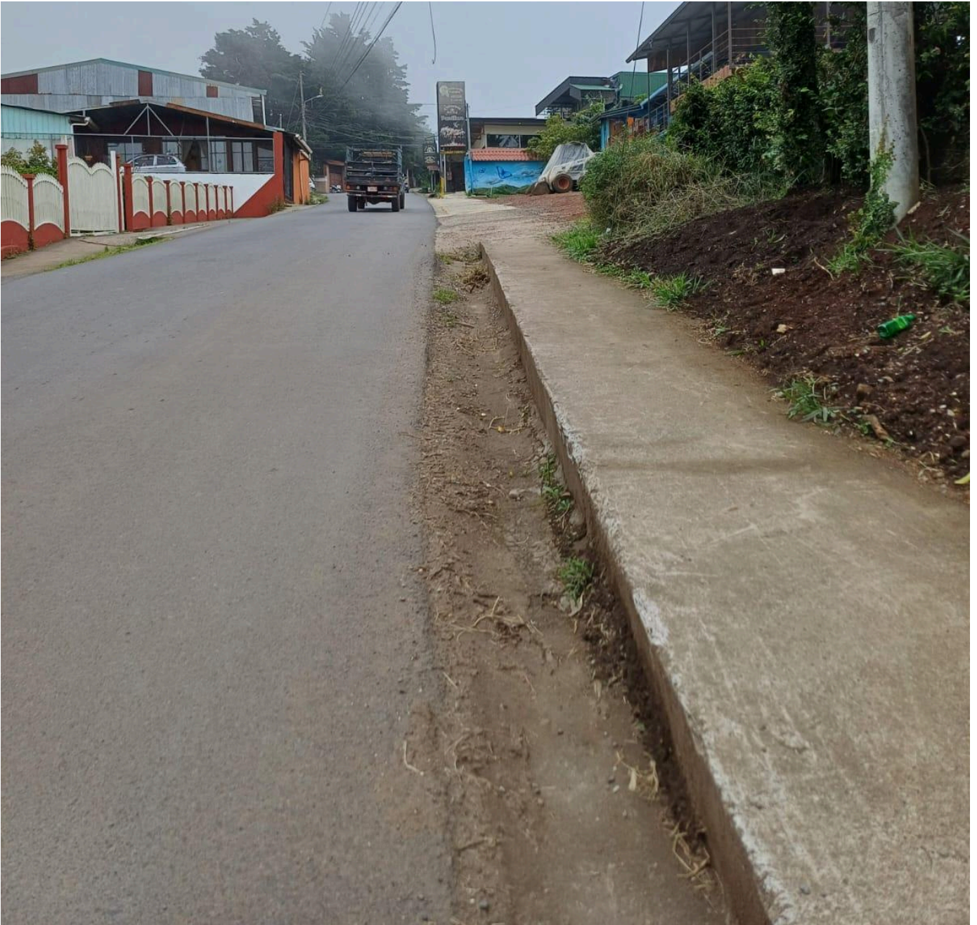
Figura 119. Acera sobre RC 612011 entronque con RN 606.
