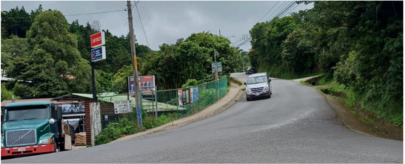
Figura 59. Acera sobre la RN-606 entronque con RN-620.
