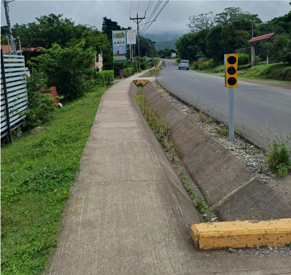
Figura 47. Acera sobre la RN-606 gasolinera JSM urbanización la Colina 1.
