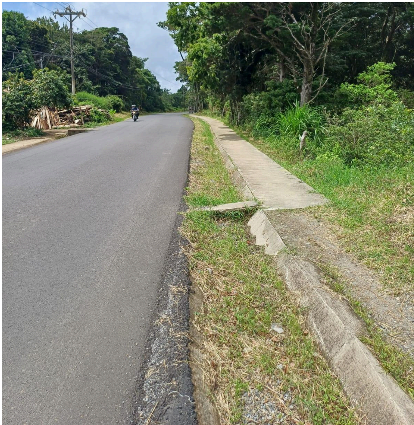
Figura 49. Acera sobre la RN-606 gasolinera JSM urbanización la Colina 3.
