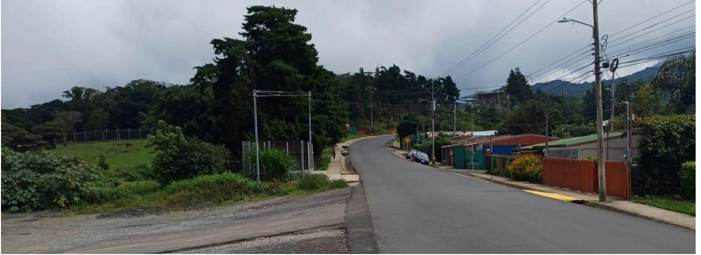
Figura 51. Acera sobre la RN-606 urbanización la Colina 2.
