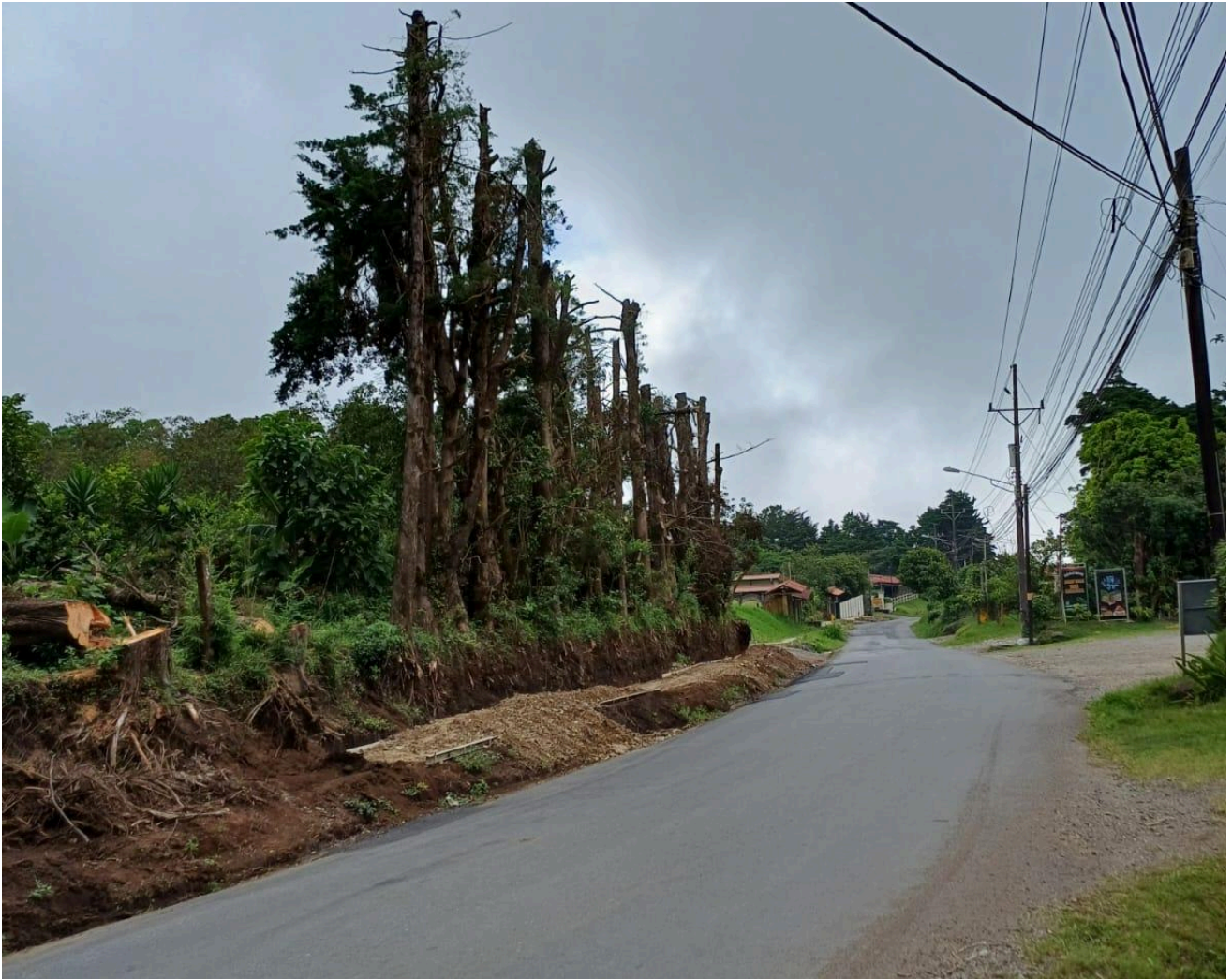
Figura 94. Acera en construcción sobre la RN 606 barrio La Virgen 2.
