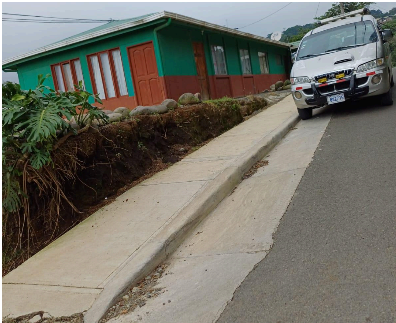
Figura 134. Acera sobre RC 612011 Valle Bonito 3.
