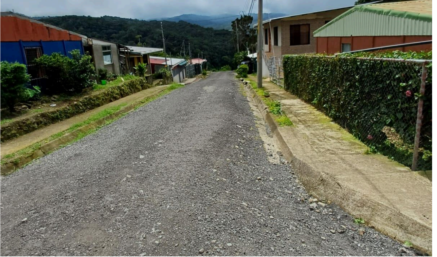
Figura 52. Acera sobre la RC-612056 urbanización la Colina 2.
