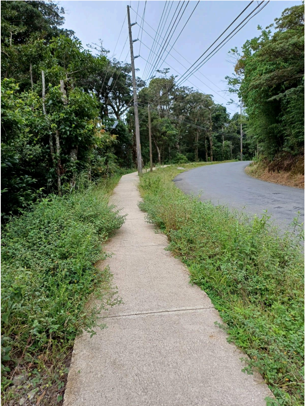
Figura 99. Acera sobre la RN 606 Don Juan - Trapiche 3.
