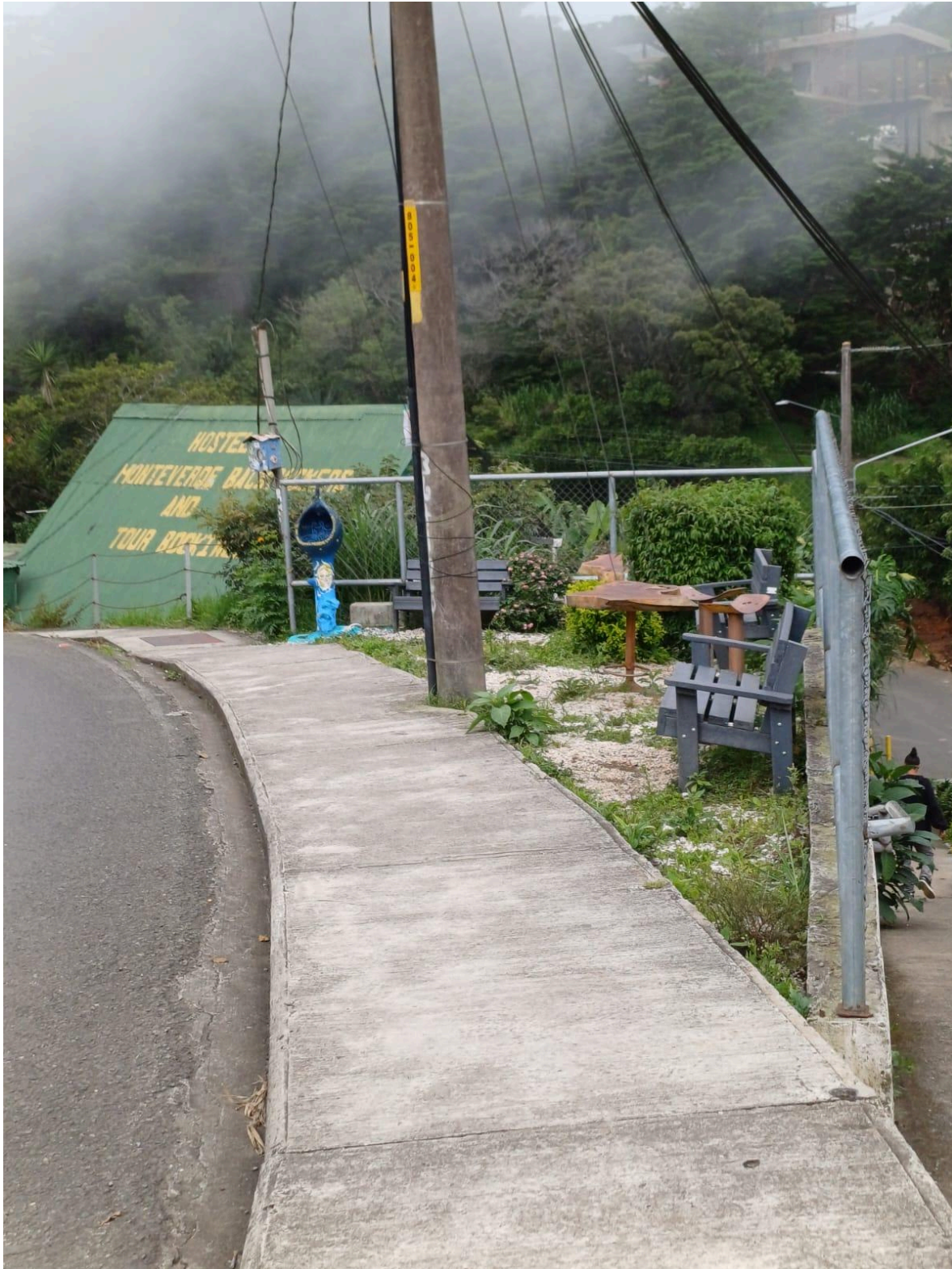
Figura 60. Acera sobre la RN-606 Santa Elena 1.
