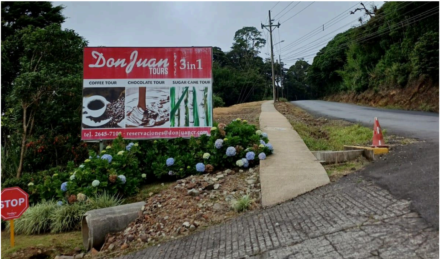
Figura 97. Acera sobre la RN 606 Don Juan - Trapiche 1.
