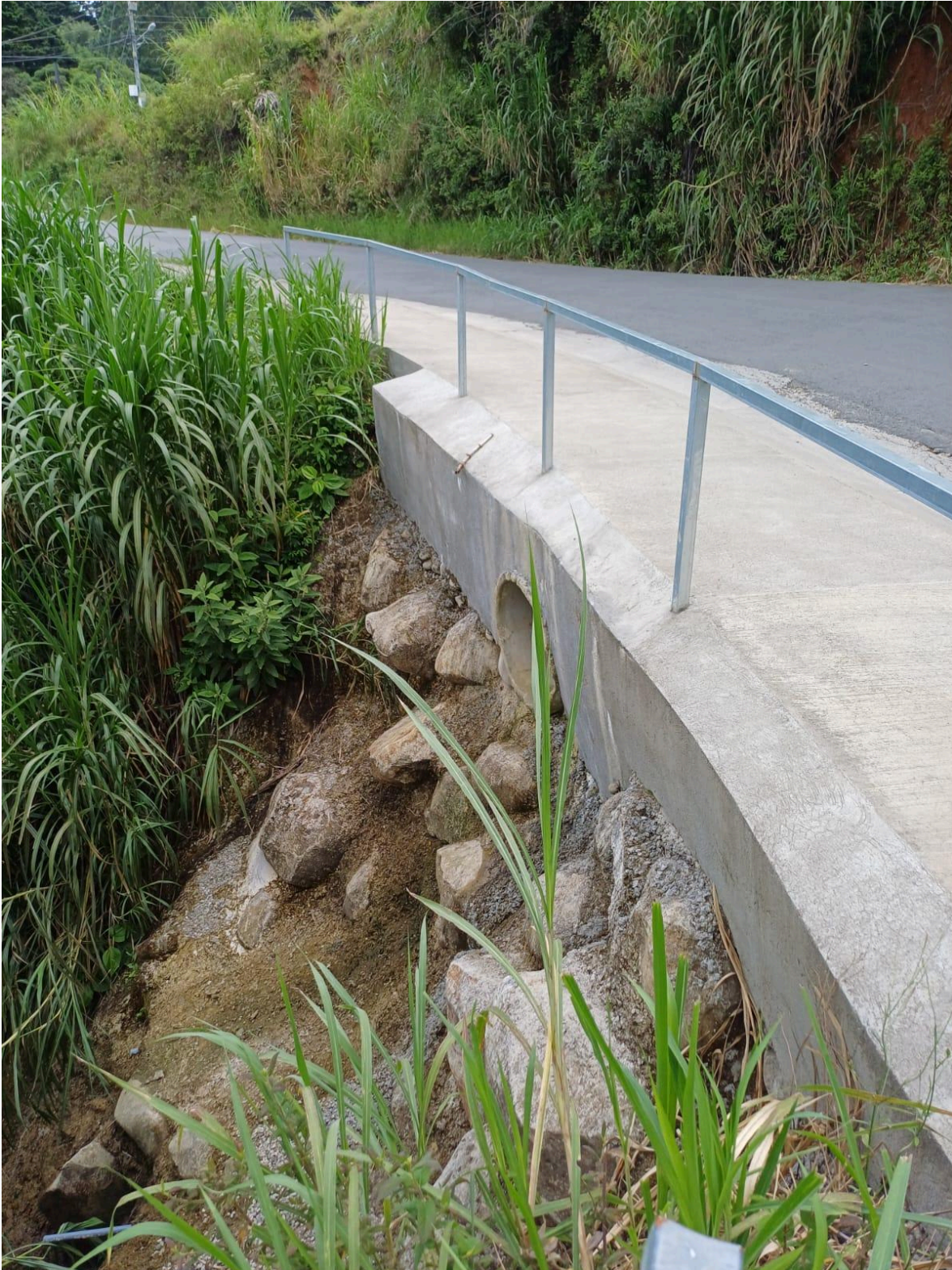
Figura 182. Acera sobre RN 620 paso de alcantarilla gasolinera Cerro Plano.
