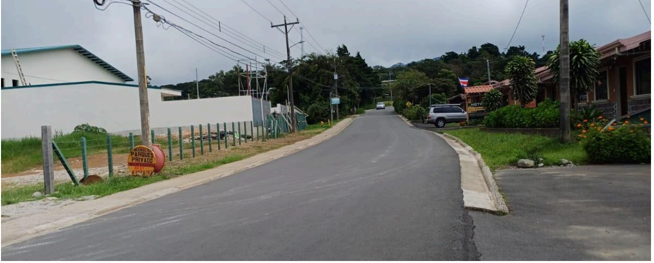
Figura 55. Acera sobre la RN-606 barrio Las Orquídeas 2.
