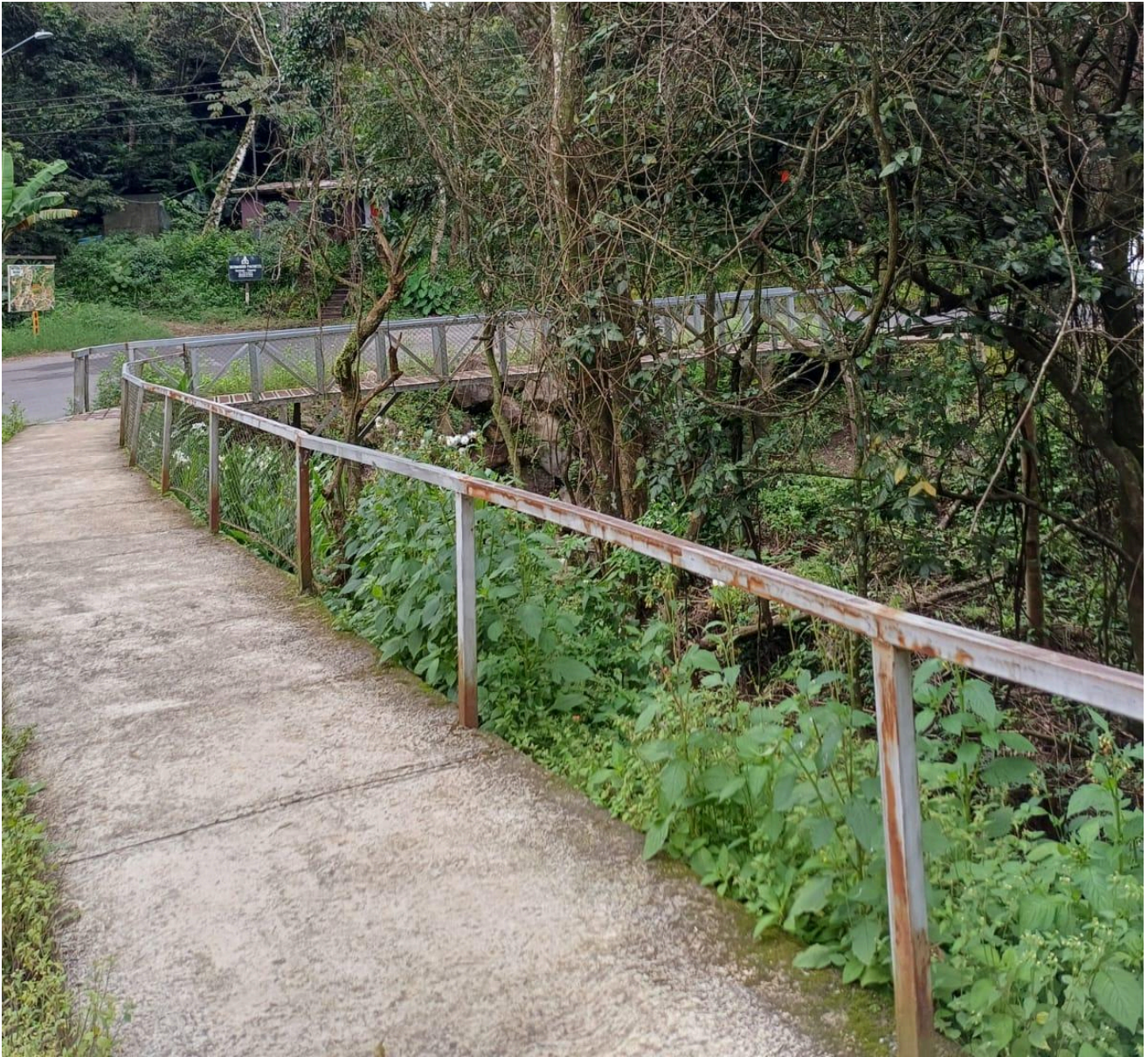
Figura 144. Acera sobre la RN 620 puente peatonal 1.
