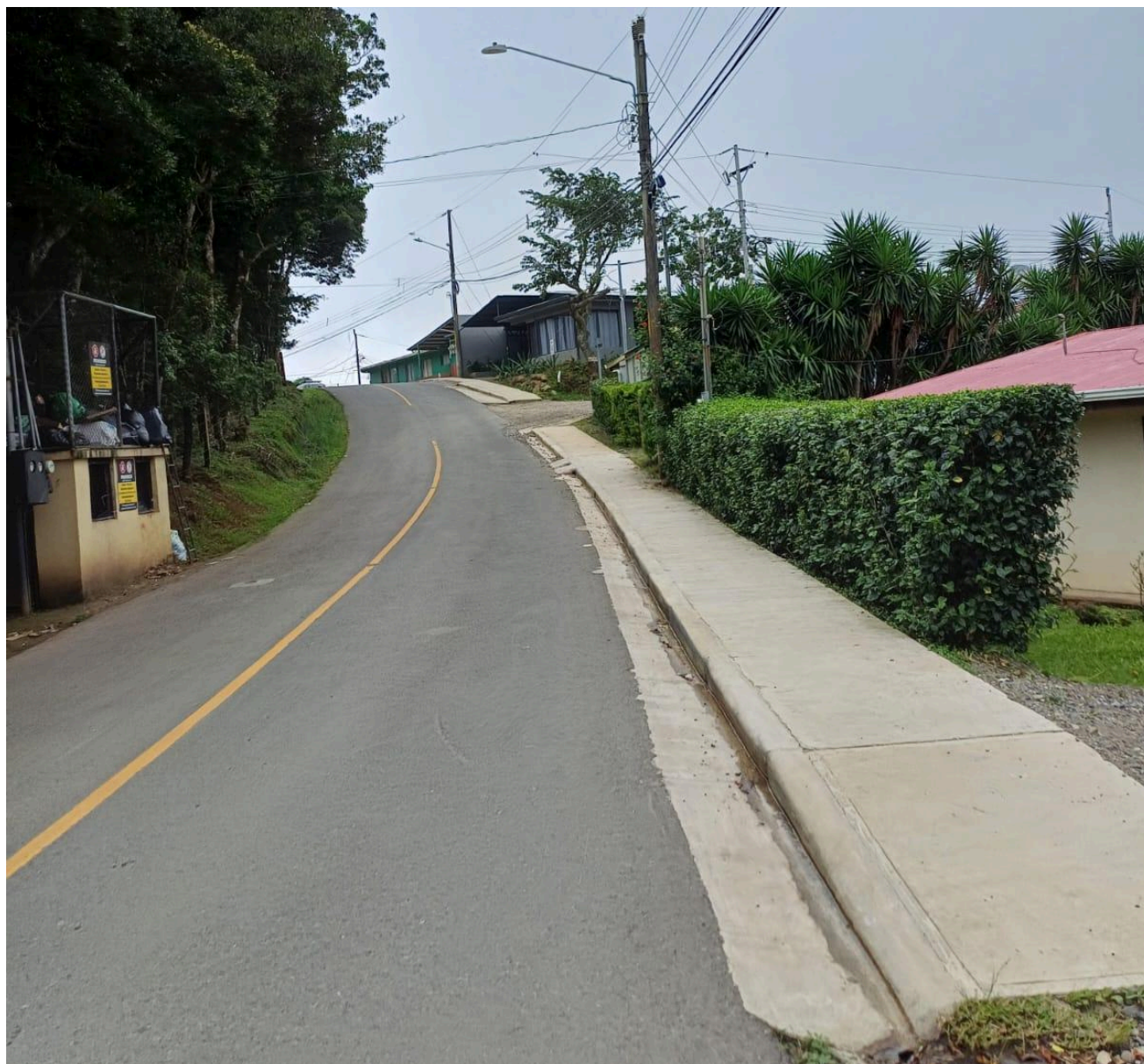
Figura 133. Acera sobre RC 612011 Valle Bonito 2.
