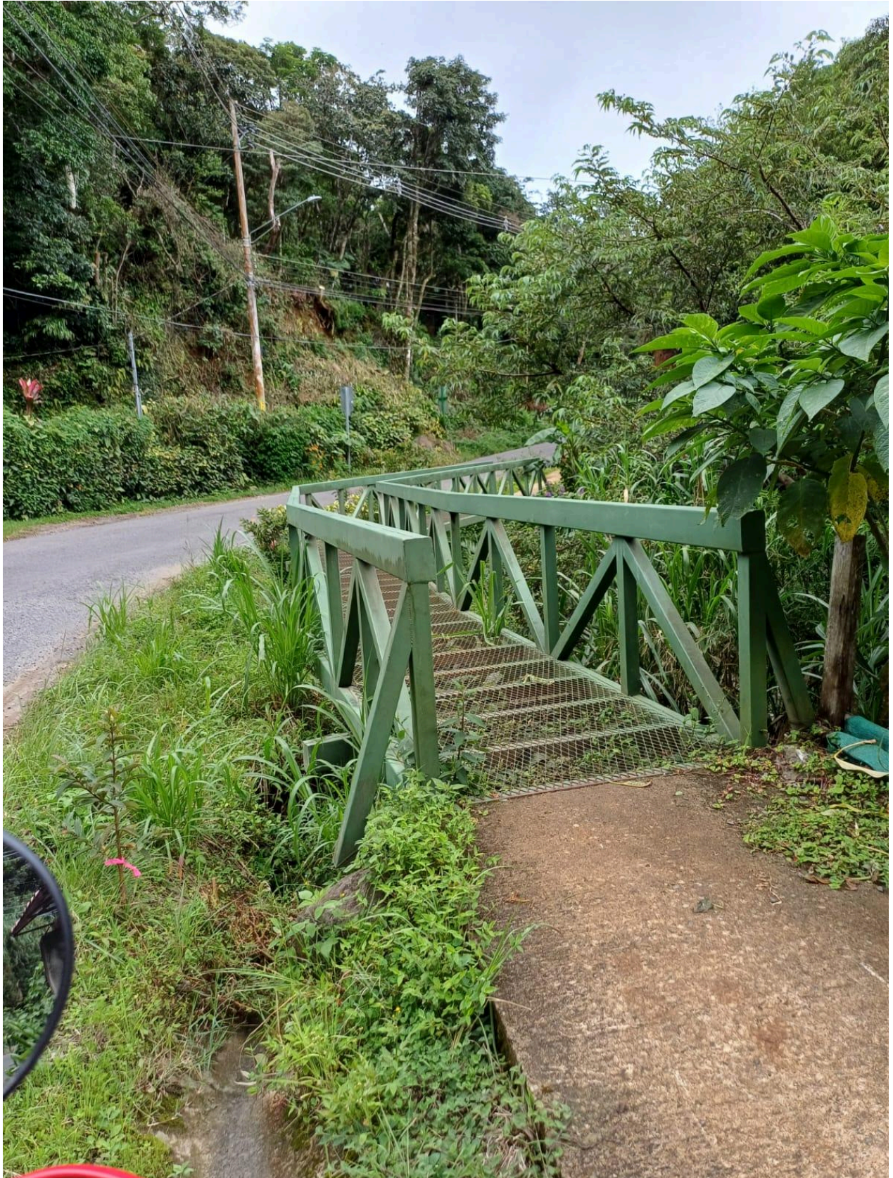
Figura 185. Puente peatonal sobre RN 620 Monteverde quebrada Máquina.
