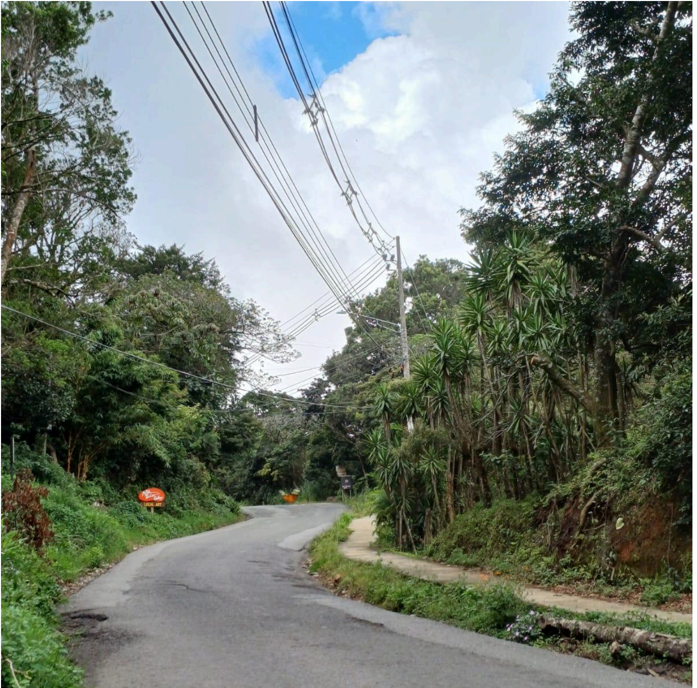
Figura 187. Acera sobre RN 620 Monteverde Catarata Murciélagos 1.
