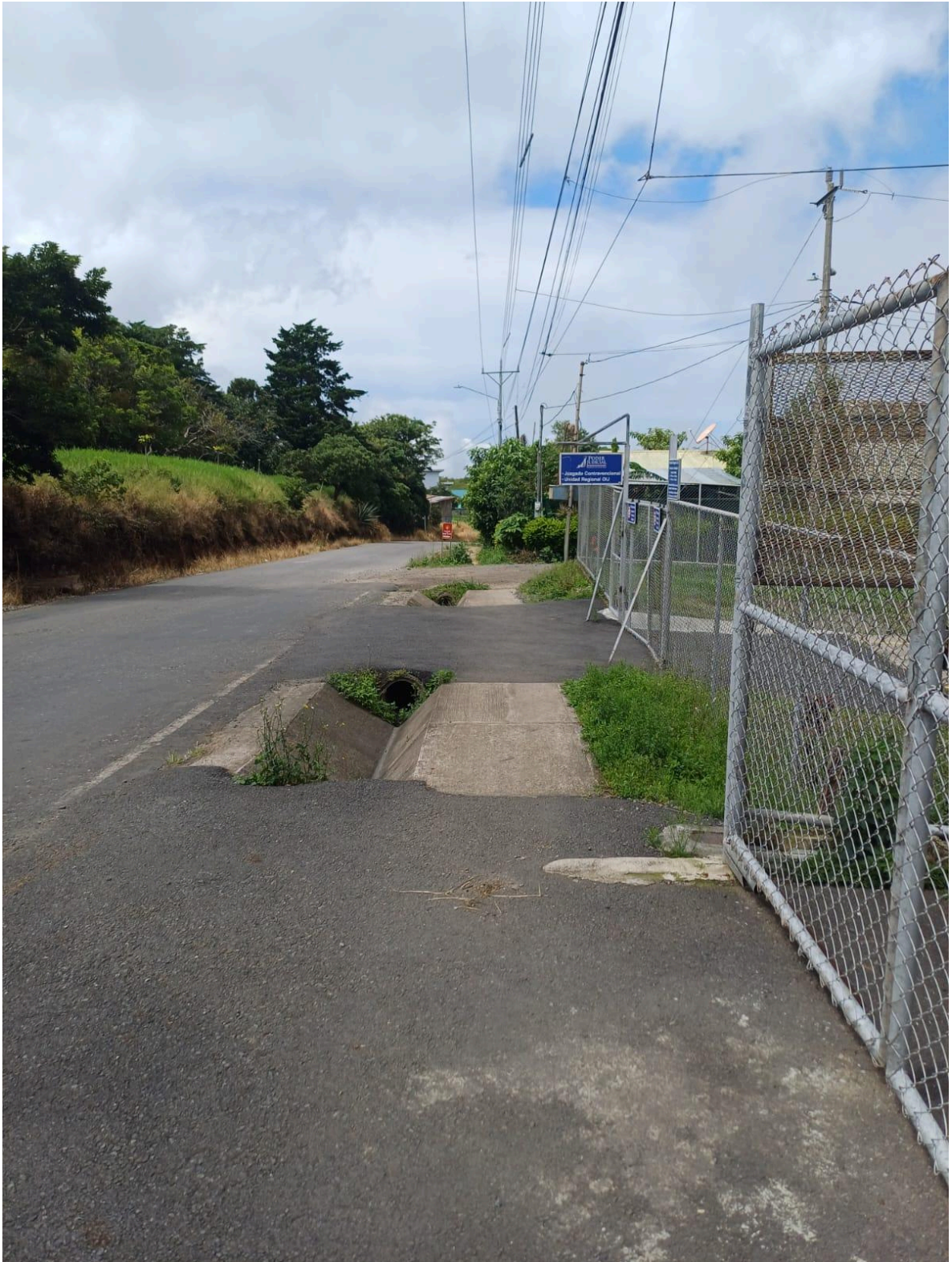
Figura 45. Acera sobre la RN-606 OIJ.
