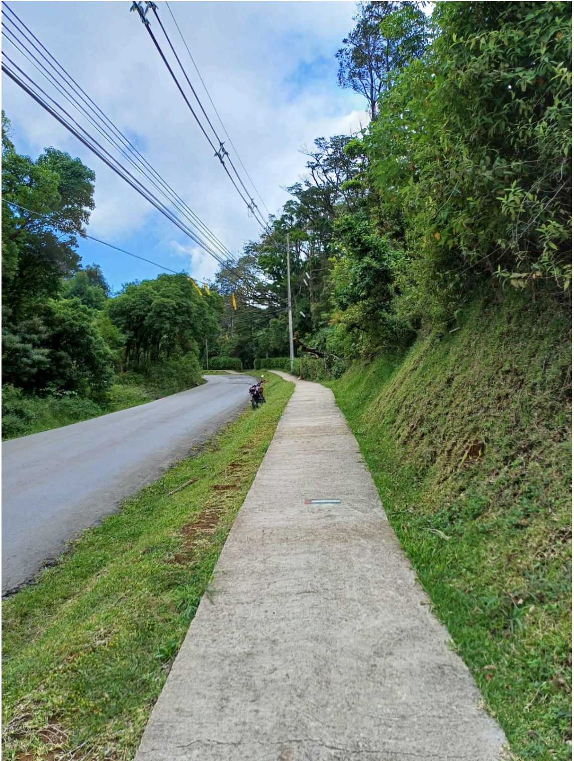
Figura 194. Acera sobre RN 620 Monteverde 3.
