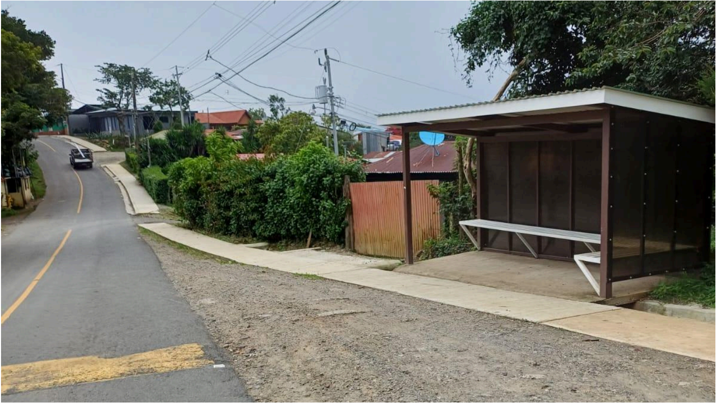
Figura 131. Acera sobre RC 612011 parada de bus Valle Bonito.
