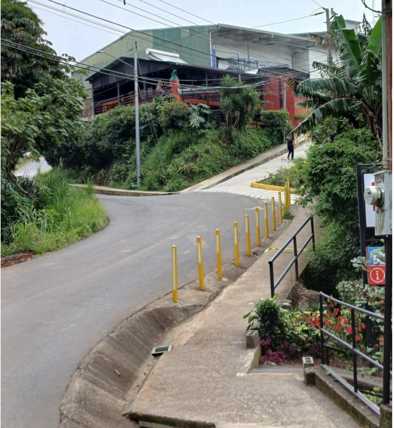
Figura 140. Acera sobre RC 612023 Cabinas El Pueblo.
