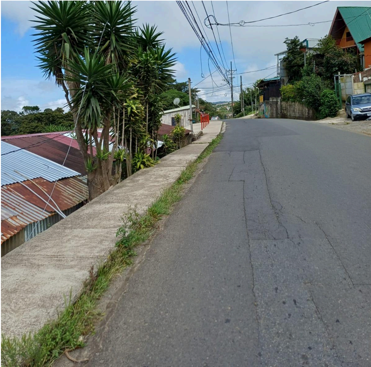
Figura 163. Acera sobre RN 620 muro de gaviones quebrada Sucia Cerro Plano.
