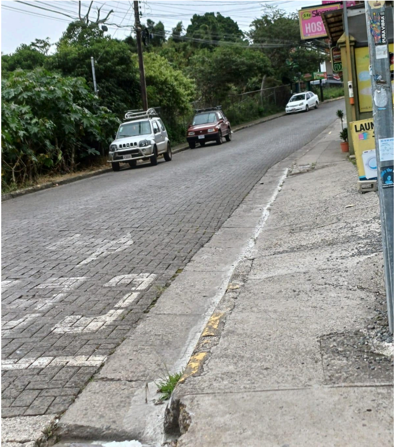
Figura 62. Acera sobre la RN-606 Santa Elena 3.
