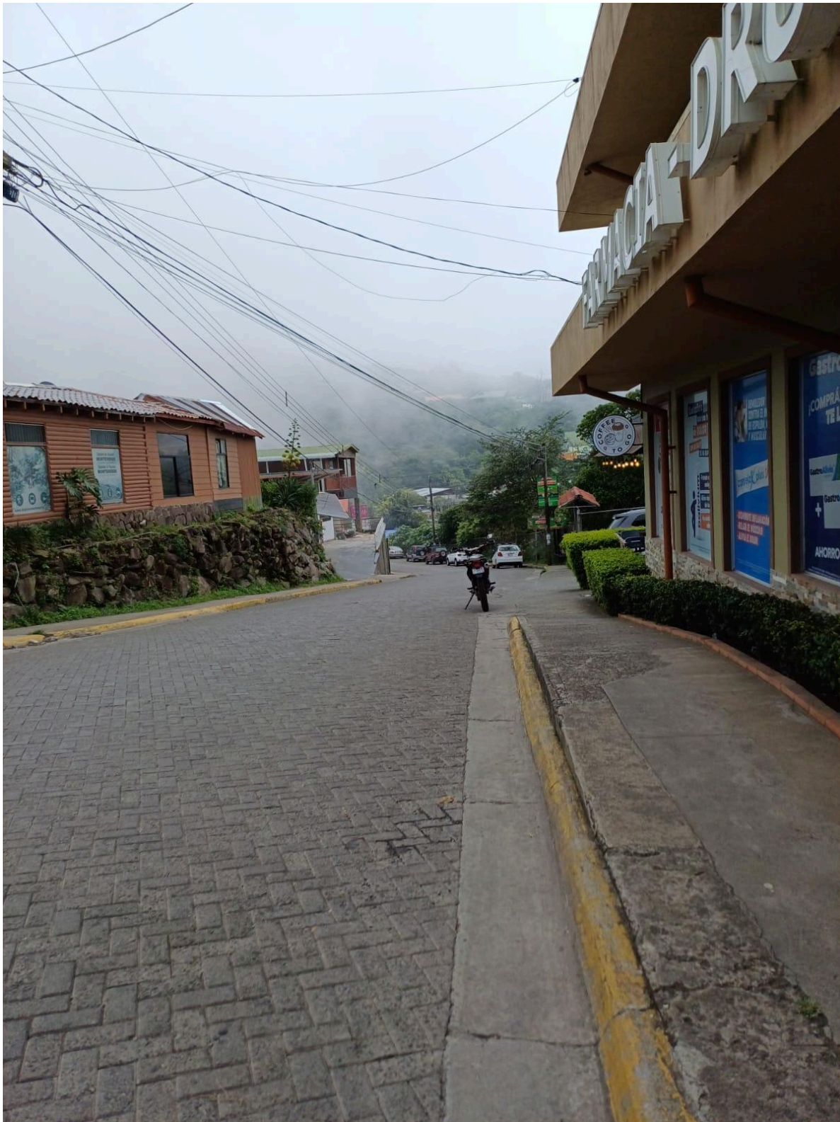
Figura 61. Acera sobre la RN-606 Santa Elena 2.
