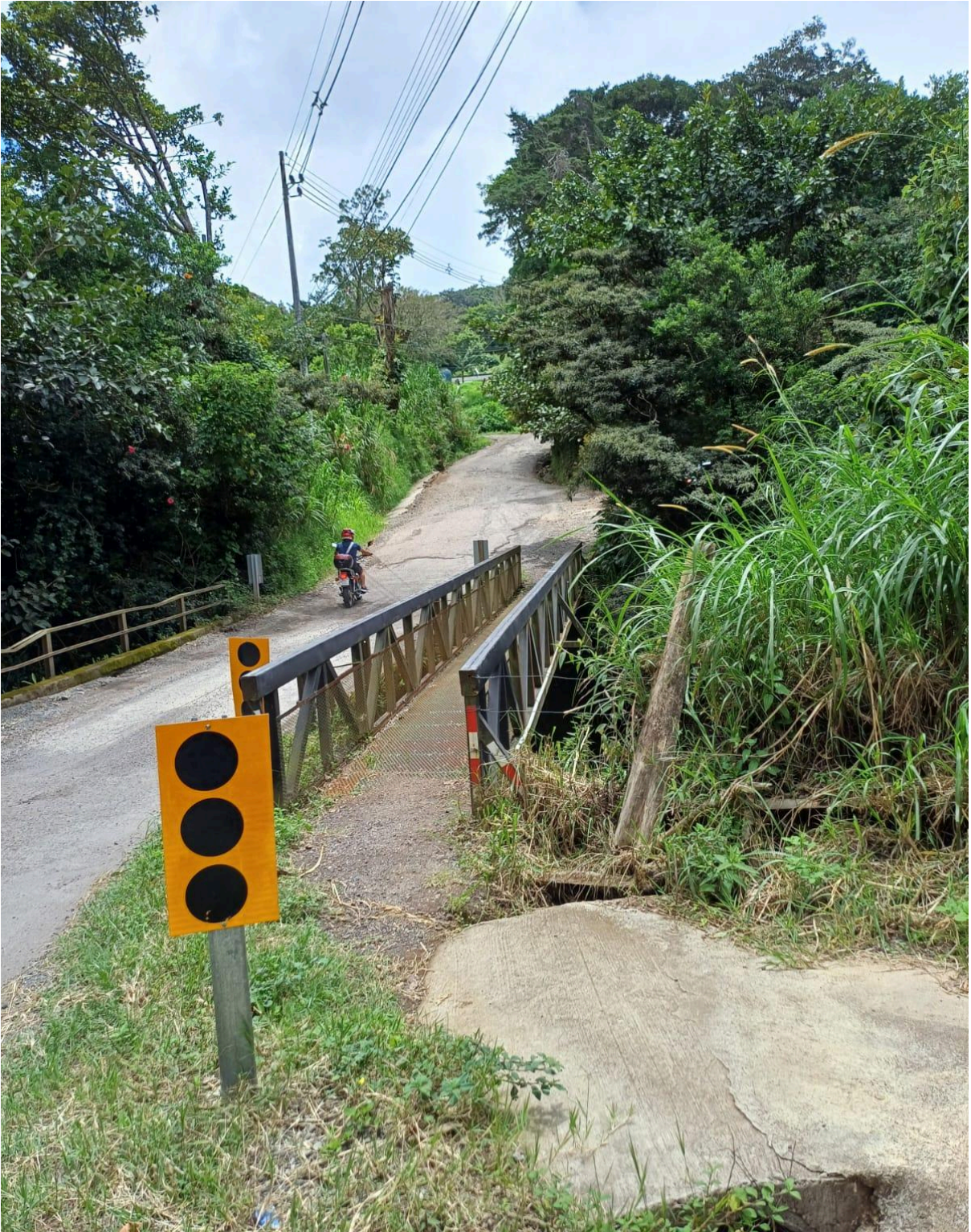
Figura 199. Puente peatonal sobre RN 620 Monteverde río Guacimal 2.
