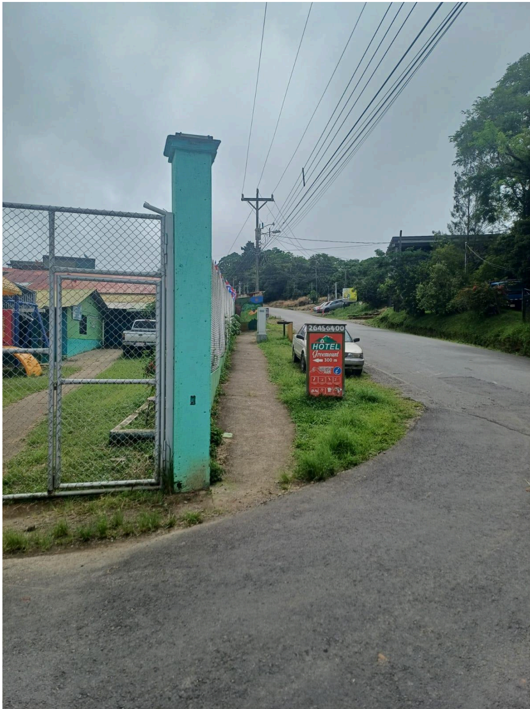
Figura 41. Acera sobre la RN-606 costado sur de la escuela de los Llanos.
