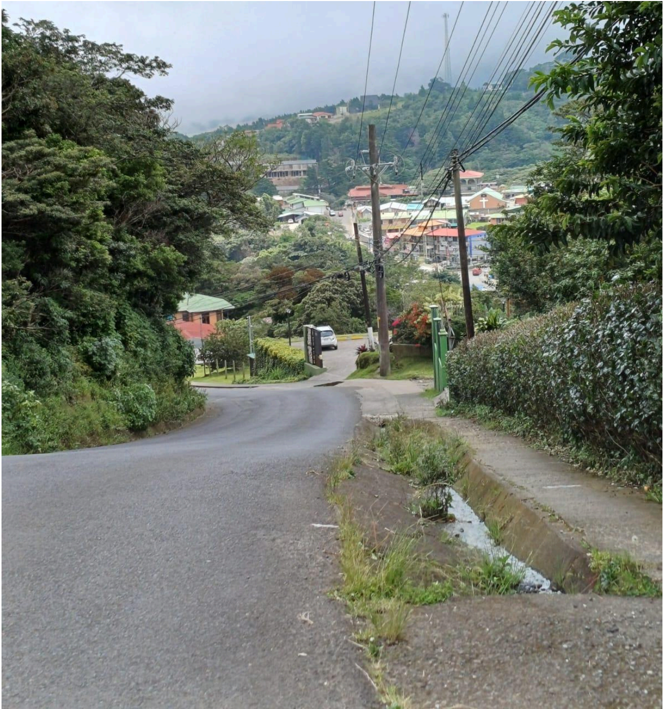
Figura 156. Acera sobre RC 612038 entronque con la RN 620.
