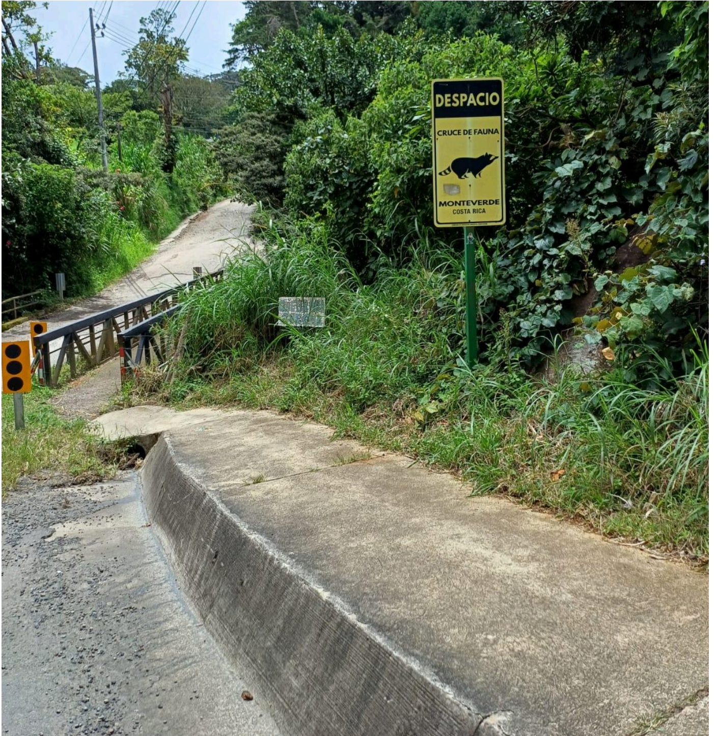
Figura 198. Puente peatonal sobre RN 620 Monteverde Río Guacimal 1.
