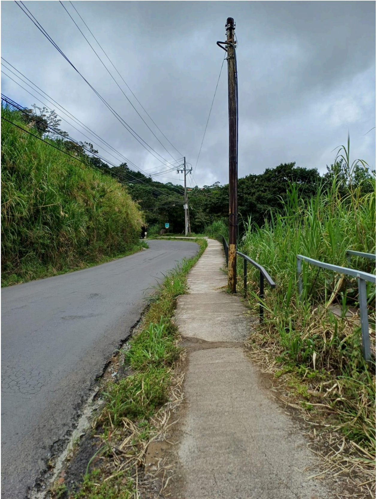
Figura 183. Acera sobre RN 620 Cerro Plano.
