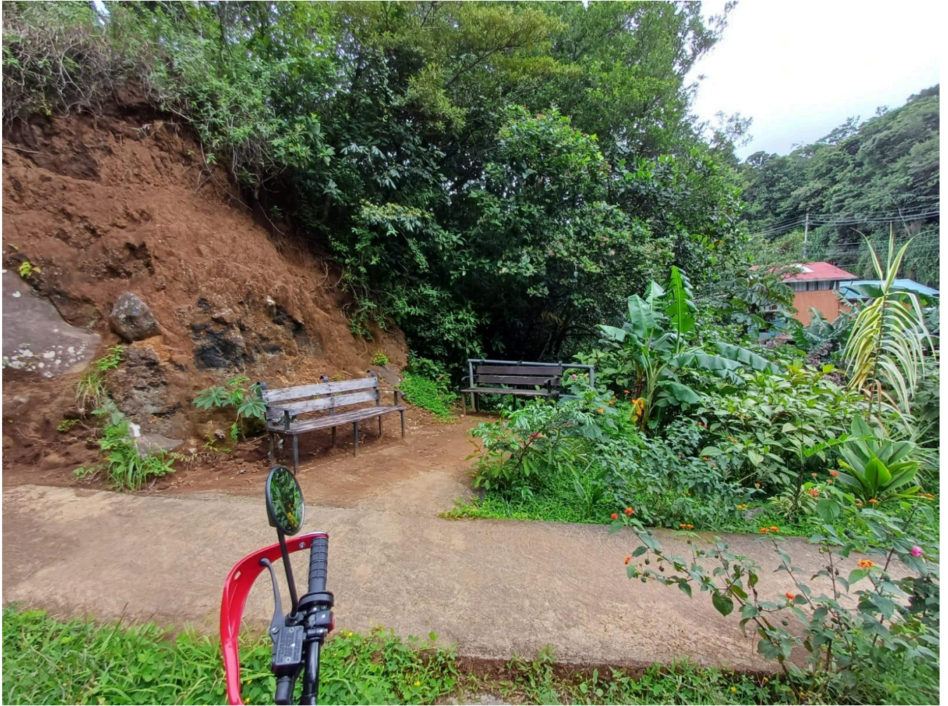
Figura 186. Bancas sobre RN 620 Monteverde quebrada Máquina.
