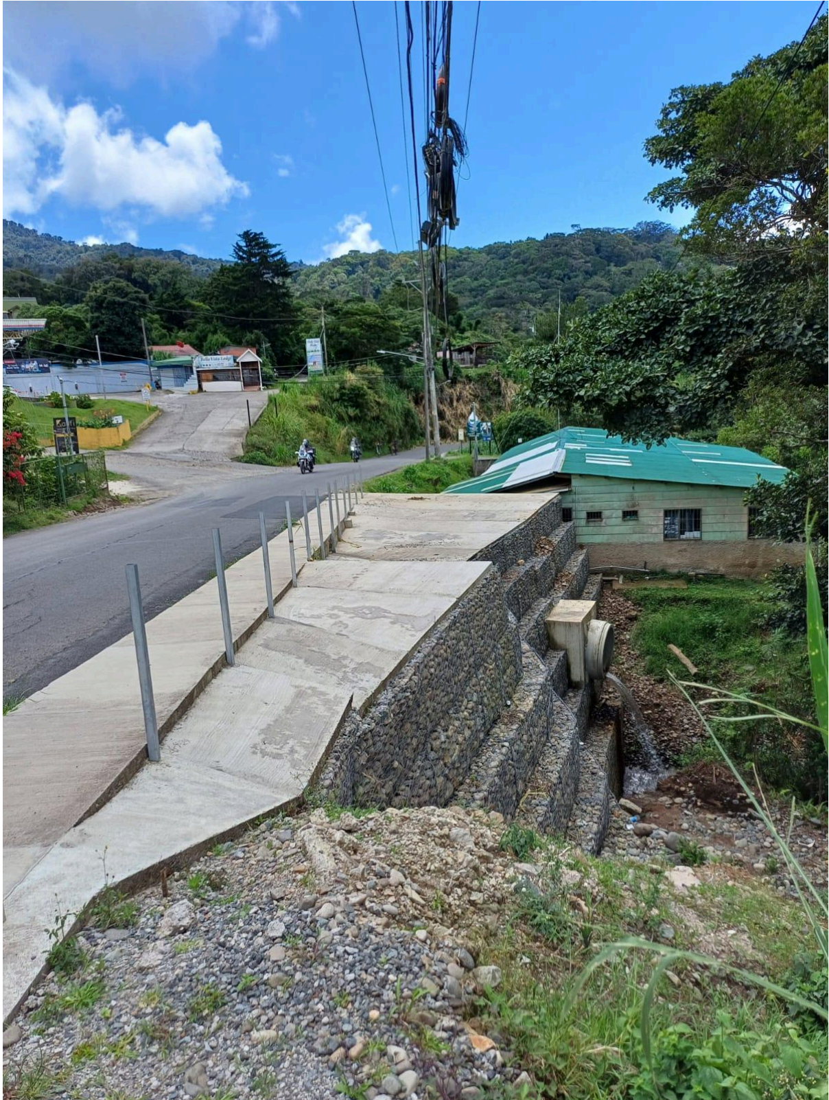
Figura 181. Acera sobre RN 620 entronque con la RC 612047 muro de gaviones Cerro Plano.
