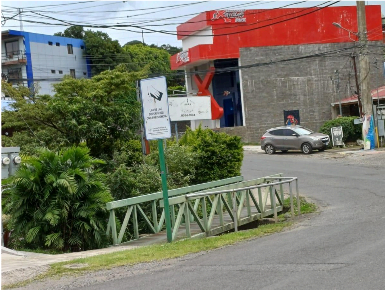
Figura 162. Puente peatonal sobre RC 612038 Santa Elena quebrada intermitente 2.
