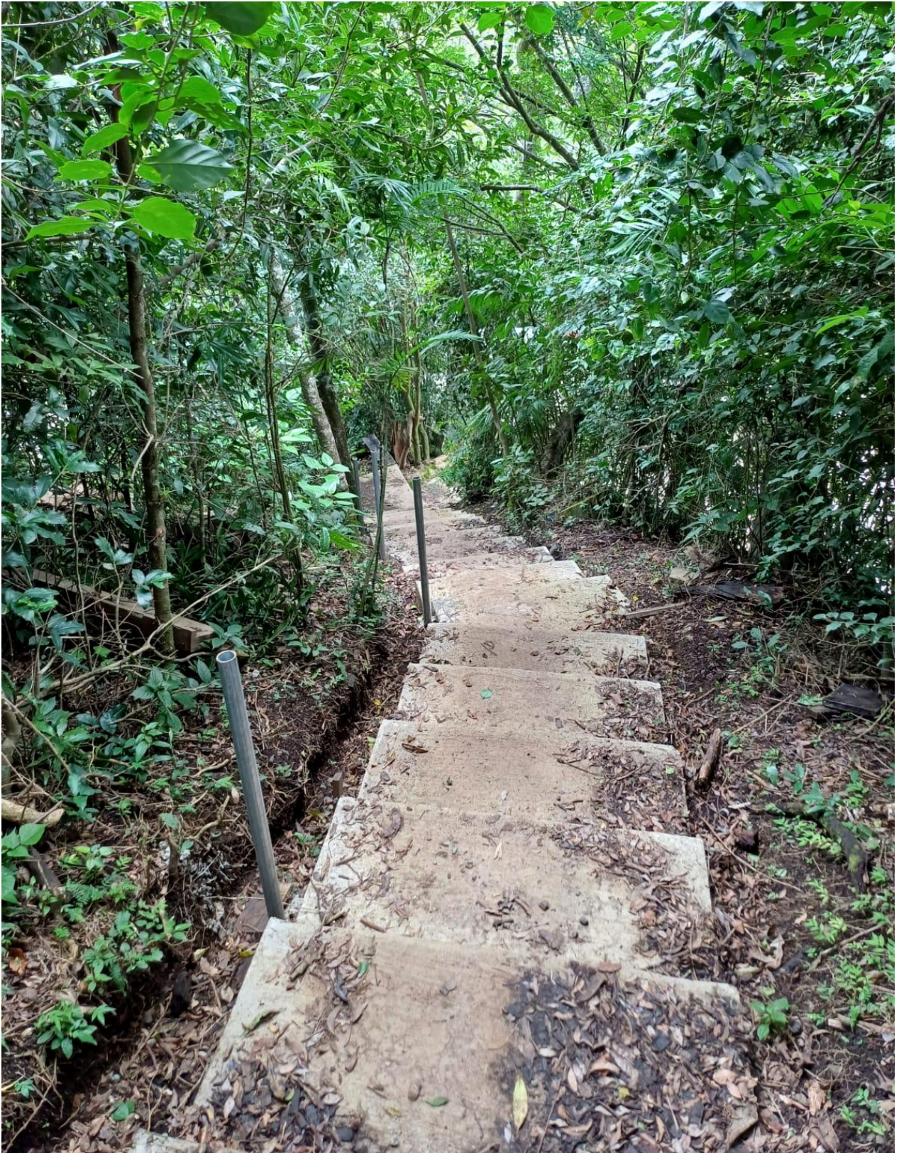
Figura 203. Escaleras sobre RN 620 Monteverde 3.
