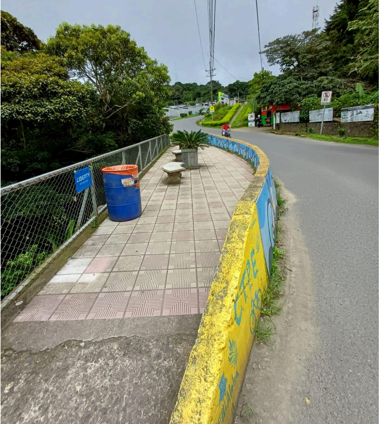
Figura 71. Acera sobre la RN-606 Santa Elena puente peatonal 1.
