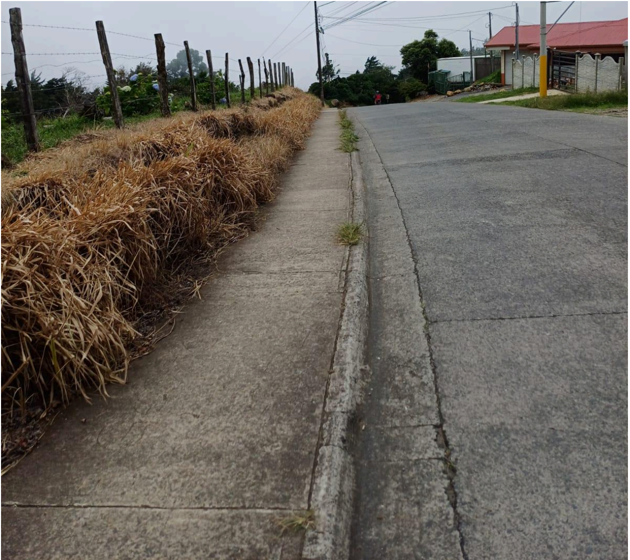
Figura 117. Acera sobre RC 612018 de Bomberos hacia la parroquia nueva de Santa Elena 1.
