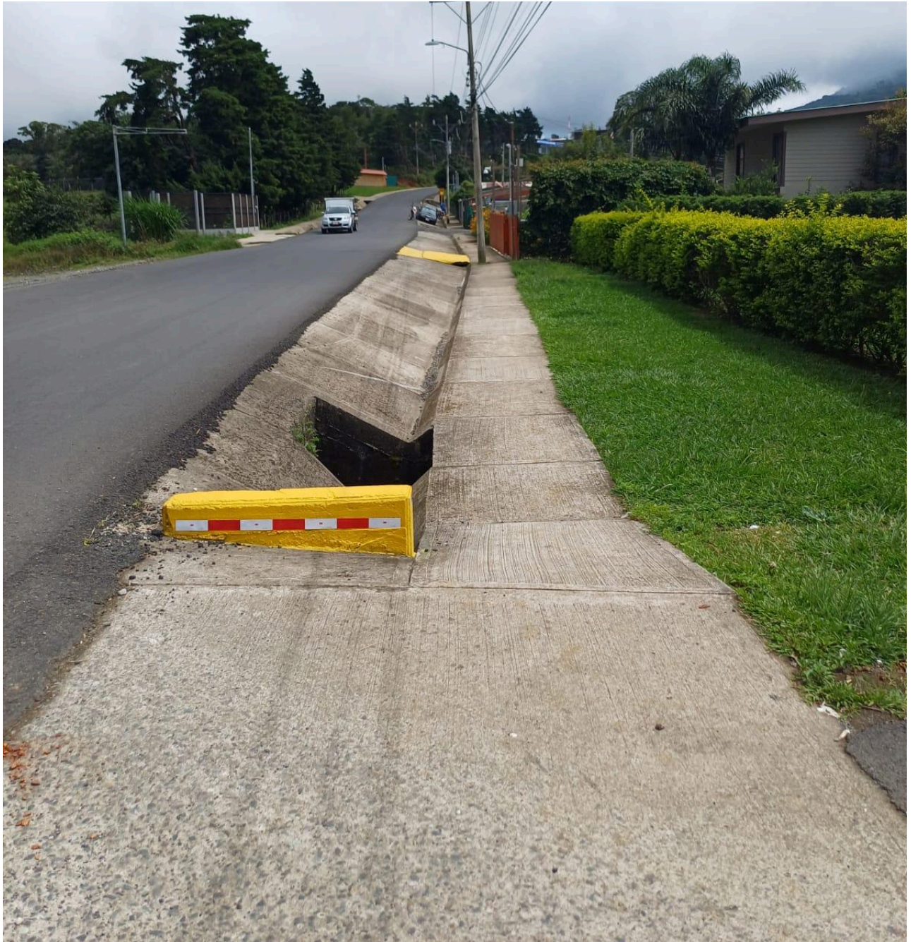
Figura 50. Acera sobre la RN-606 urbanización la Colina 1.
