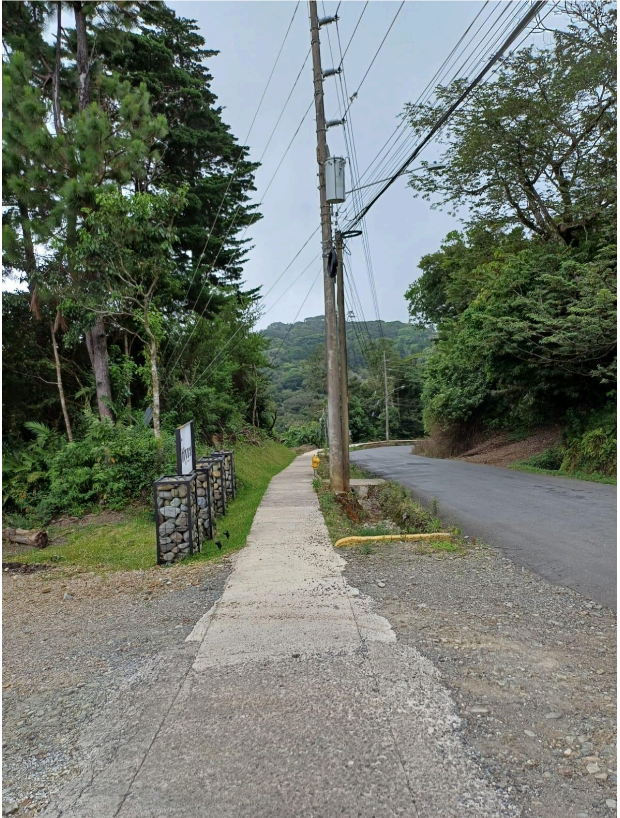
Figura 101. Acera sobre la RN 606 Don Juan - Trapiche 5.
