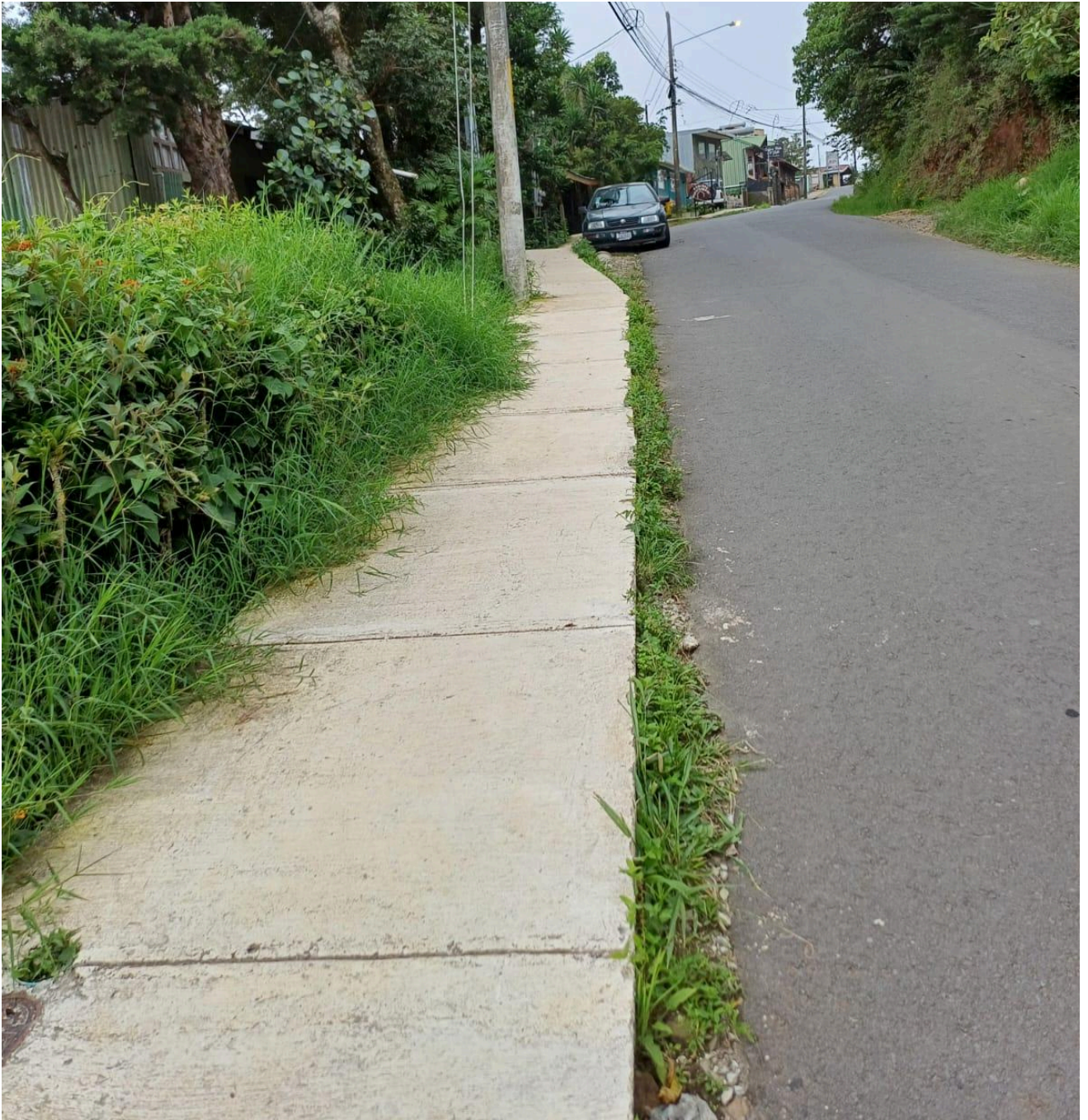
Figura 137. Acera sobre RC 612023 casa de Patricia Jimenez 1.
