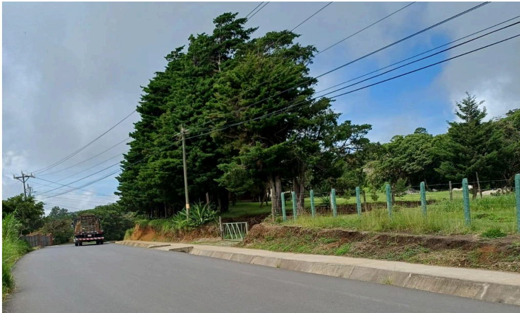
Figura 54. Acera sobre la RN-606 barrio Las Orquídeas 1.
