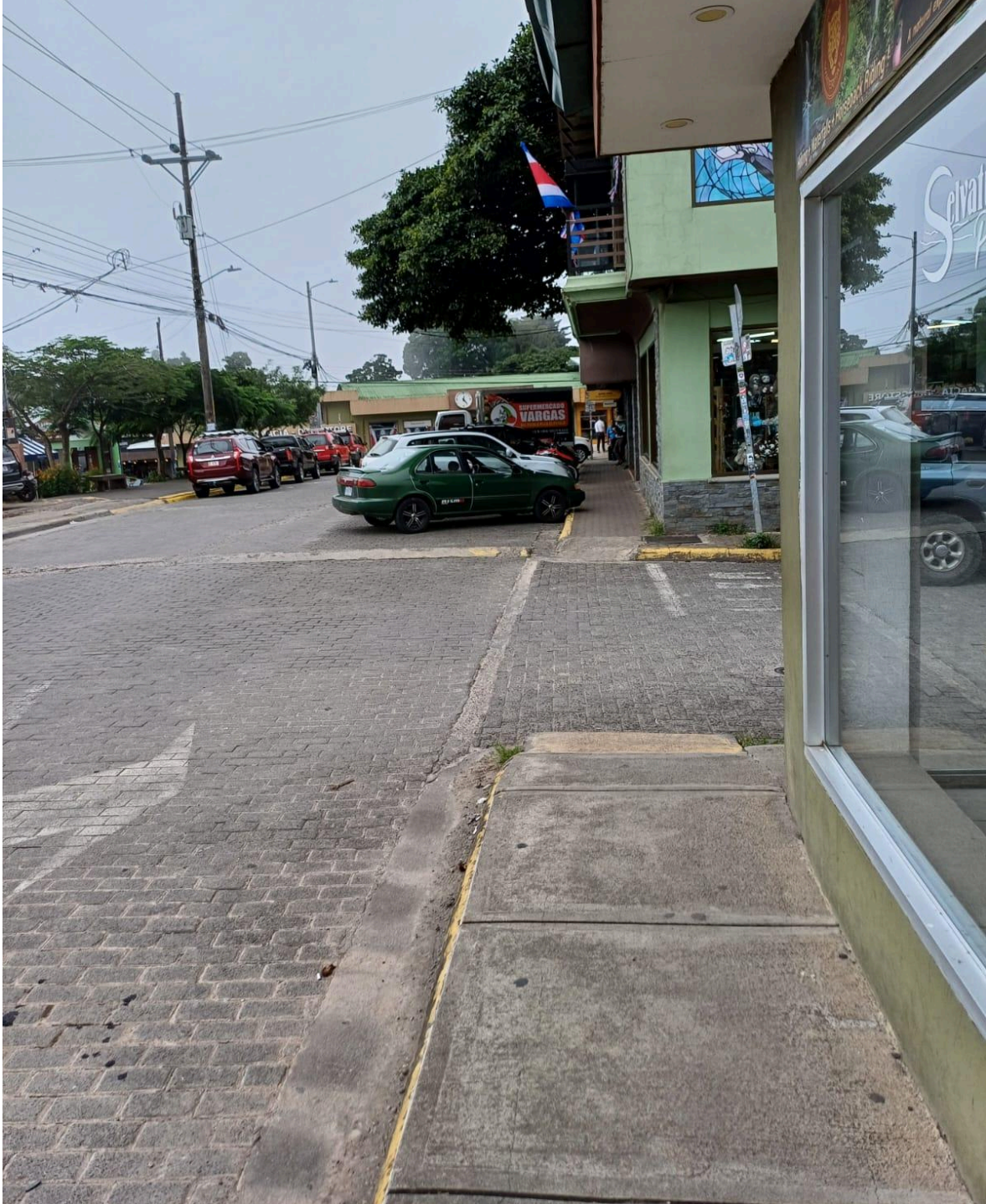
Figura 68. Acera sobre la RC-612040 Santa Elena centro 3.
