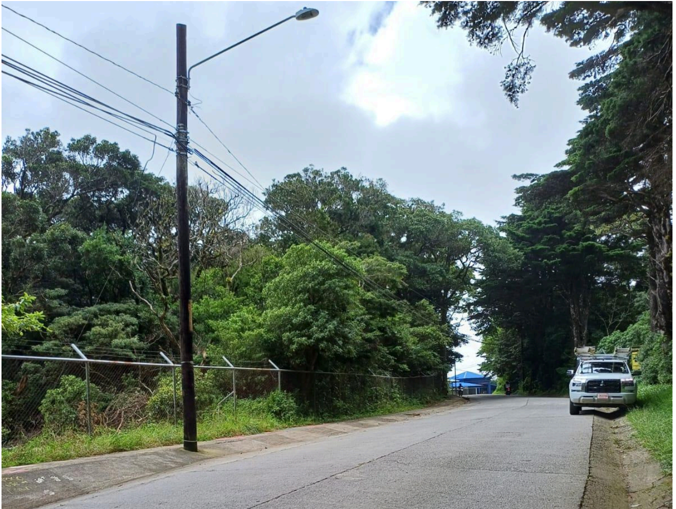
Figura 114. Acera sobre RC 612018 de la escuela Santa Elena al EBAIS Monteverde 2.
