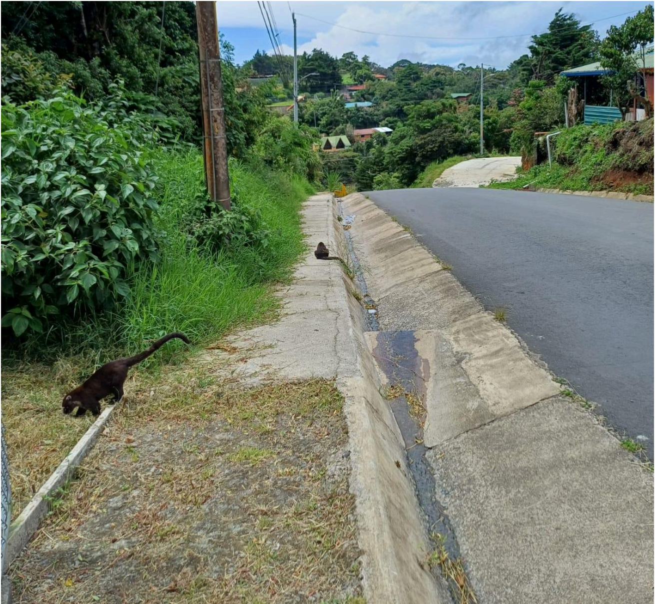
Figura 167. Acera sobre RC 612032 tanque de agua barrio El Sapo.
