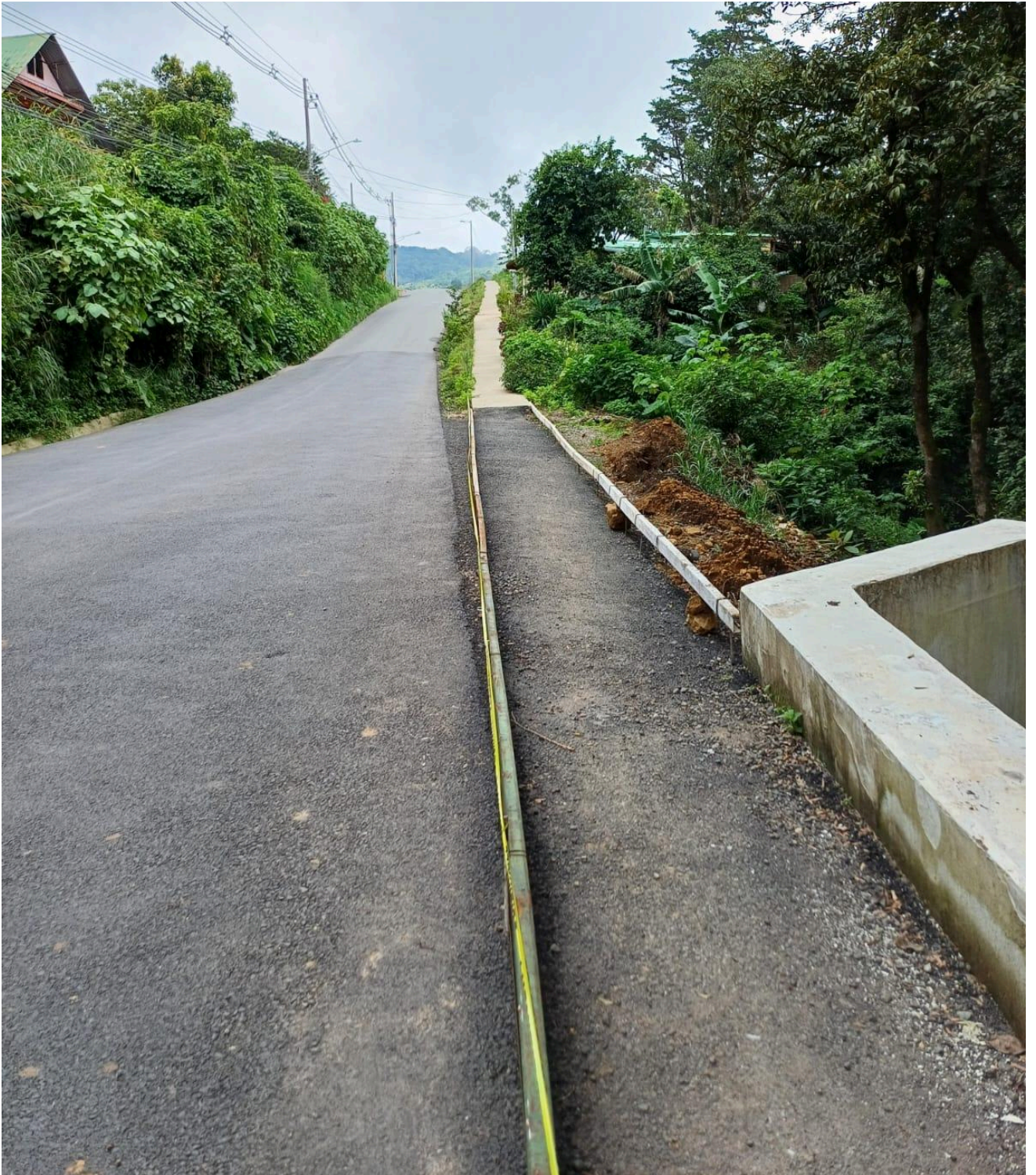
Figura 89. Acera en construcción sobre la RN 606 paso de alcantarilla quebrada intermitente.
