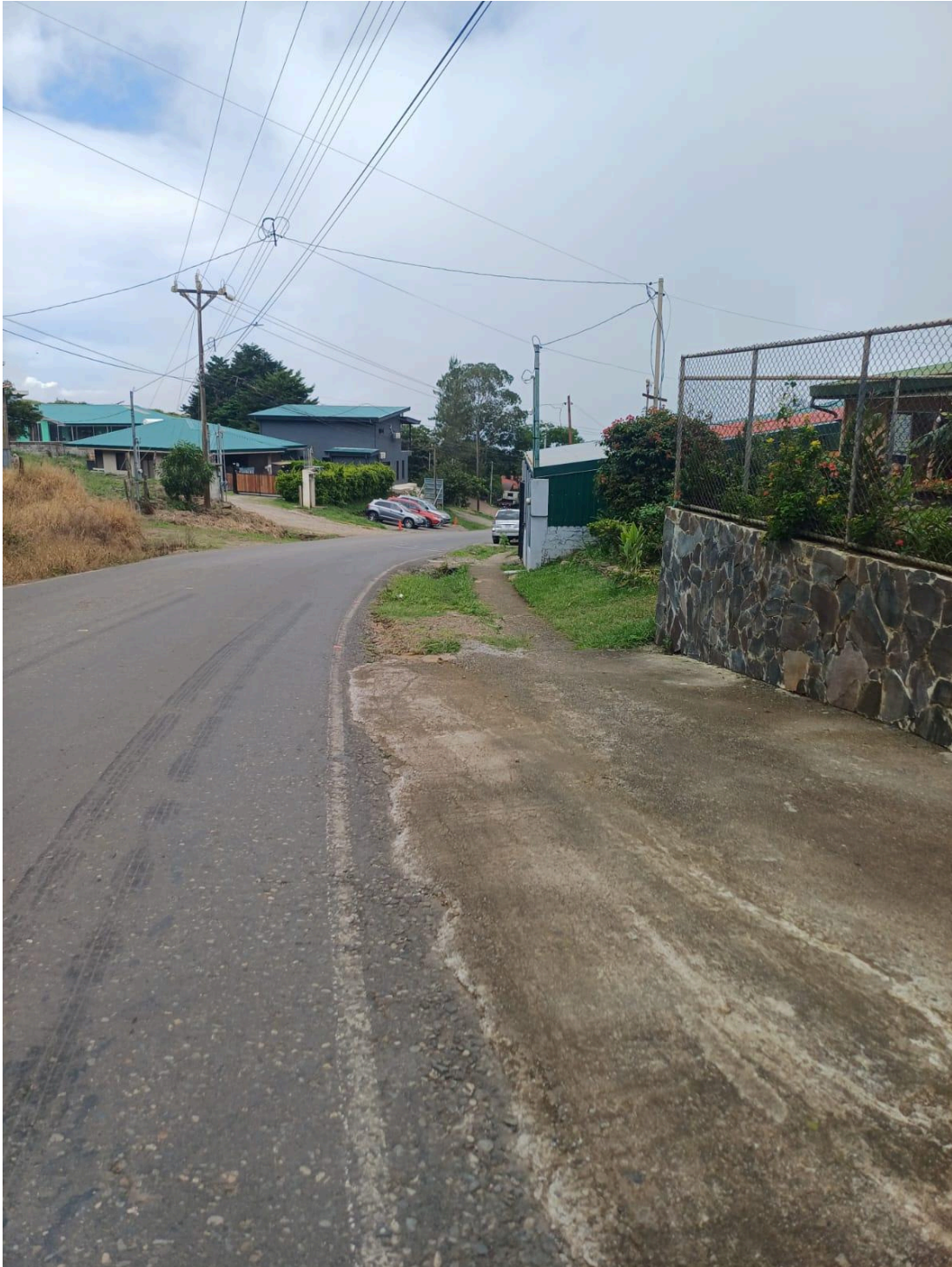
Figura 42. Acera sobre la RN-606 escuela de los Llanos OIJ 1.
