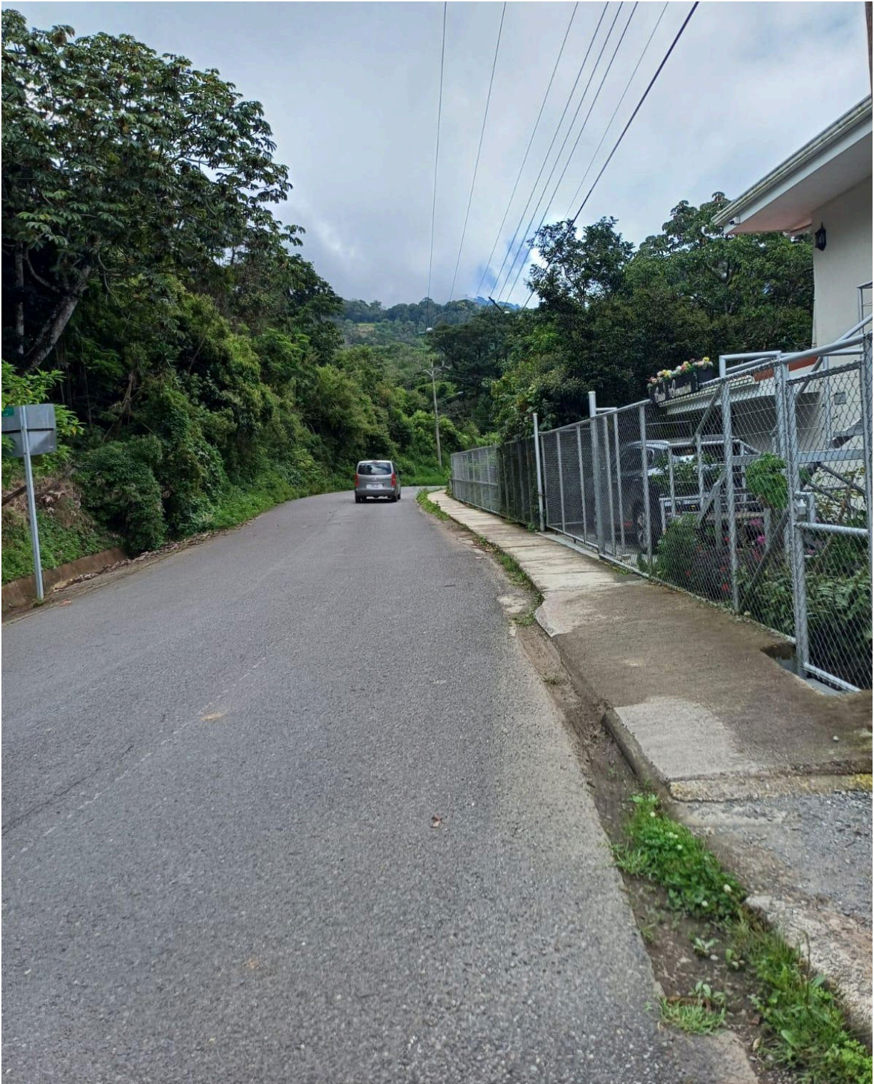
Figura 143. Acera sobre la RN 620 entronque con la RN 606.
