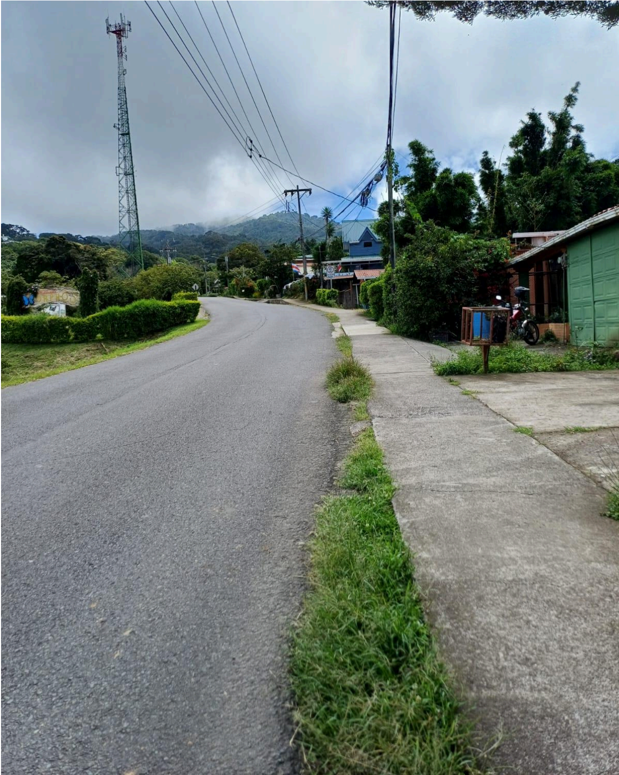
Figura 154. Acera sobre RN 620 la Torre Cerro Plano.
