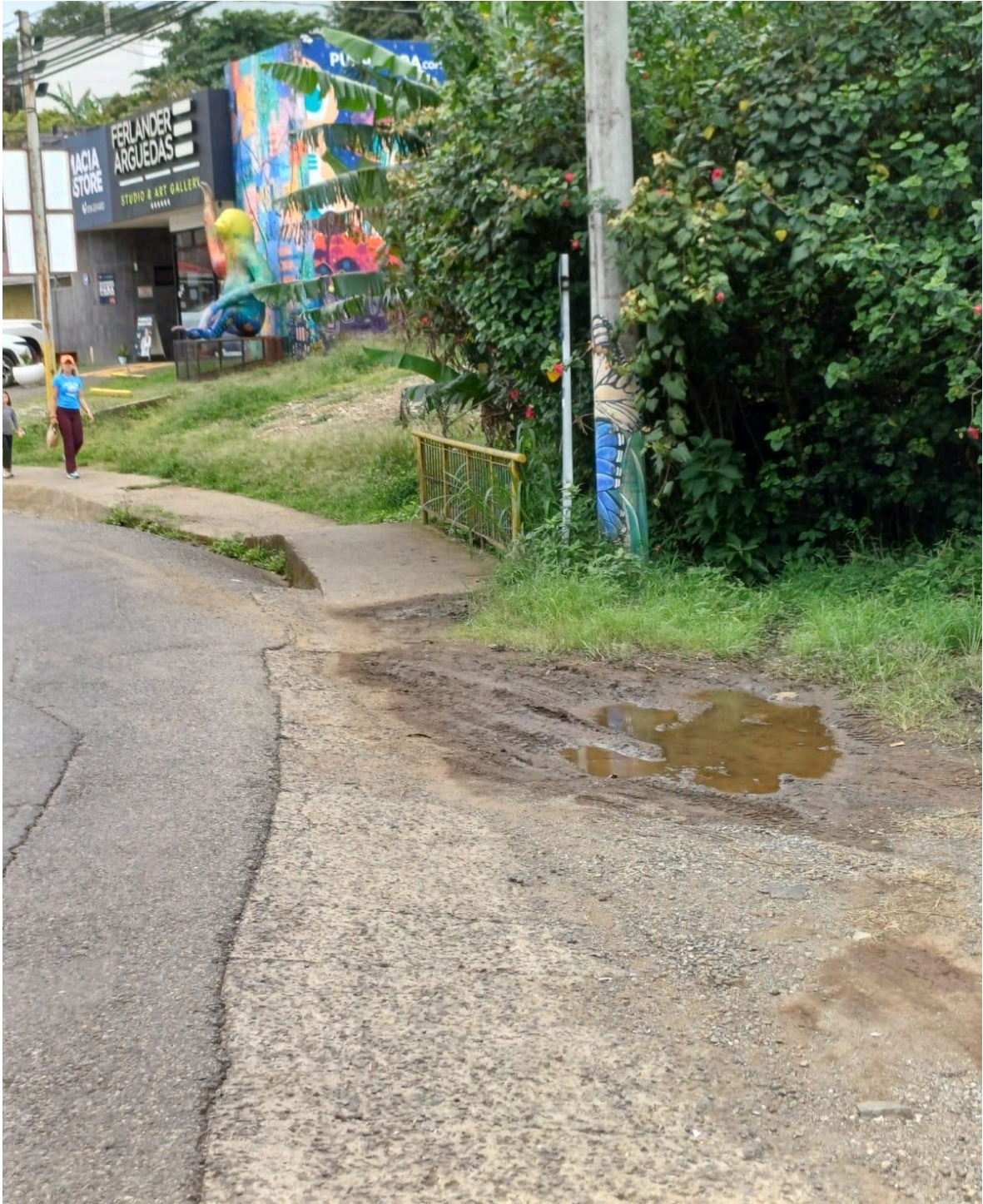
Figura 161. Puente peatonal sobre RC 612038 Santa Elena quebrada intermitente 1.
