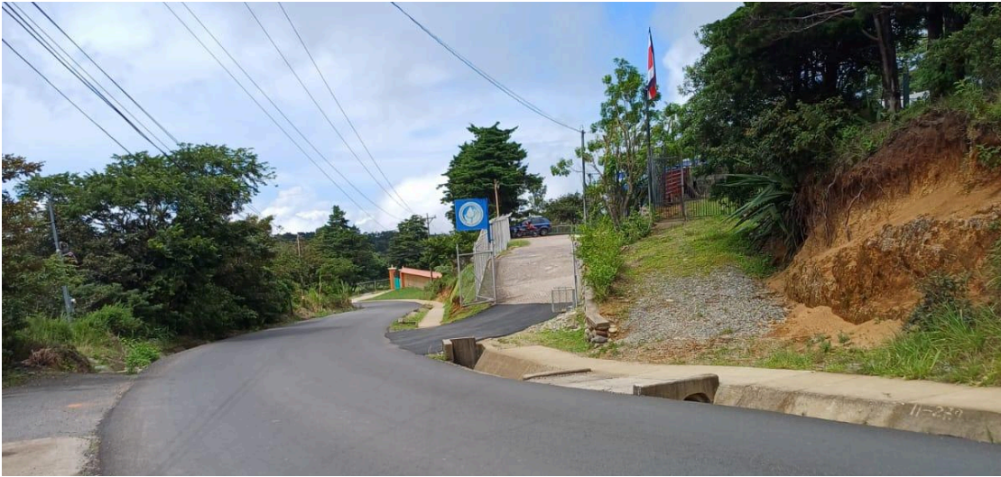
Figura 53. Acera sobre la RN-606 ASADA de Santa Elena.
