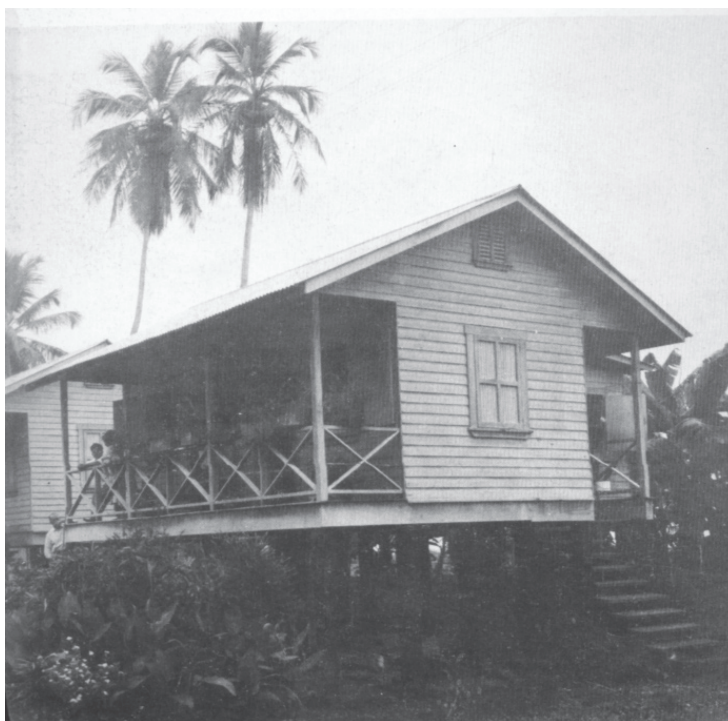
Figura 2.17. Casas a orilla de la línea en Moín.
