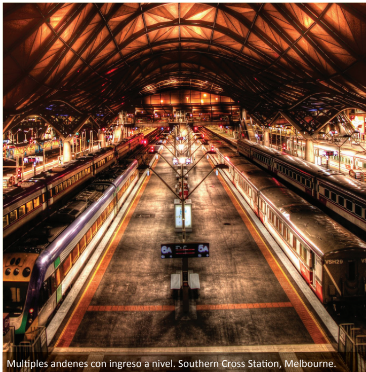
Figura 2.6. Múltiples andenes con ingreso a nivel. Southern Cross Station, Melbourne.
