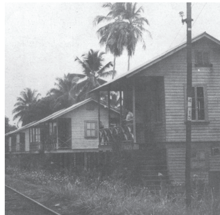
Figura 2.18. Casas a orilla de la línea en Moín.
