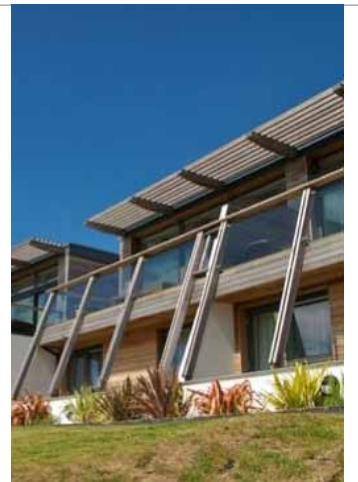
Imagen 4.3.36. Aleros y protección solar.
