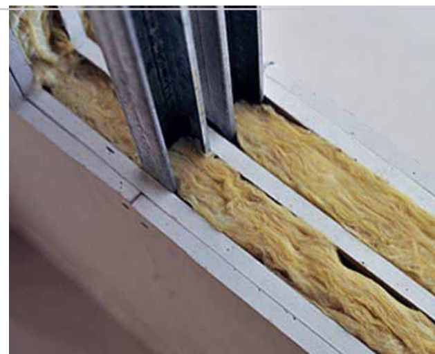
Imagen 3.3.35. Aislamiento acústico para paredes livianas de doble forro y aislante interno. Laminas de Gypsum de 5/8 de pulgada. STC=57.
