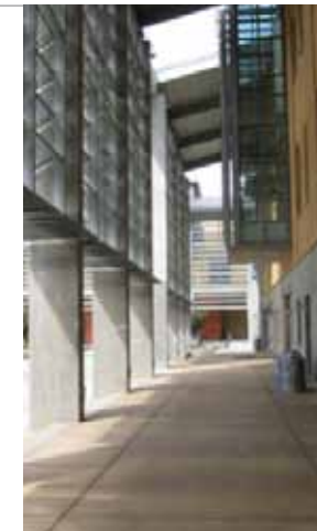
Imagen 4.3.35. Aleros y protección solar.
