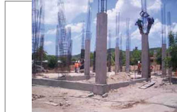
Concreto armado en cimentaciones, columnas y vigas. Imagen 5.4.18.
