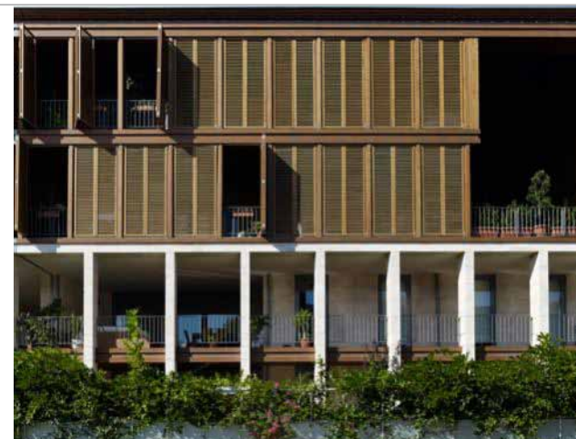
Imagen 4.3.32. Iluminación y protección solar.
