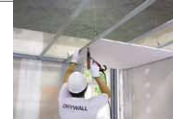
Cielos en Gypsum o Densglass. Imagen 5.4.24.
